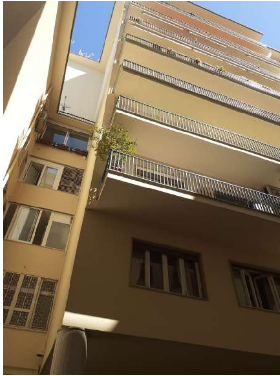
Foto 01 Facciata lato corte interna scala B
