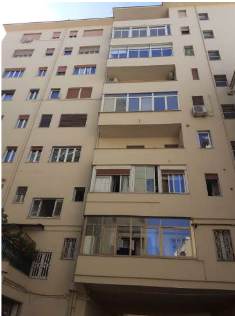
Foto 02 Facciata lato corte interna
