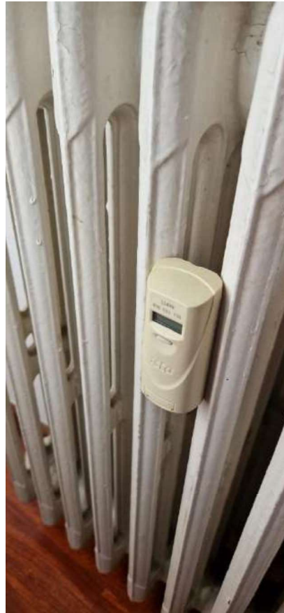
Vista del sistema di contabilizzazione e regolazione dell'impianto termico
