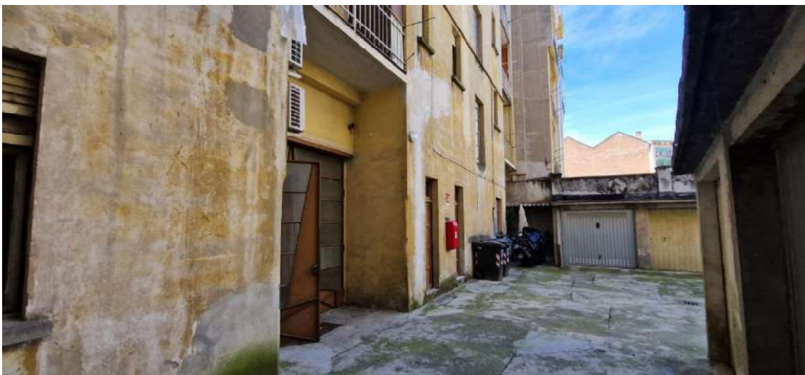
Viste dell'area cortilizia interna
