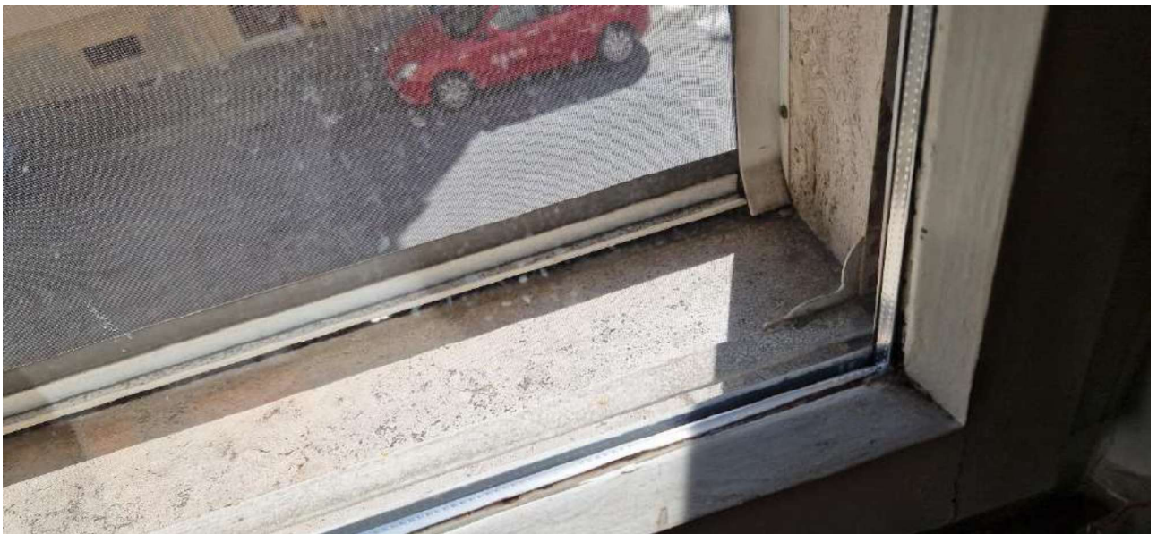
Vista dei serramenti in legno
