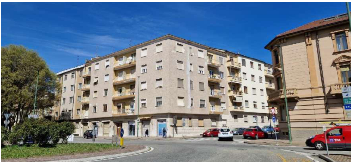
Vista complessiva del condominio
