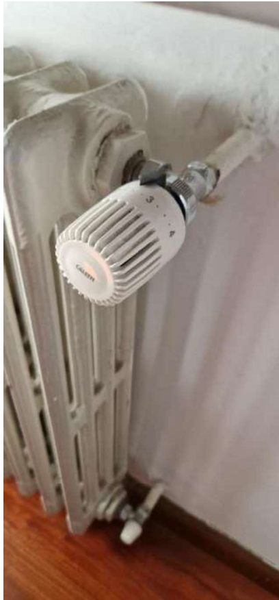
Vista del sistema di contabilizzazione e regolazione dell'impianto termico
