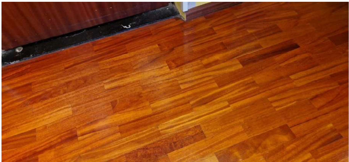
Pavimento in legno
