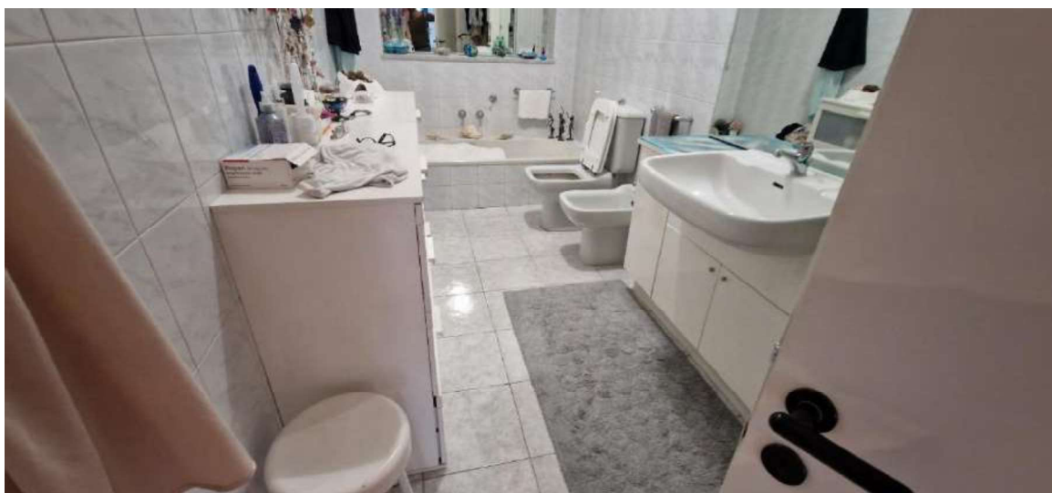
Pavimentazione bagno ad Ovest
