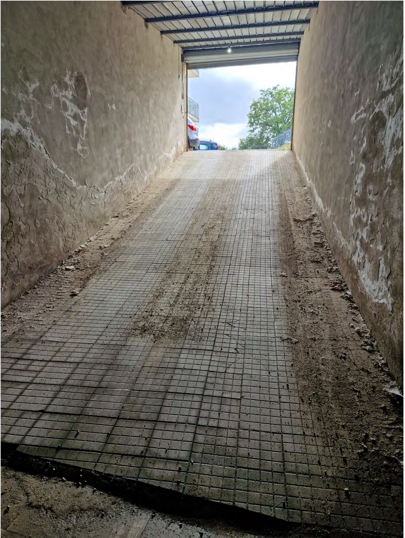
rampa di accesso che conduce al piano S1
