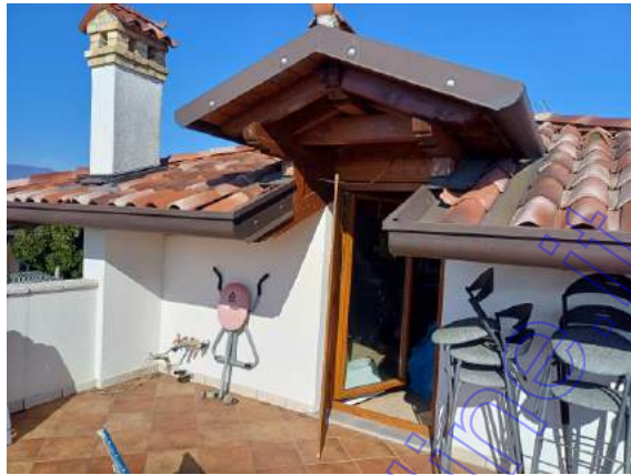
Accesso alla terrazza dalla soffitta
