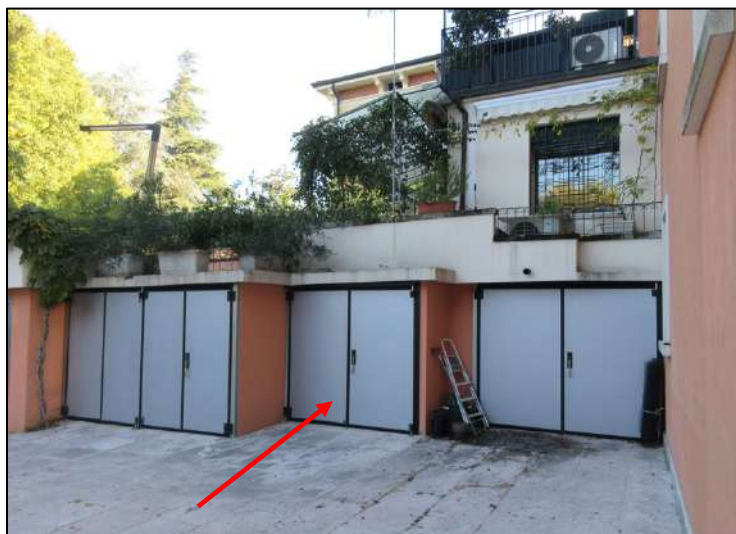
foto dell'autorimessa dal cortile interno
