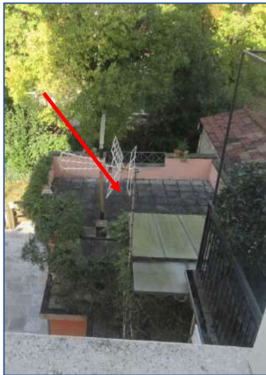
lastrico solare sub 19
