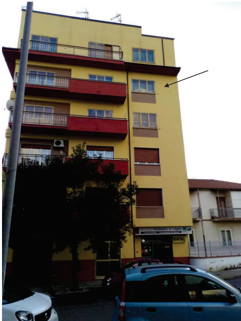
Vista Via Coscile – ingresso fabbricato
