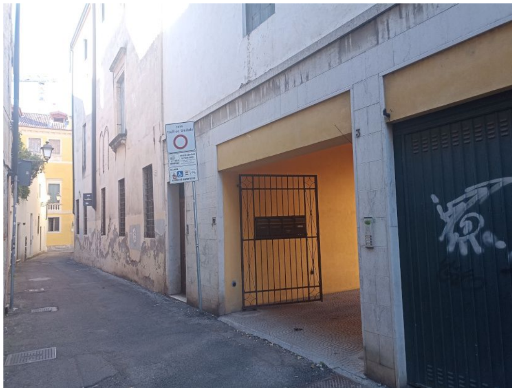
Foto 7 – entrata da Stradella degli Stalli
