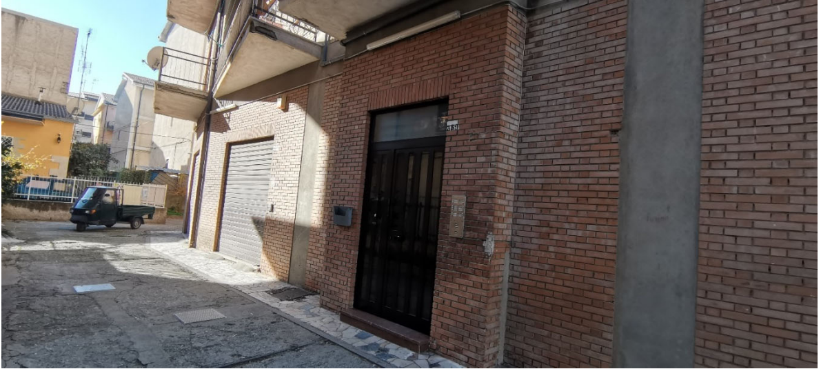
Esterno – Portone d'ingresso all'immobile in oggetto
