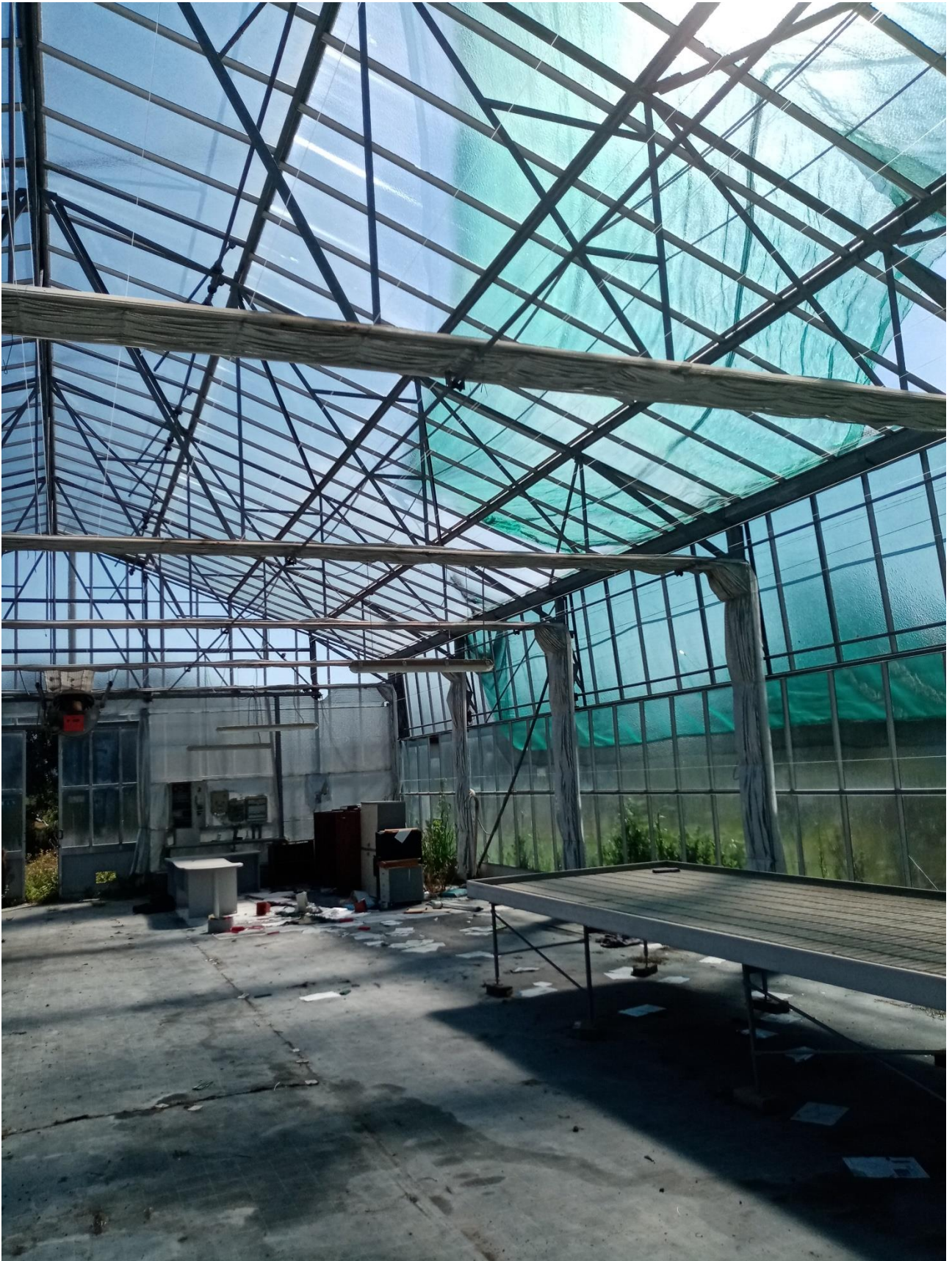
IMMAGINE N.36 CAPANNONE SERRA INTERNO
