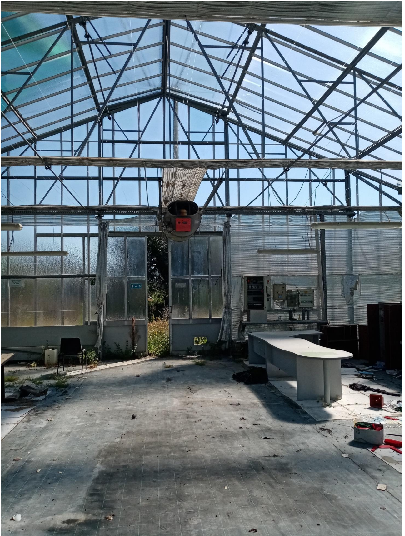
IMMAGINE N.31 CAPANNONE SERRA INTERNO
