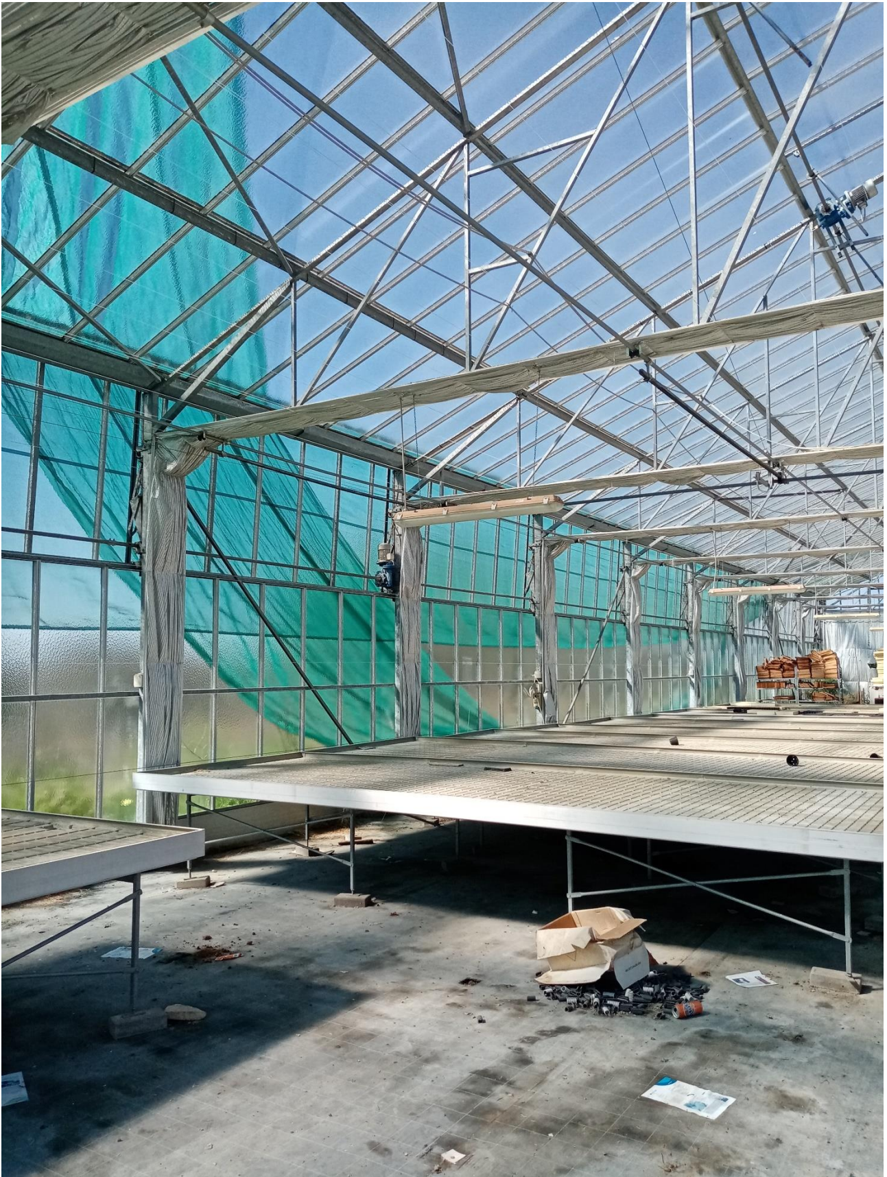
IMMAGINE N.34 CAPANNONE SERRA INTERNO
