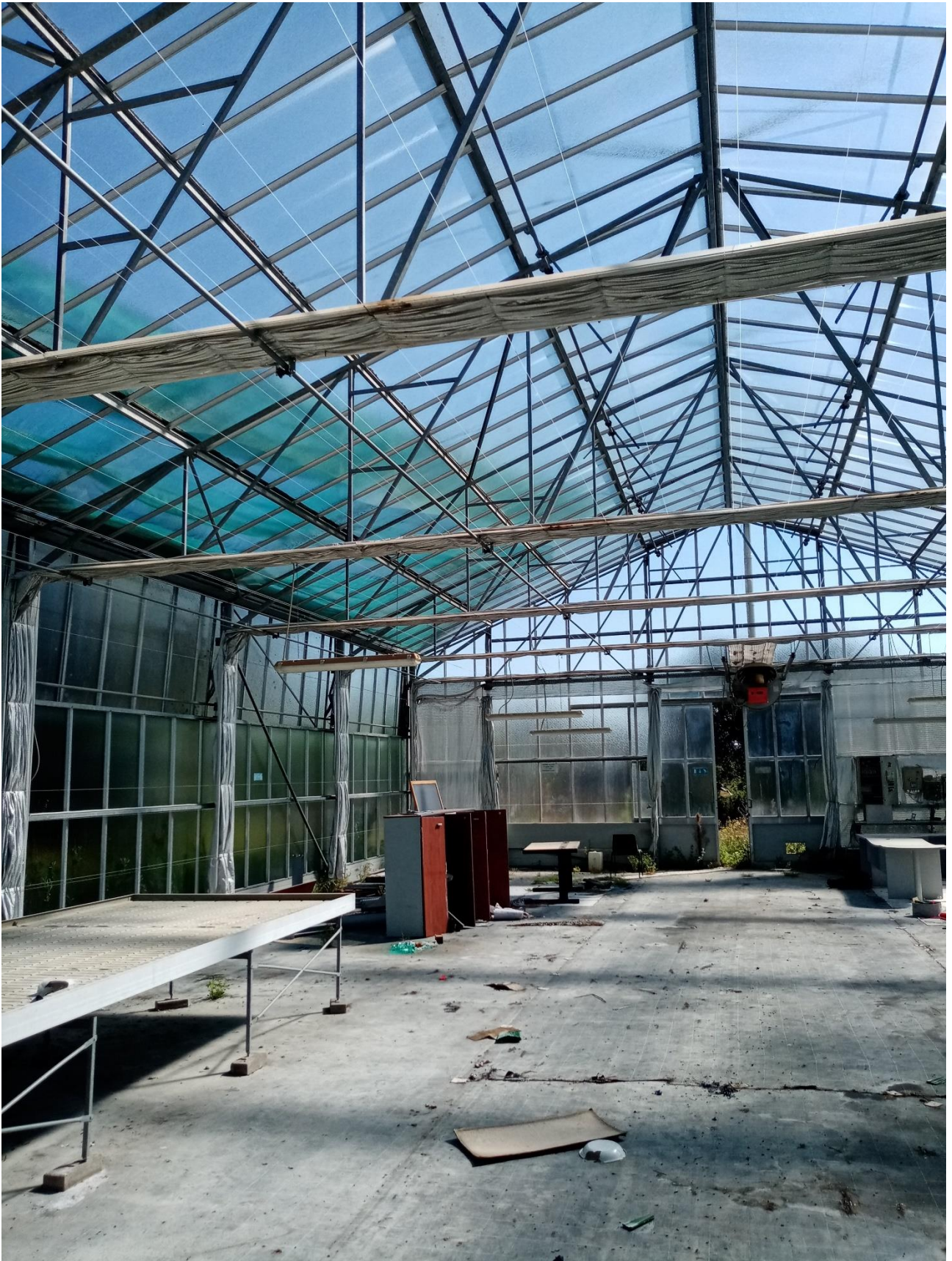
IMMAGINE N.37 CAPANNONE SERRA INTERNO
