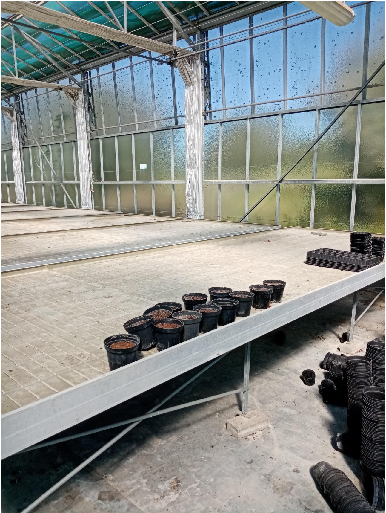
IMMAGINE N.38 CAPANNONE SERRA INTERNO
