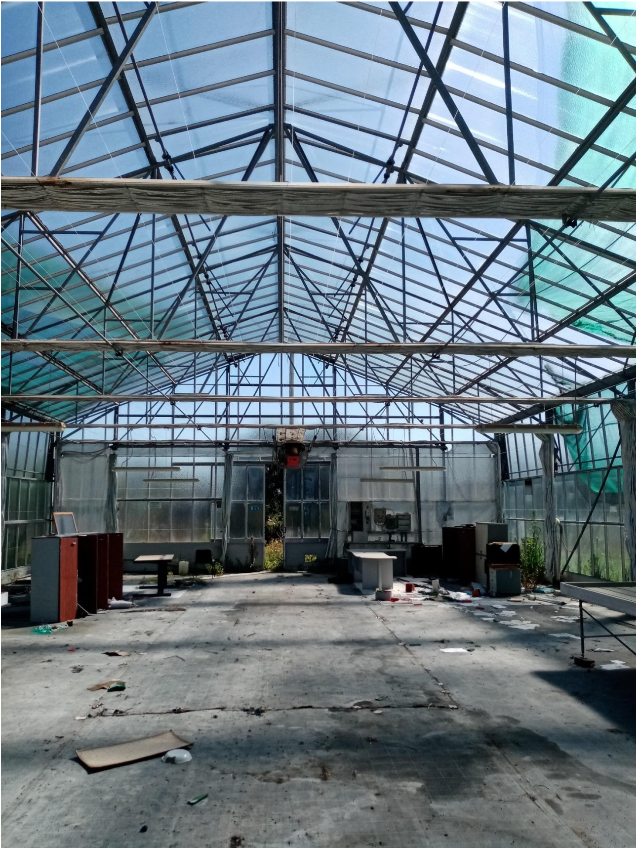
IMMAGINE N.35 CAPANNONE SERRA INTERNO
