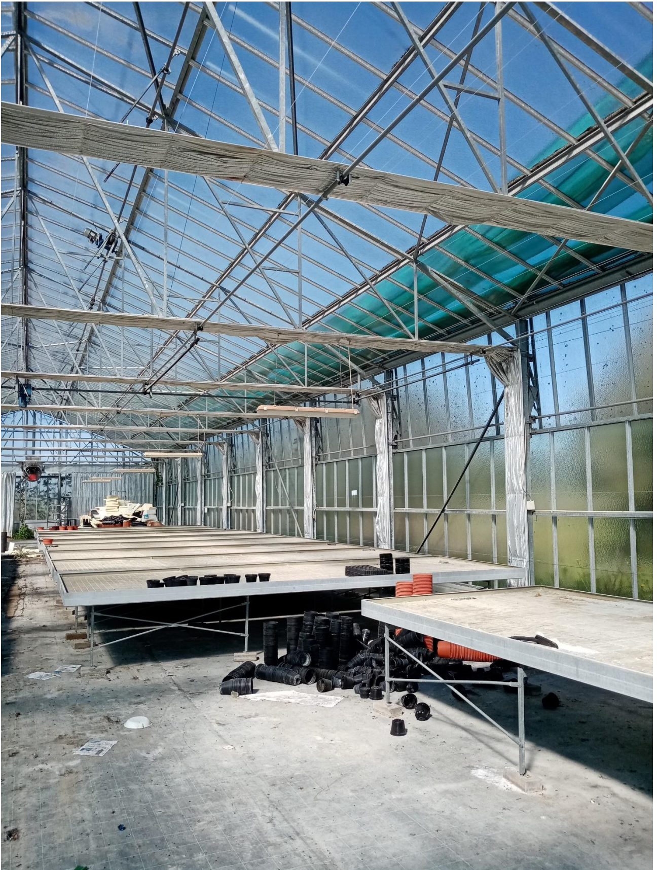
IMMAGINE N.32 CAPANNONE SERRA INTERNO
