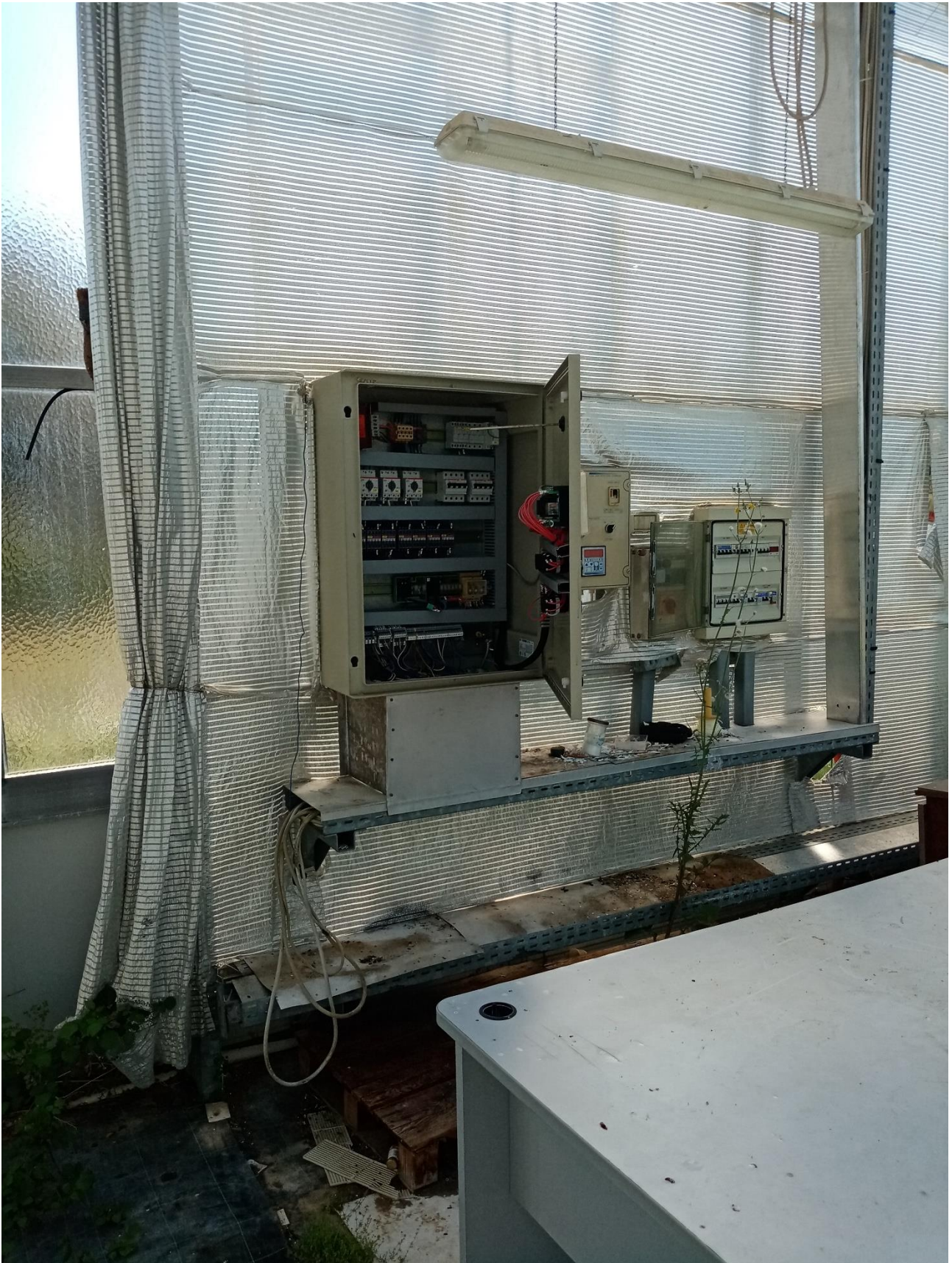
IMMAGINE N.40 CAPANNONE SERRA INTERNO
