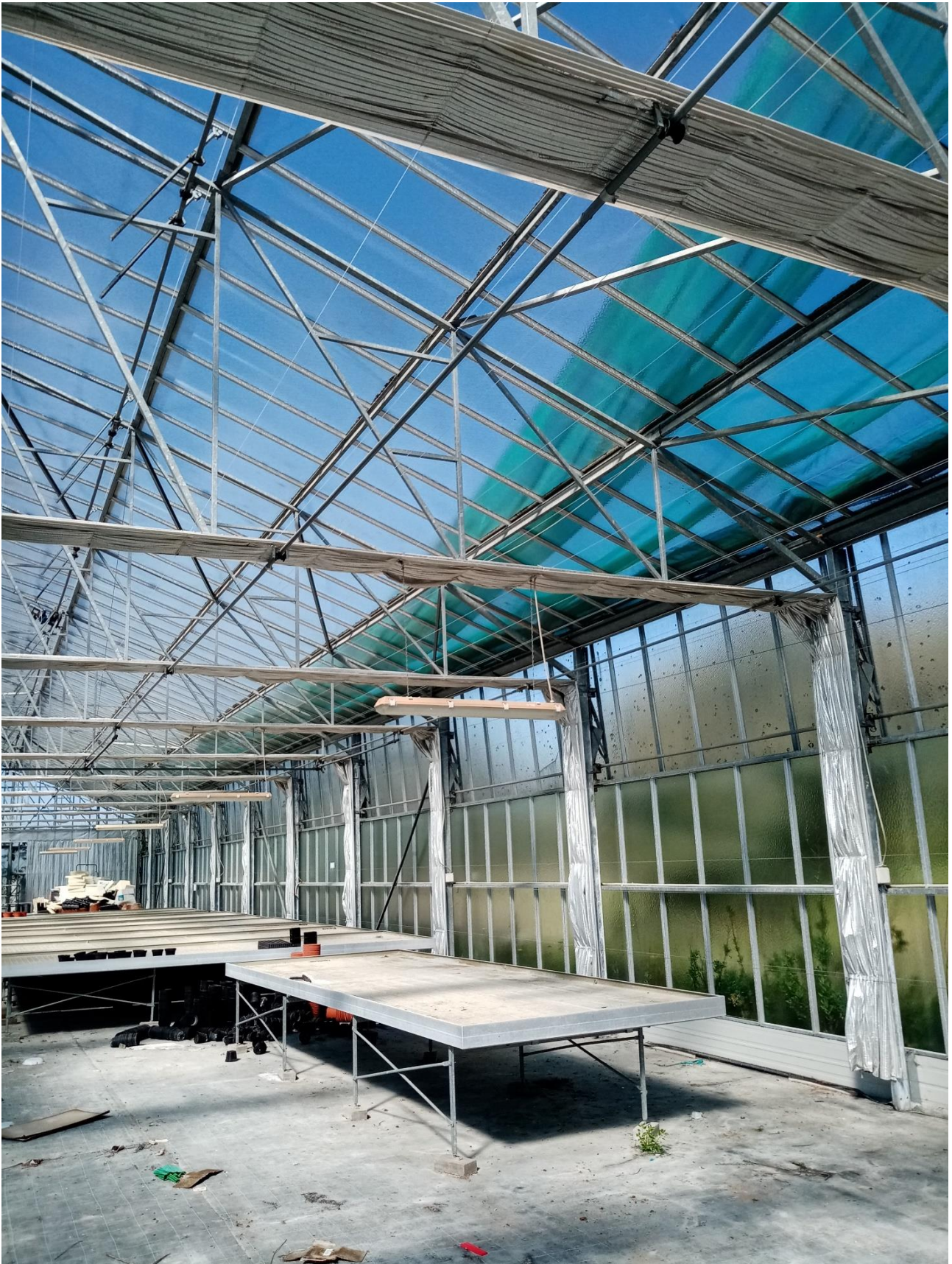
IMMAGINE N.29 CAPANNONE SERRA INTERNO
