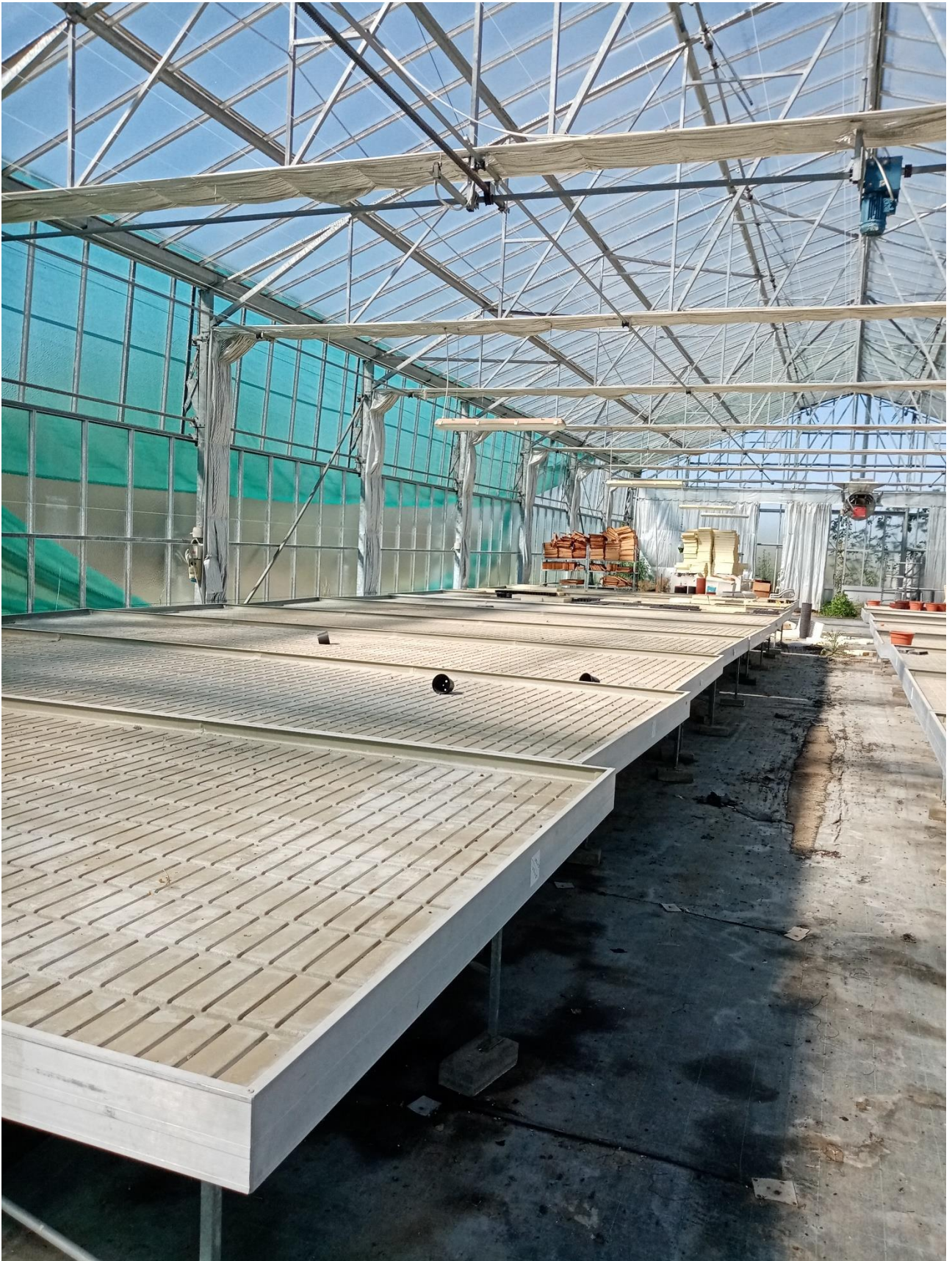
IMMAGINE N.39 CAPANNONE SERRA INTERNO
