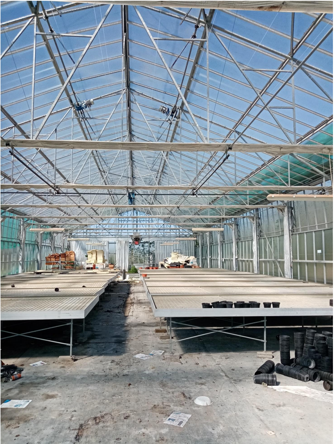
IMMAGINE N.33 CAPANNONE SERRA INTERNO
