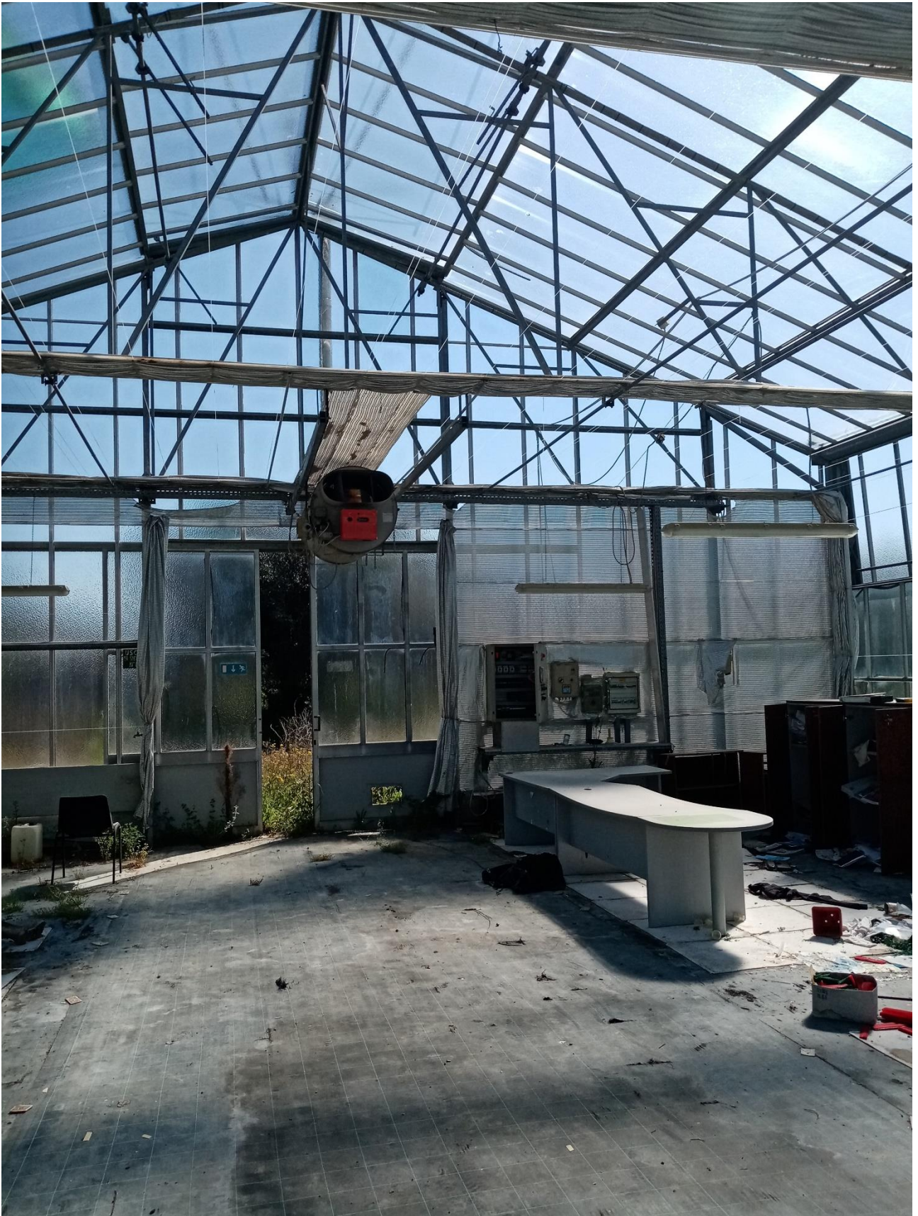
IMMAGINE N.30 CAPANNONE SERRA INTERNO
