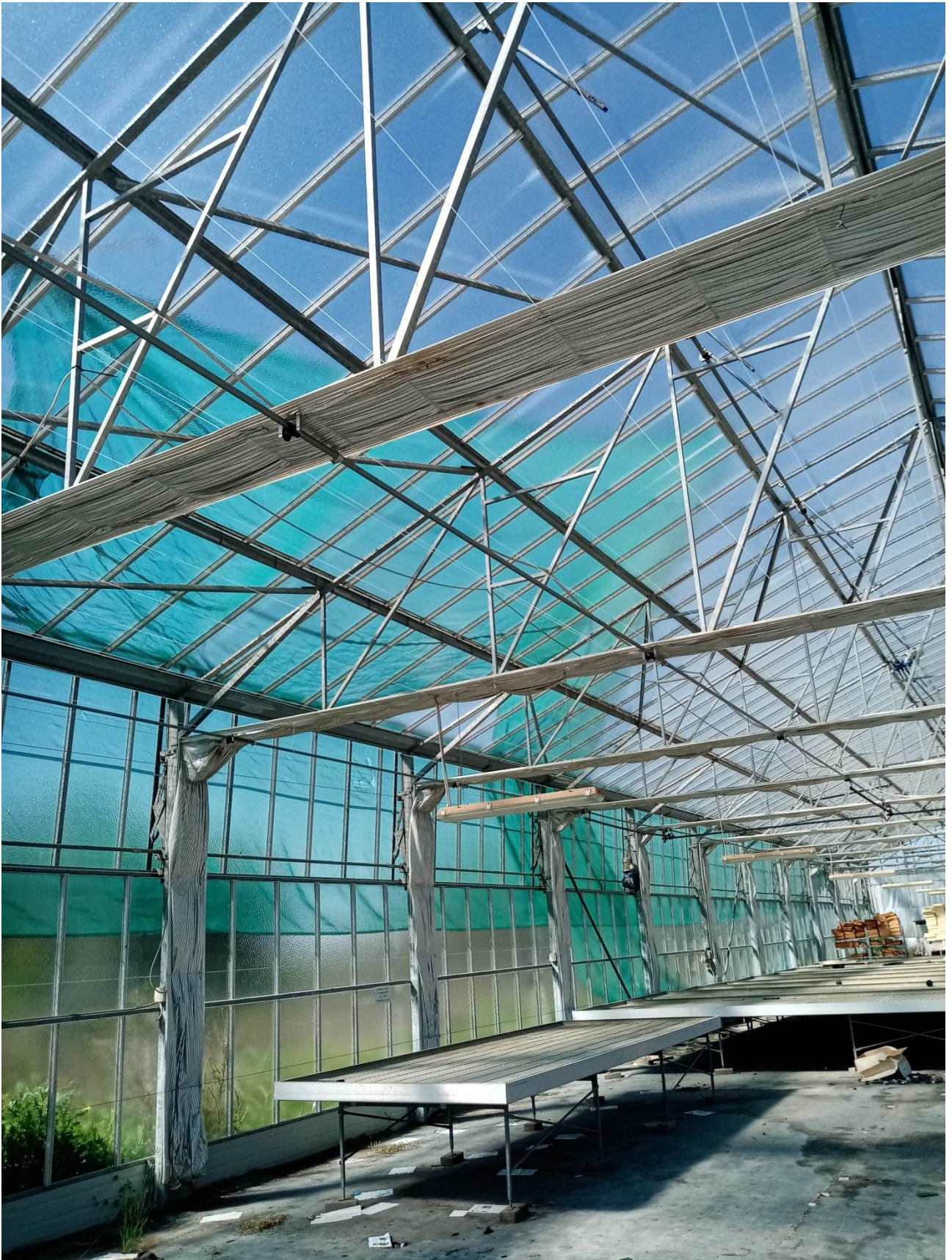
IMMAGINE N.28 CAPANNONE SERRA INTERNO
