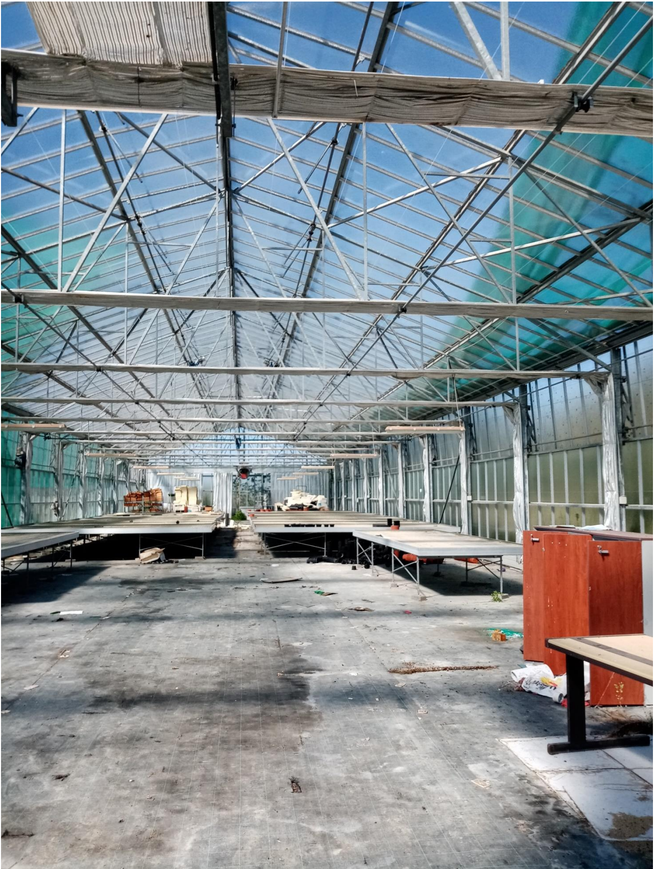
IMMAGINE N.25 CAPANNONE SERRA INTERNO
