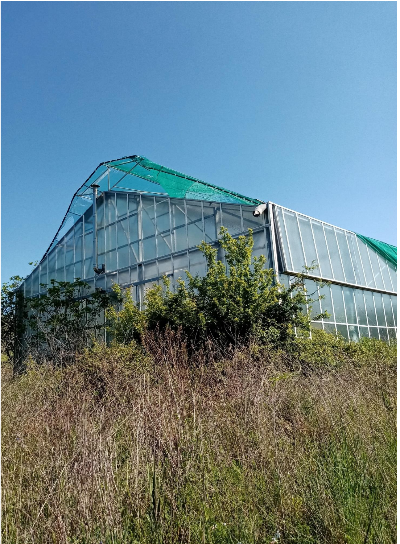
IMMAGINE N.14 CAPANNONE SERRA
