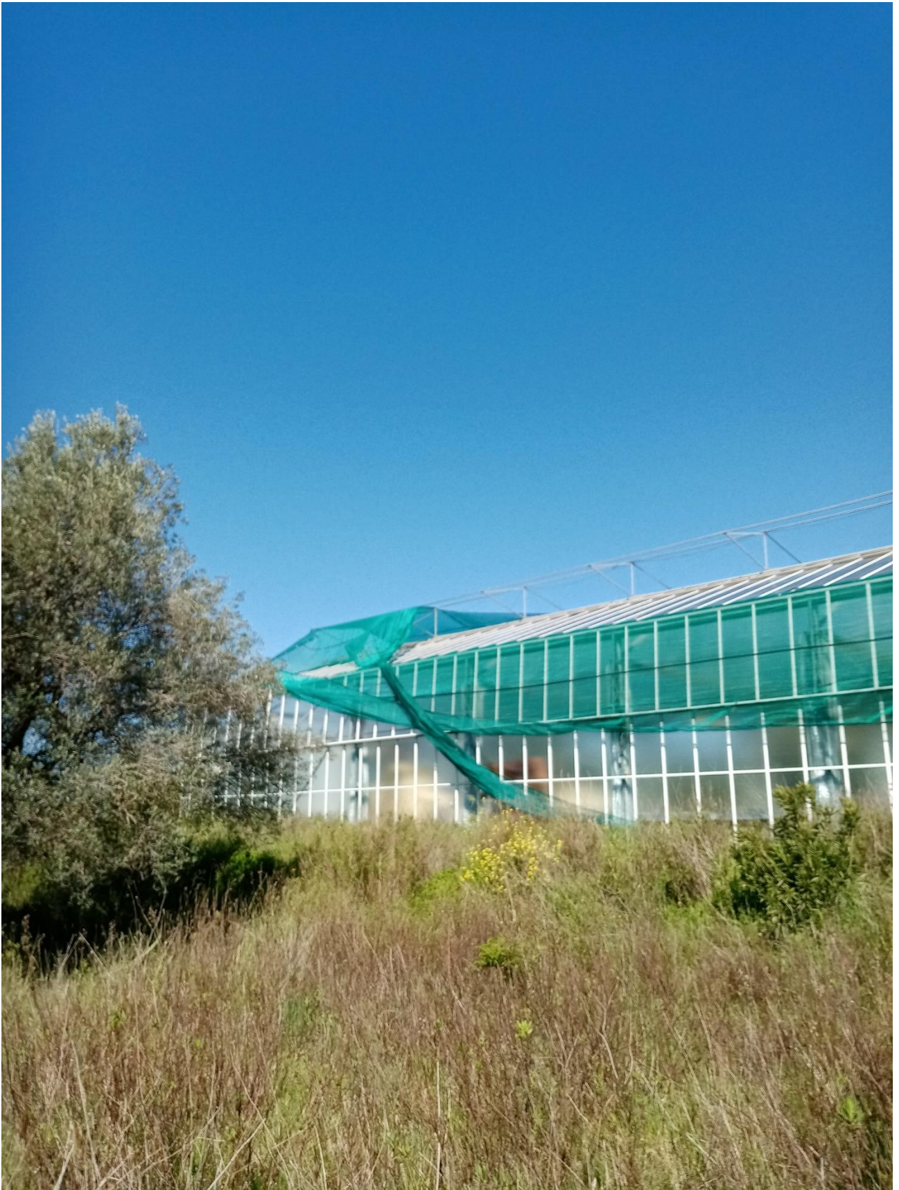
IMMAGINE N.7 CAPANNONE SERRA
