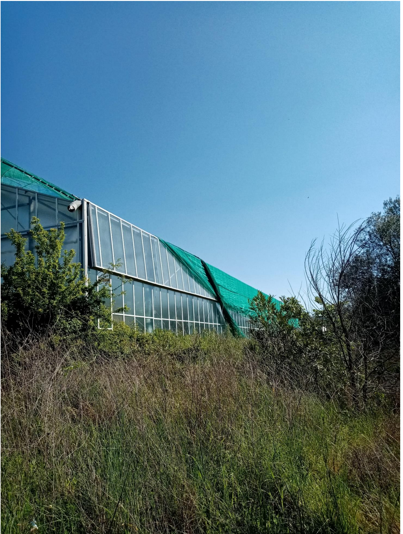
IMMAGINE N.15 CAPANNONE SERRA
