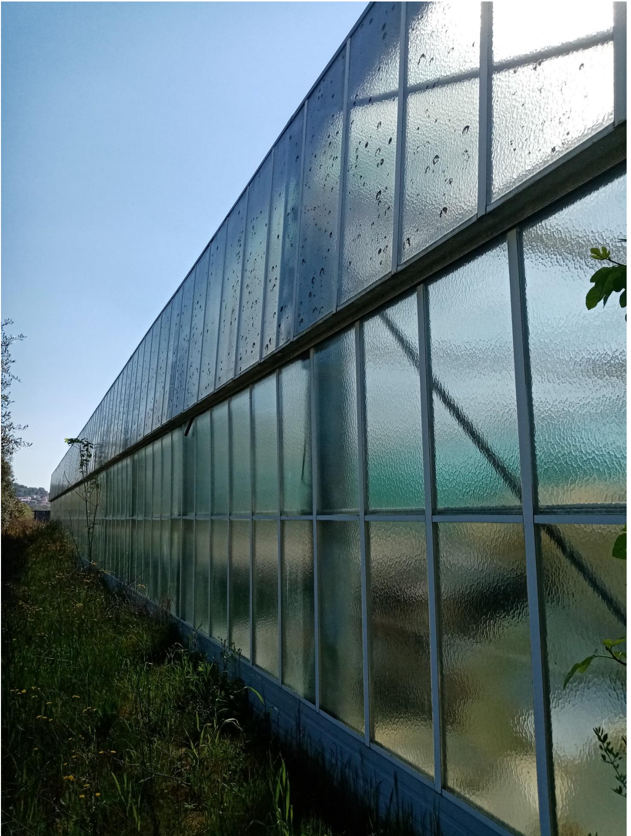
IMMAGINE N.20 CAPANNONE SERRA
