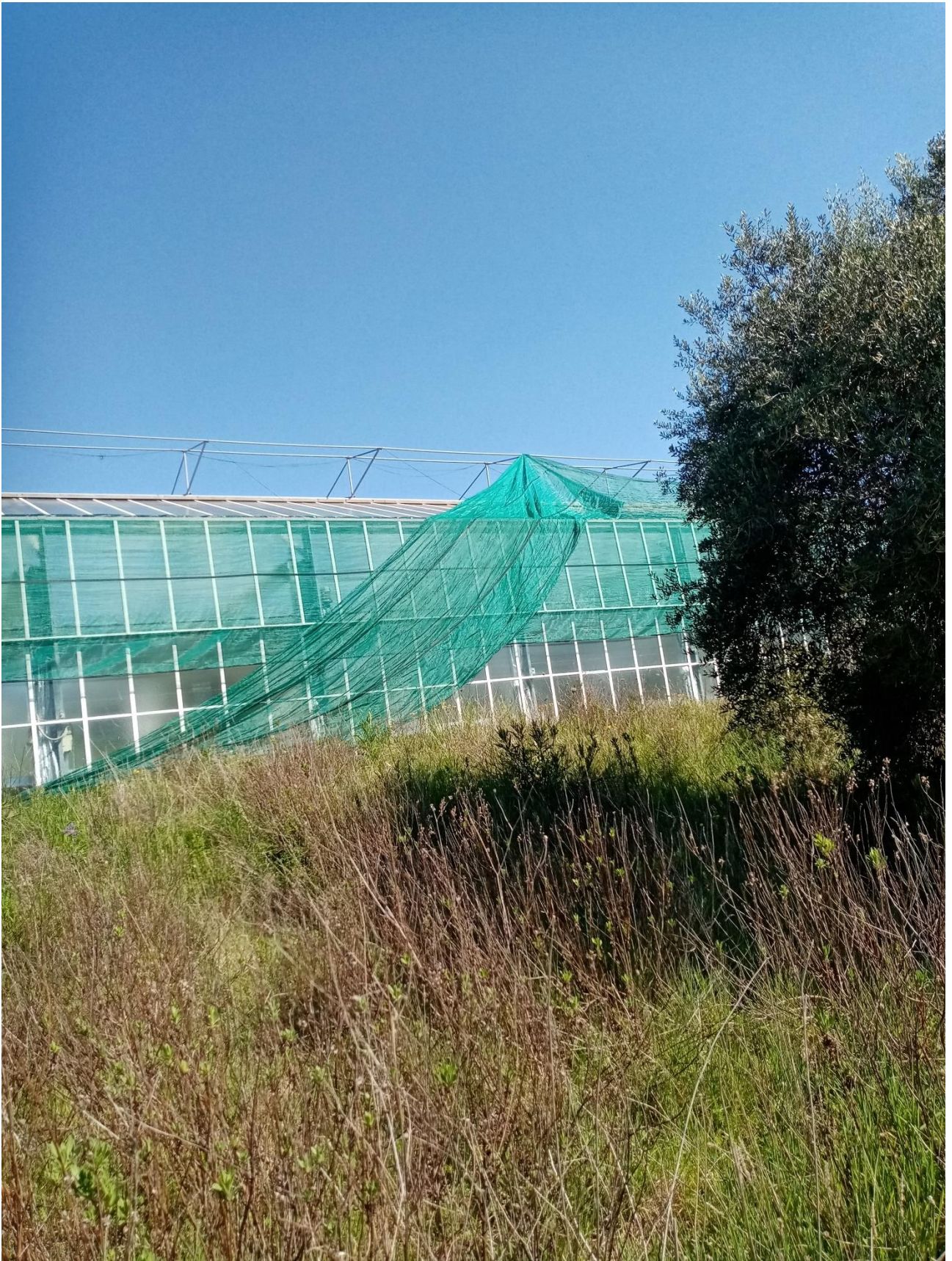
IMMAGINE N.8 CAPANNONE SERRA
