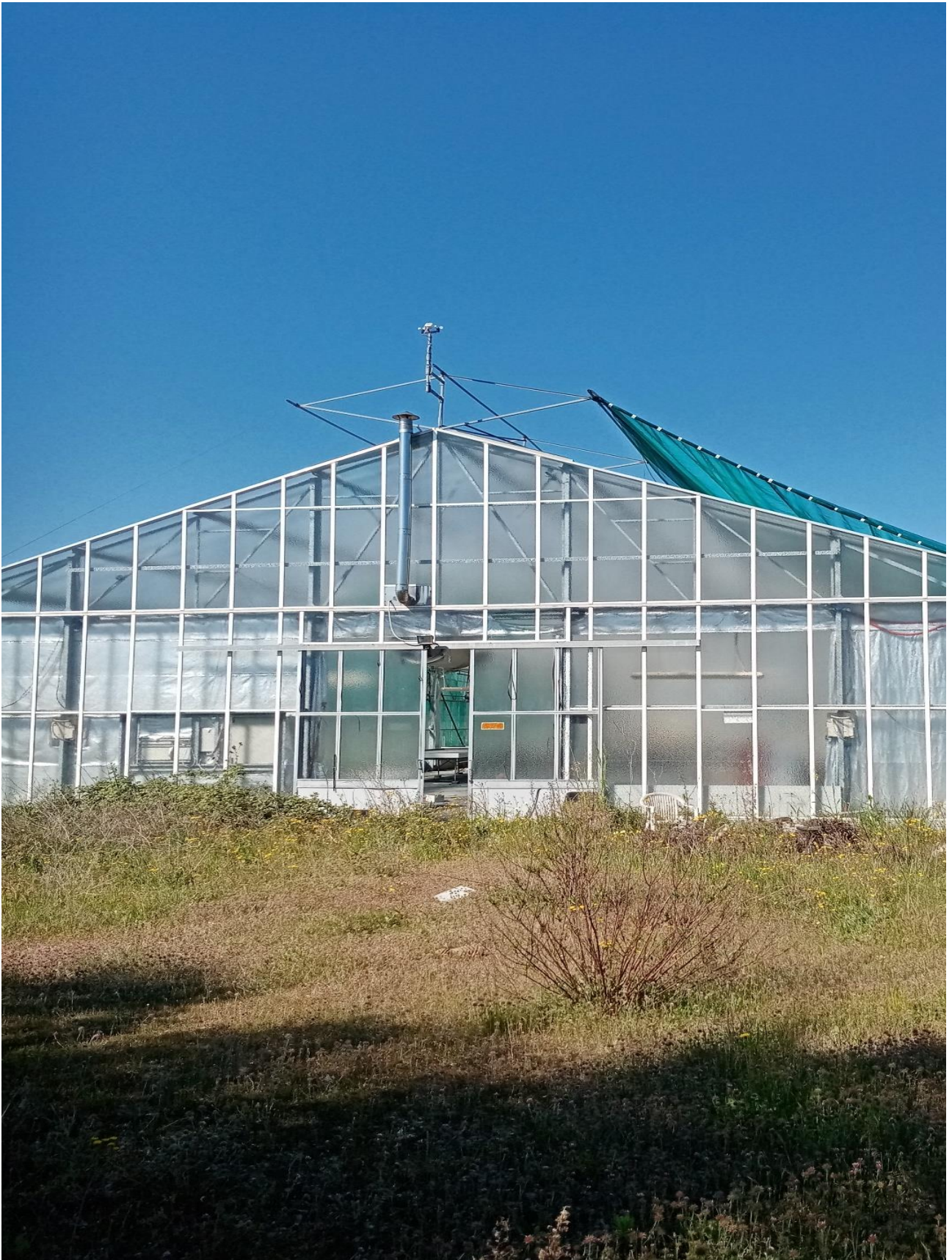
IMMAGINE N.2 CAPANNONE SERRA
