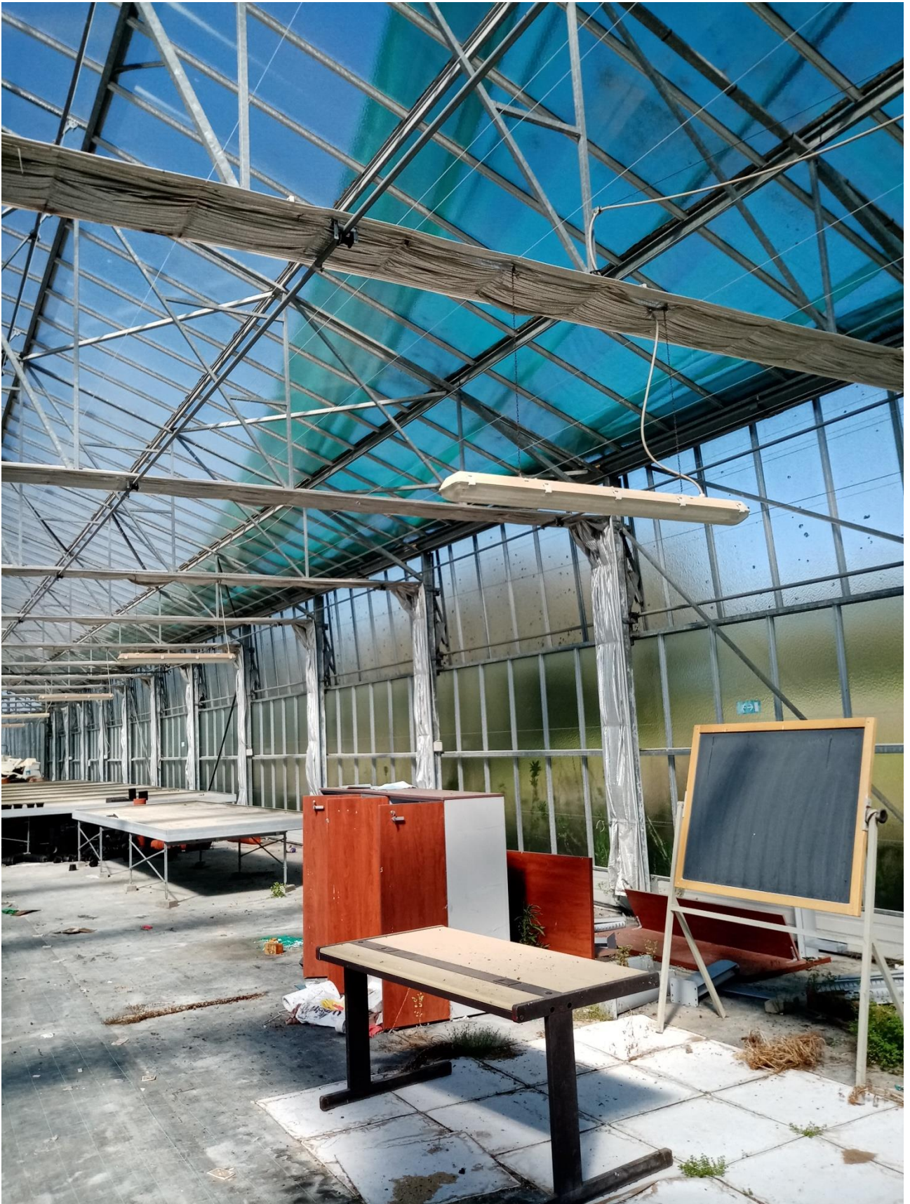
IMMAGINE N.27 CAPANNONE SERRA INTERNO
