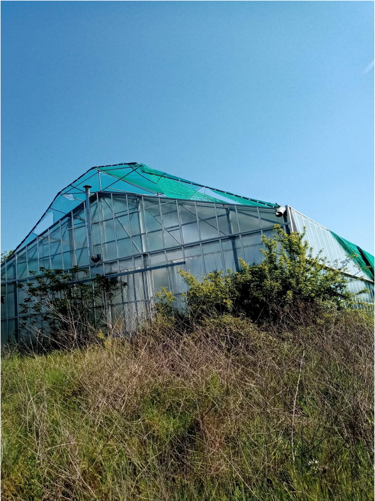
IMMAGINE N.16 CAPANNONE SERRA
