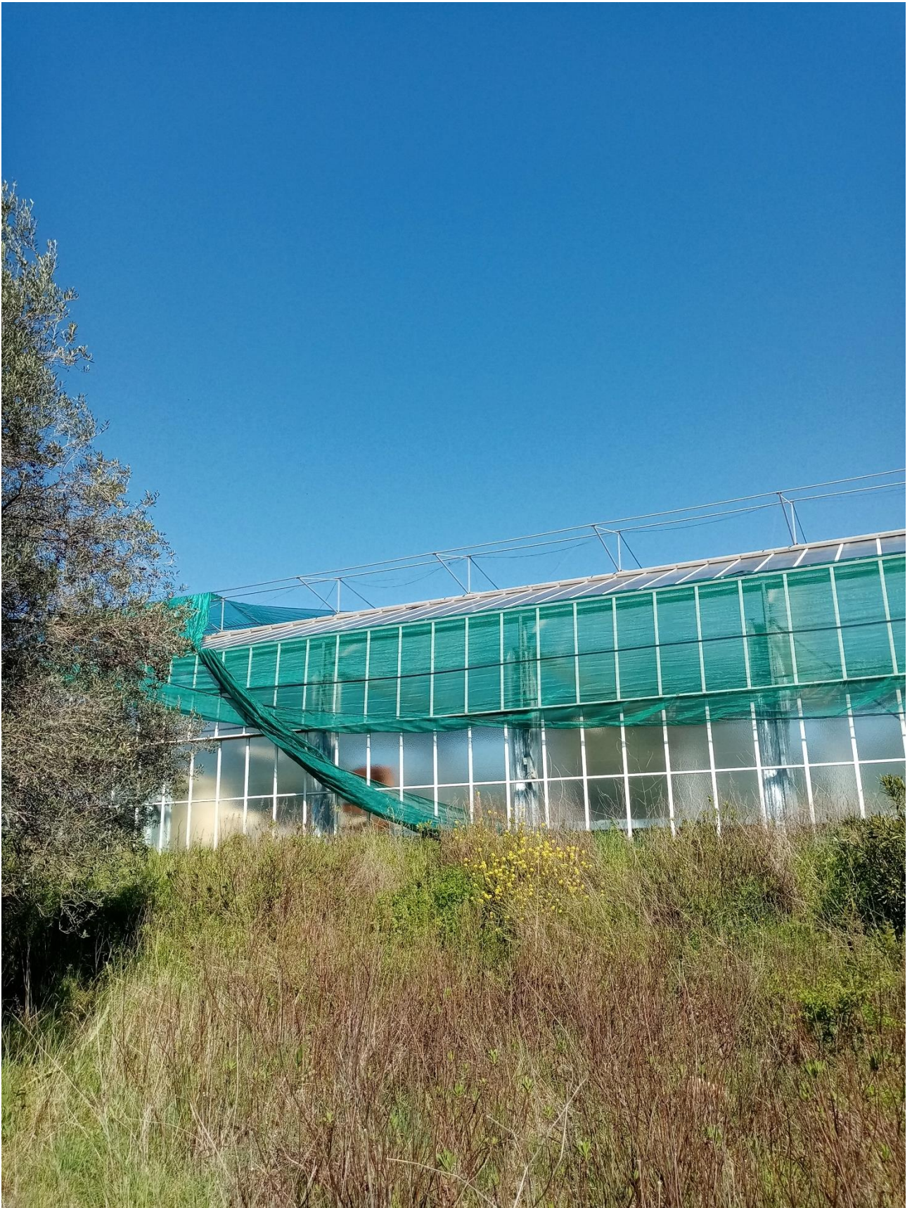
IMMAGINE N.10 CAPANNONE SERRA
