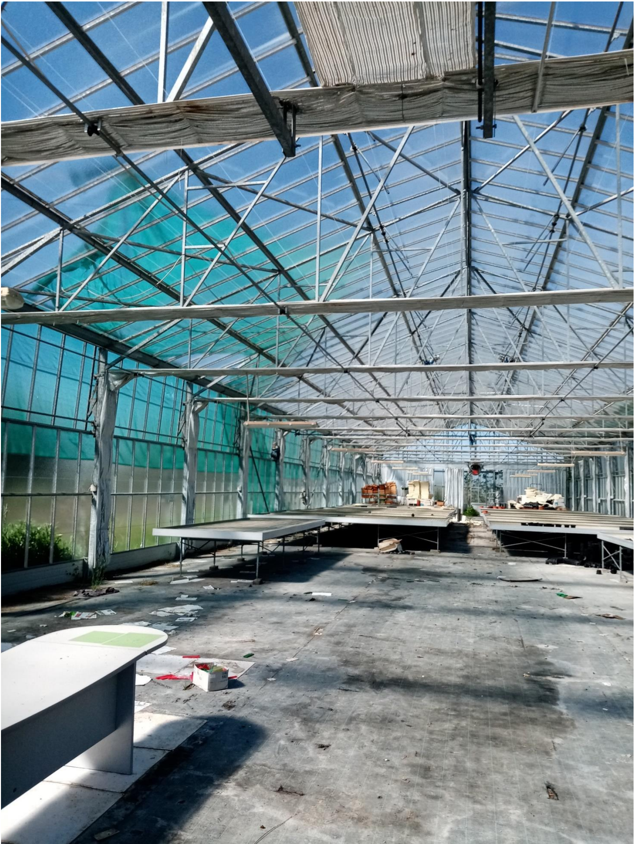
IMMAGINE N.26 CAPANNONE SERRA INTERNO
