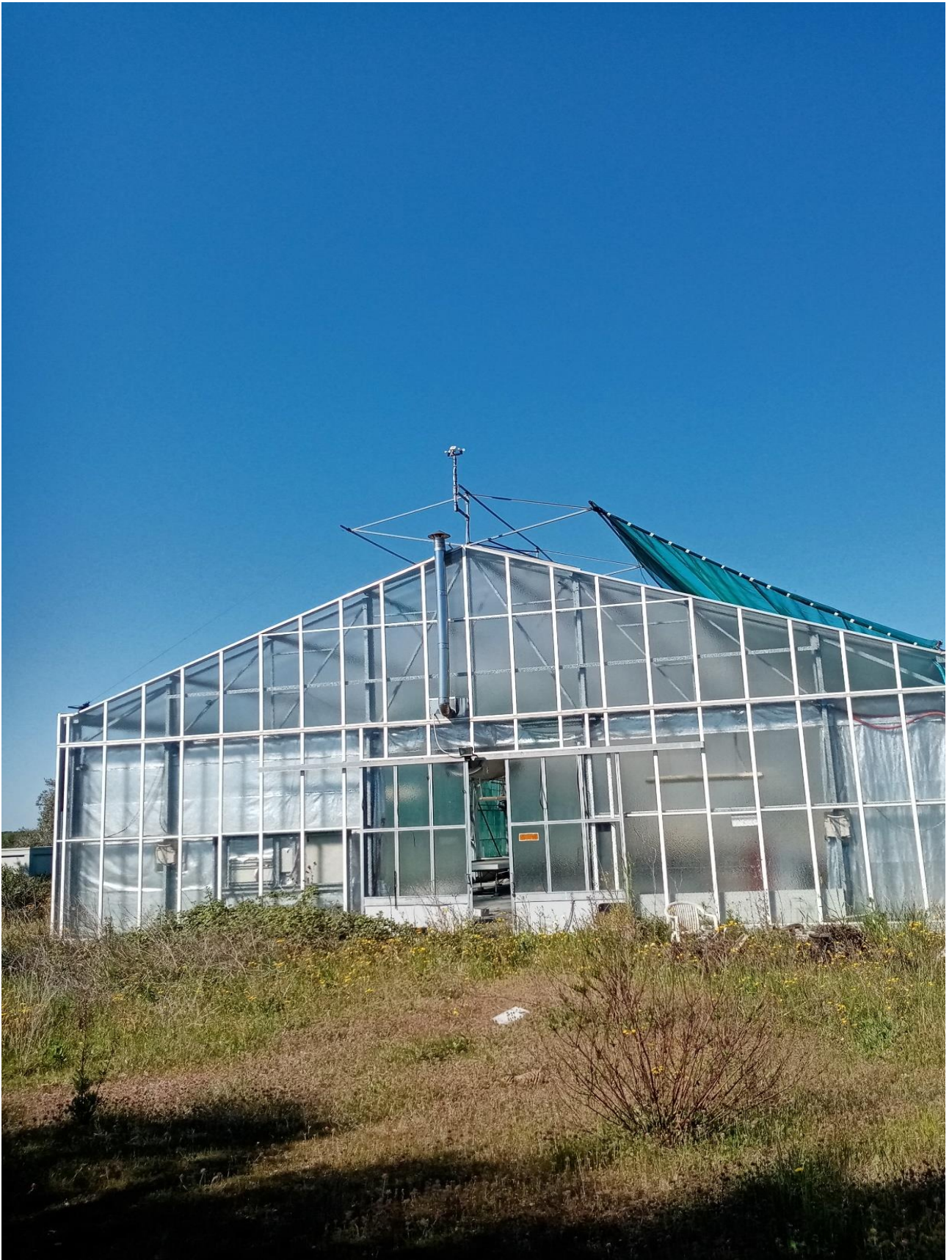
IMMAGINE N.4 CAPANNONE SERRA
