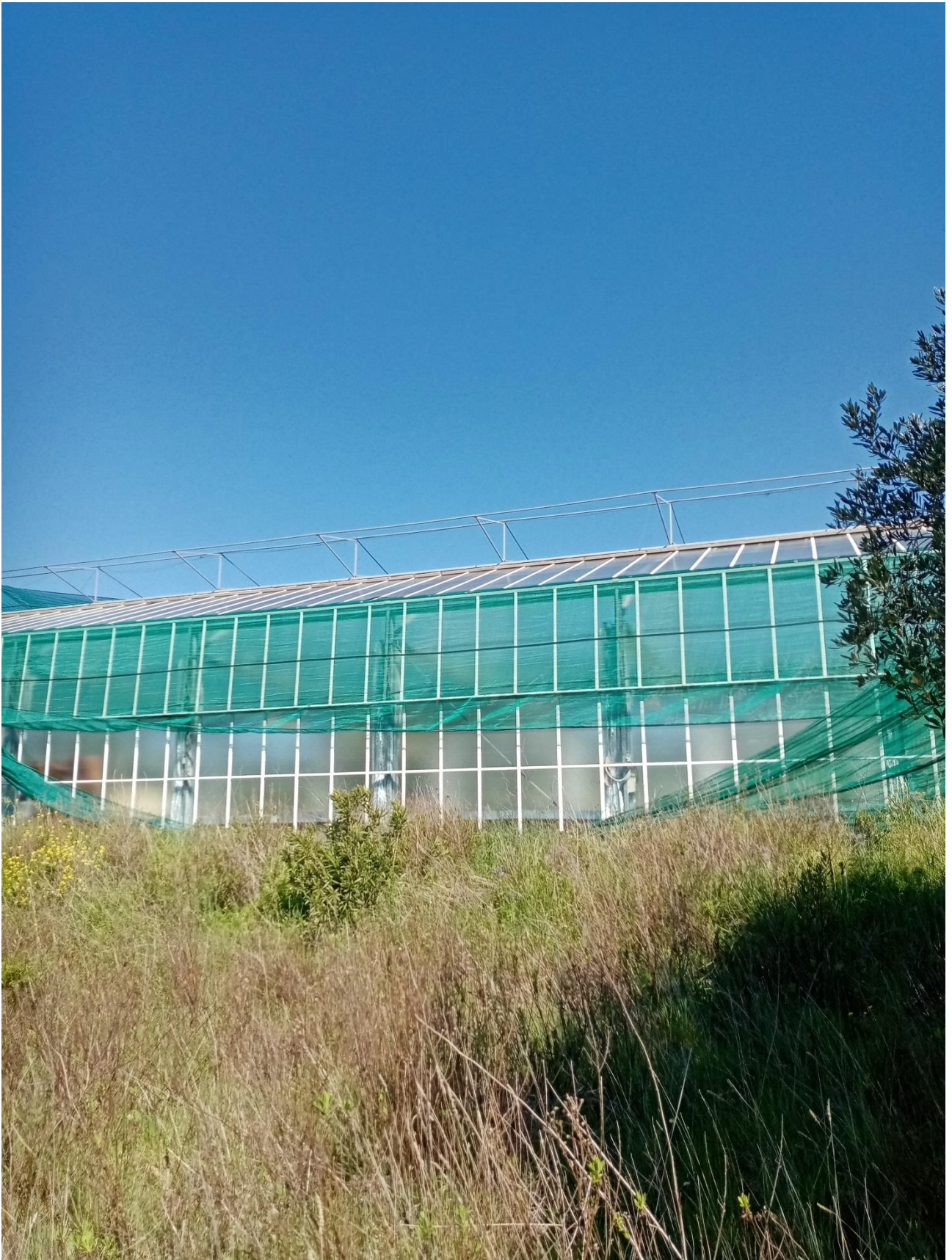
IMMAGINE N.6 CAPANNONE SERRA
