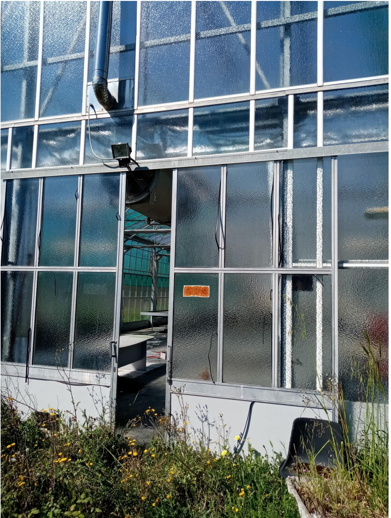
IMMAGINE N.24 CAPANNONE SERRA
