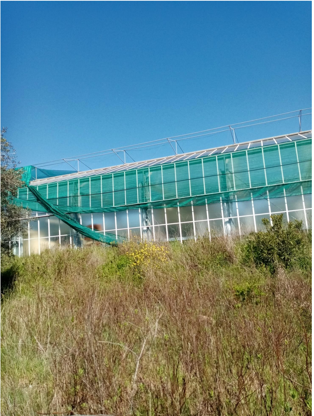
IMMAGINE N.9 CAPANNONE SERRA
