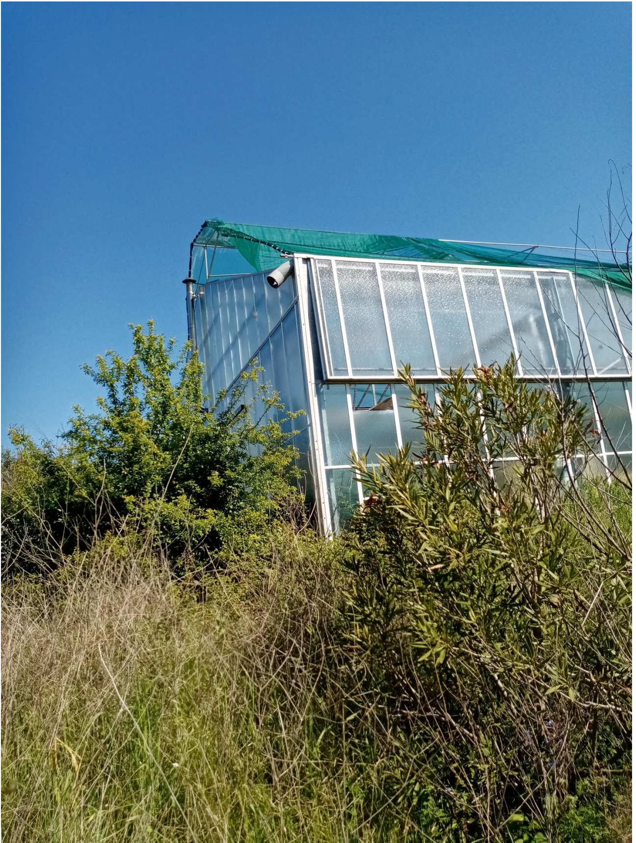
IMMAGINE N.13 CAPANNONE SERRA
