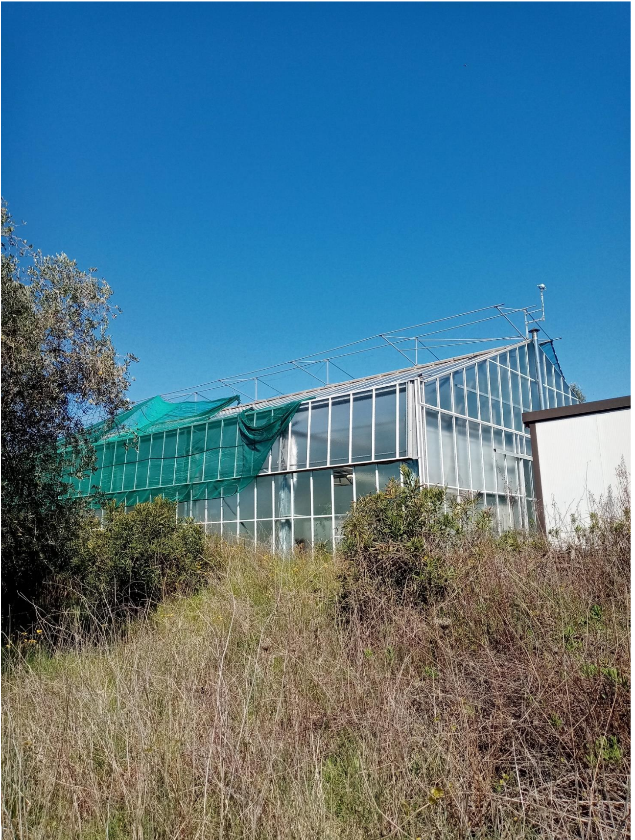
IMMAGINE N.5 CAPANNONE SERRA
