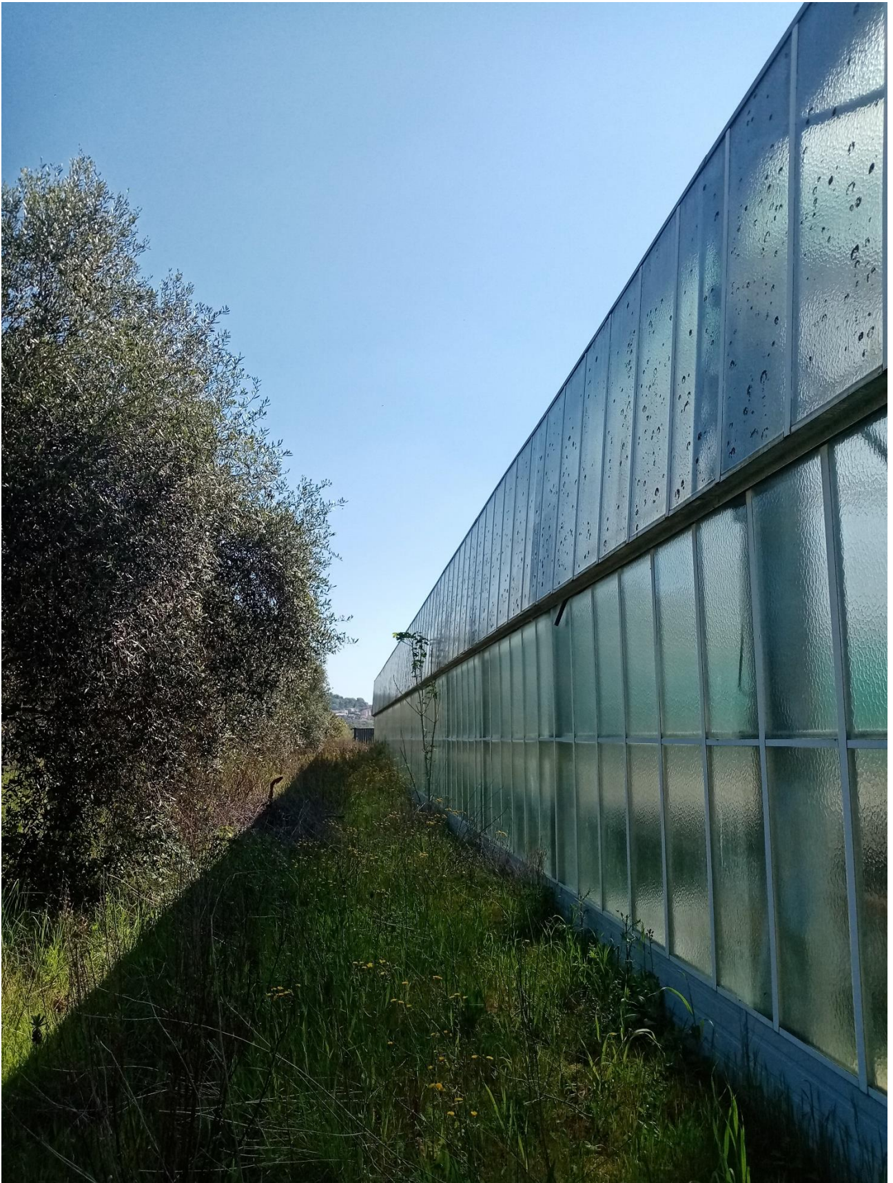
IMMAGINE N.21 CAPANNONE SERRA
