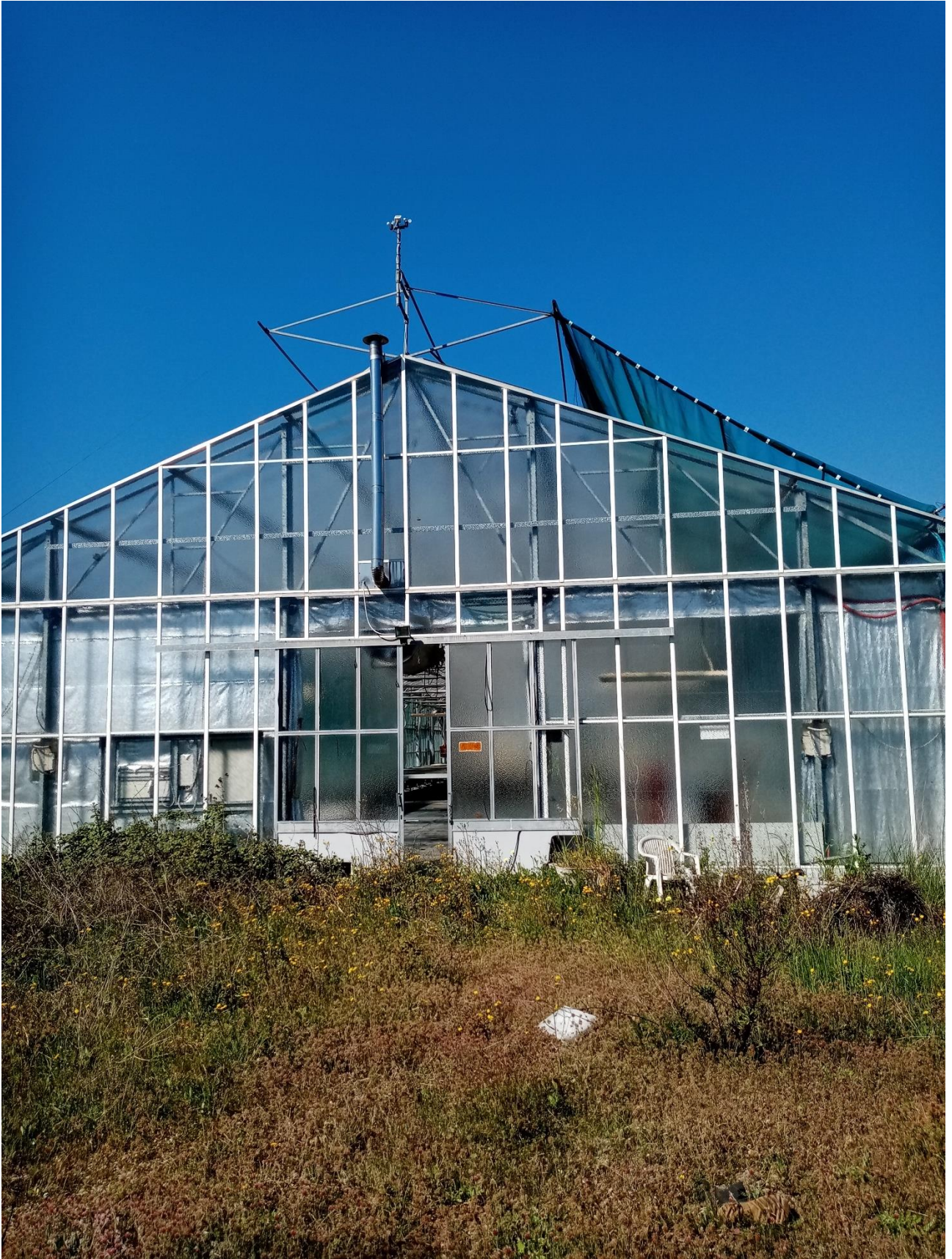
IMMAGINE N.1 CAPANNONE SERRA
