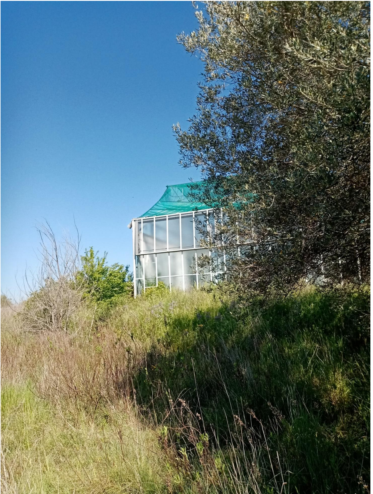
IMMAGINE N.12 CAPANNONE SERRA
