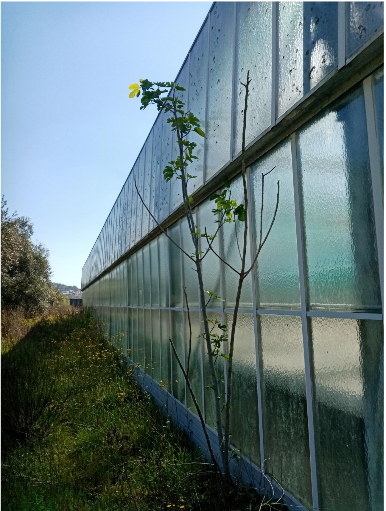
IMMAGINE N.22 CAPANNONE SERRA
