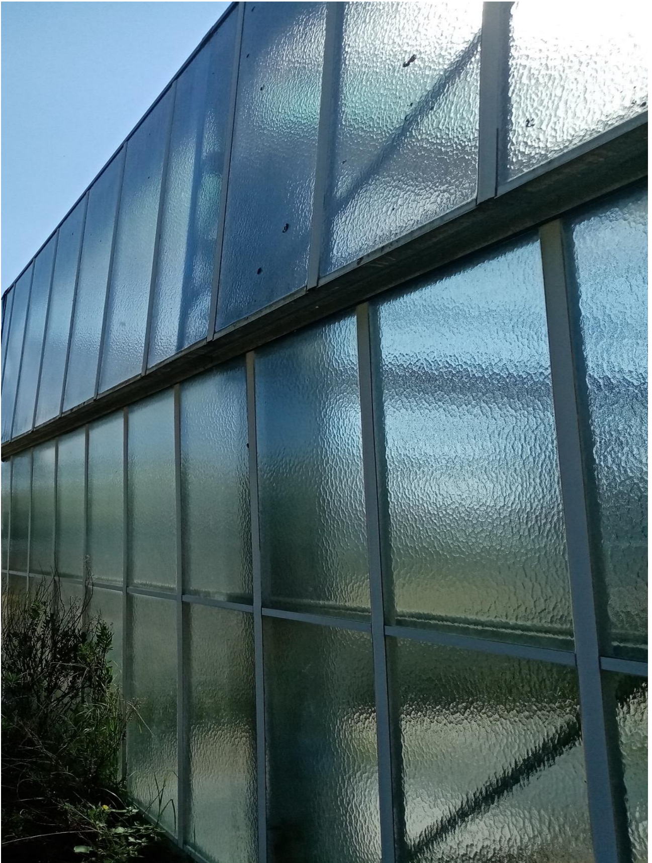
IMMAGINE N.23 CAPANNONE SERRA
