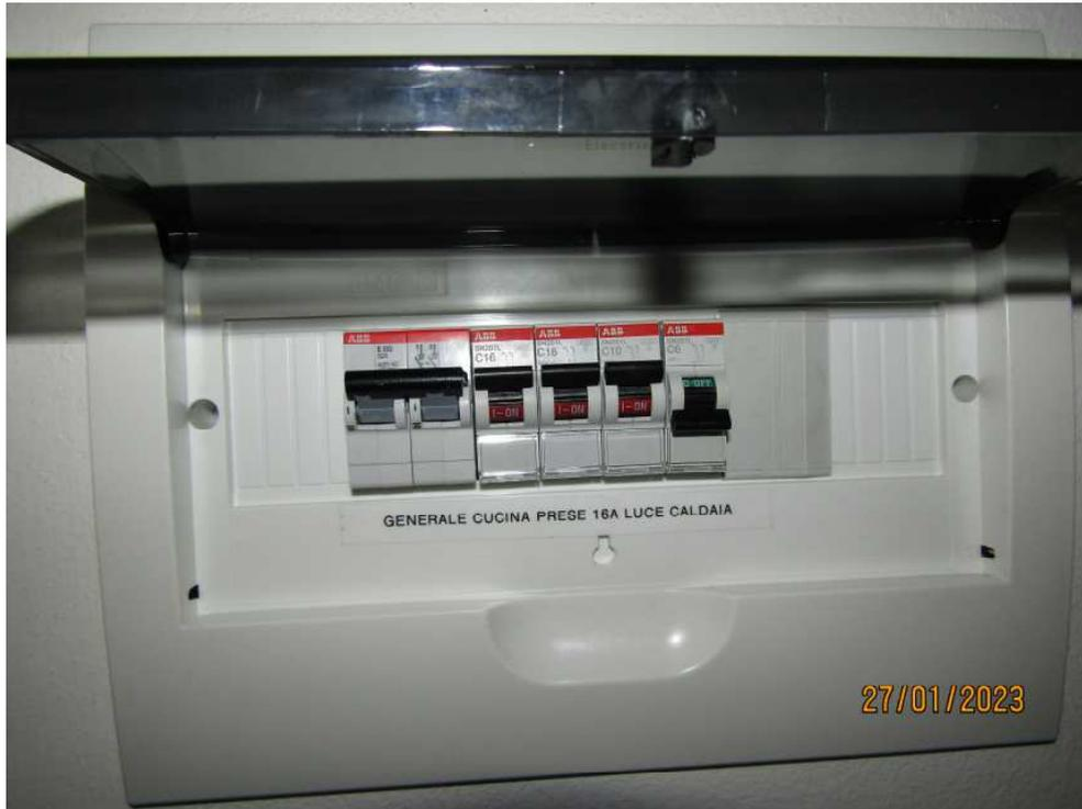
Trattasi di quadro elettrico del tipo ad incasso 12 moduli dotato di sportelli di chiusura e delle targhette identificatrici delle utenze oltre che di moduli disponibili nella carpenteria.
