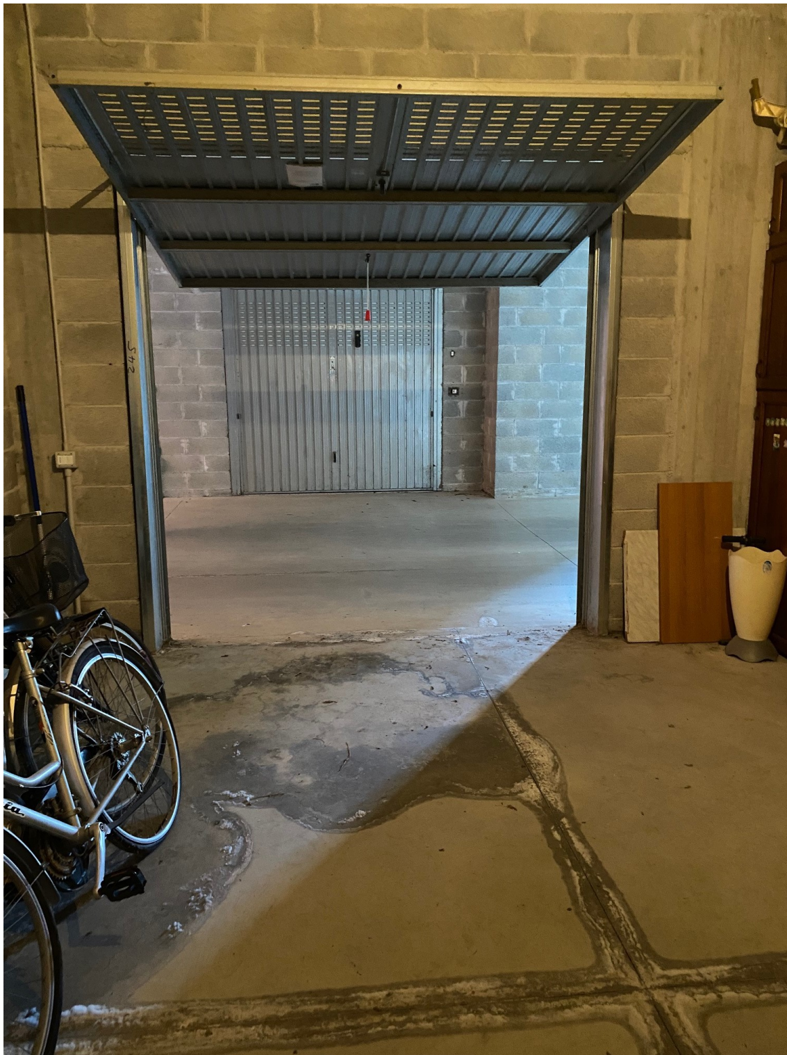
Foto 12 vista dell'autorimessa al piano interrato
