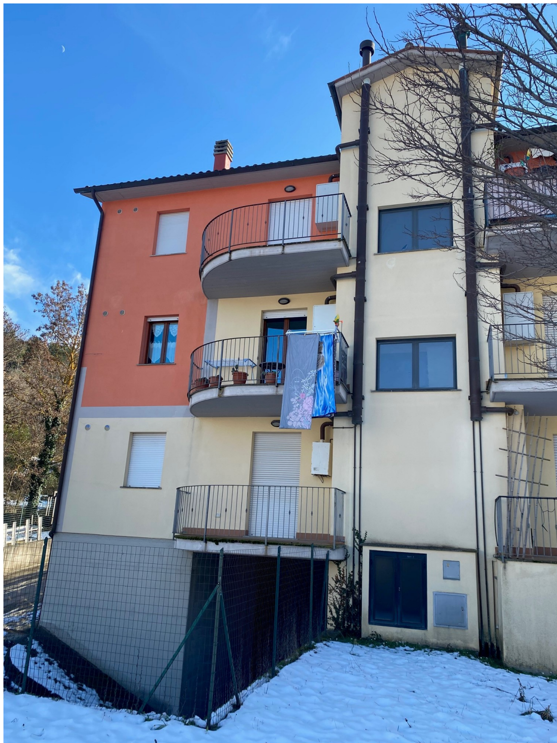
Foto 4 vista del prospetto posteriore
