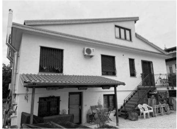
Vista interna lato cortile
