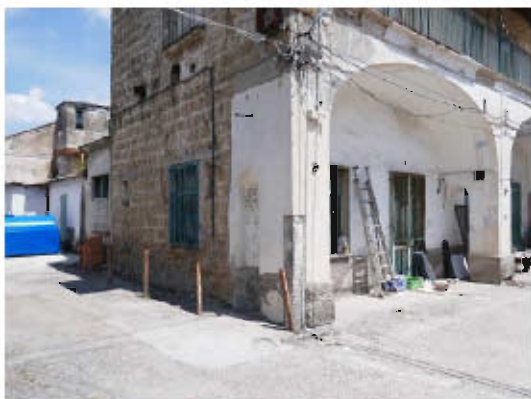
VISTA ESTERNA SUB 10 E 11
