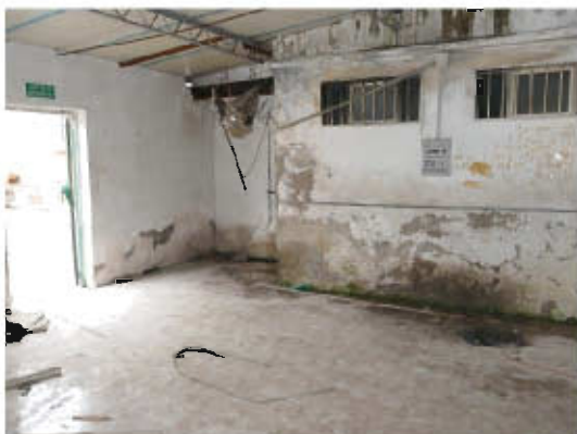
LOCALE DI ACCESSO AL CAPANNONE
