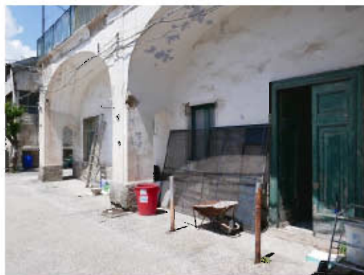
VISTA ESTERNA SUB 10 E 11
