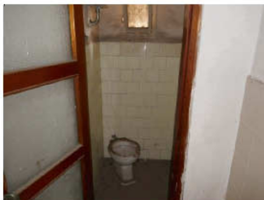
ZONA ABITATIVA - BAGNO
