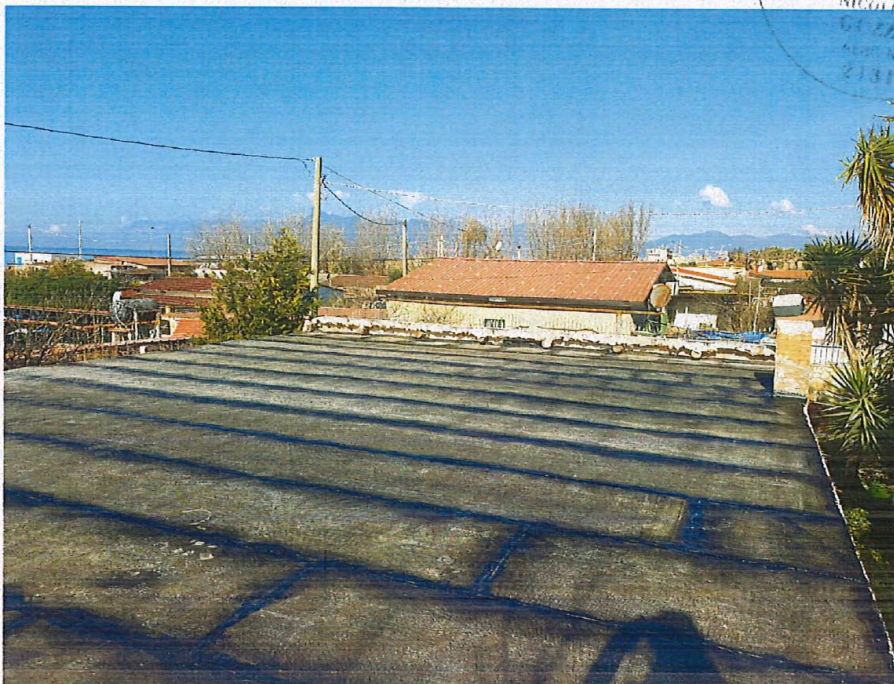
Vista lastrico solare impermeabilizzato – (Pontecagnano 20.02.2023)
