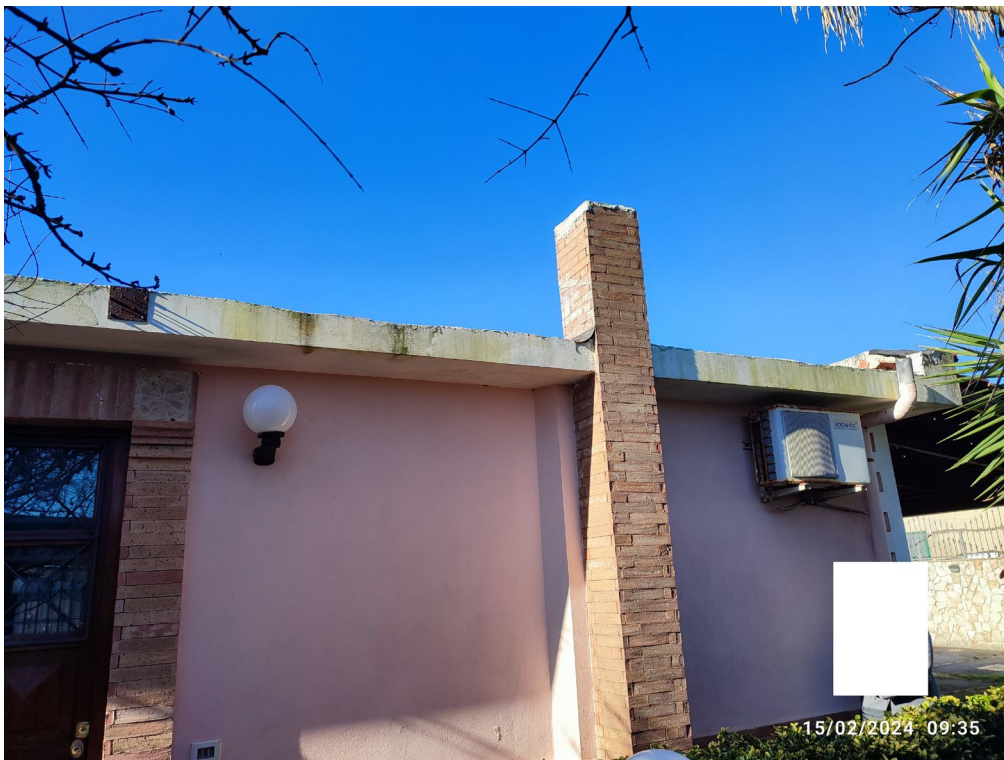
Foto 8 – Vista laterale del villino in prossimità del portoncino d’ingresso principale.
