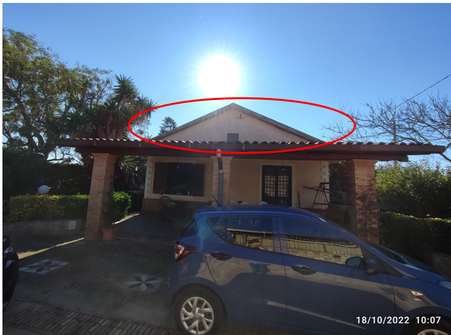
Foto 6 – Vista del villino in sede di secondo sopralluogo prima del deposito dell'elaborato peritale effettuato in data 18/10/2022 quando lo stesso presentava ancora il tetto di copertura (cerchiato).
