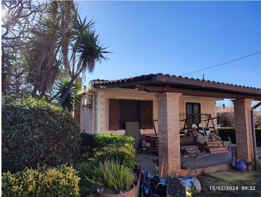
Foto 5 – Vista del villino dopo i lavori di demolizione del tetto di copertura.
