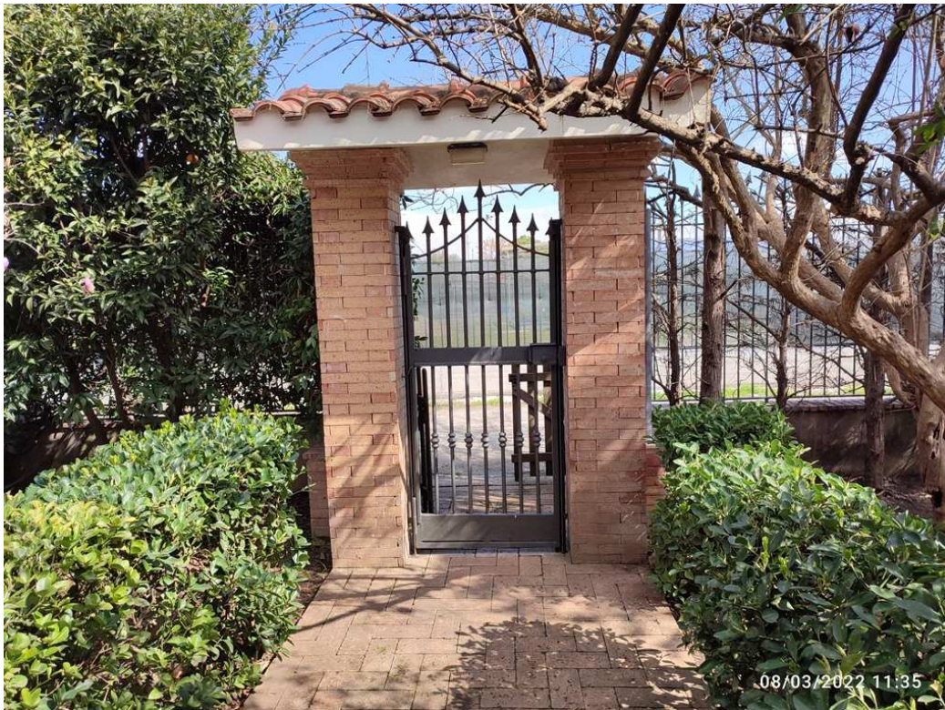
Foto 2: Vista del cancello d'ingresso pedonale della corte di pertinenza del villino. Si noti il rivestimento in mattoni presente sulle colonne ed il viale pavimentato.
