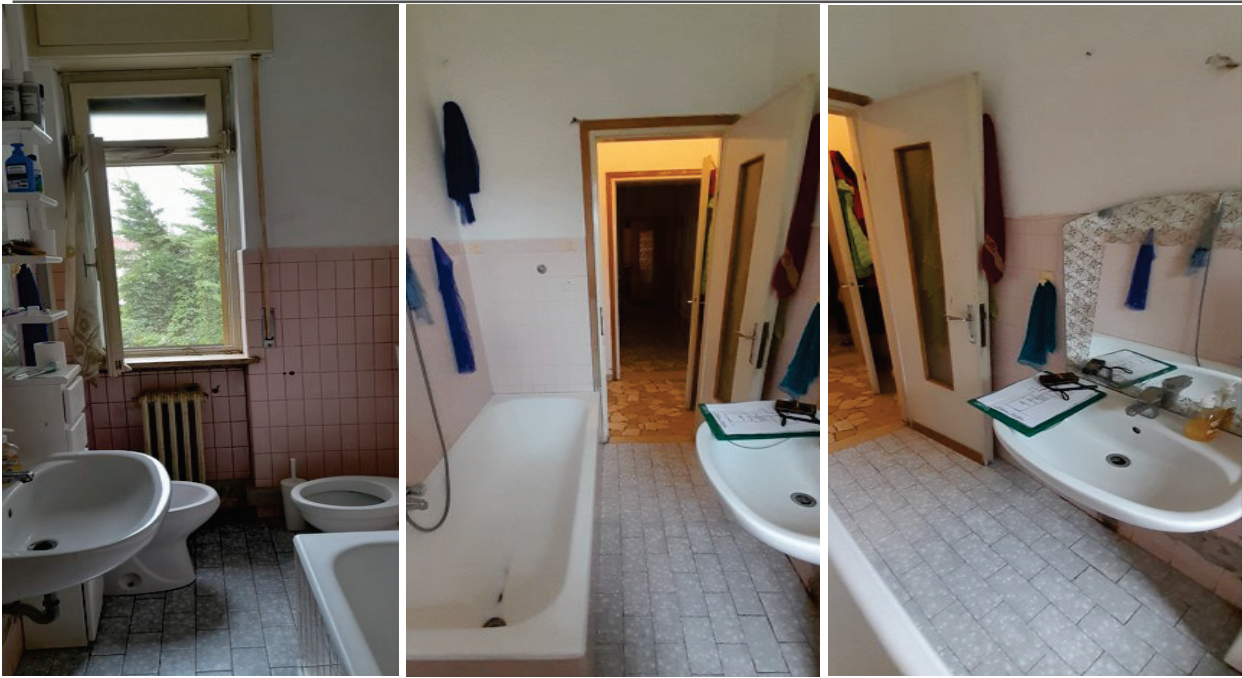
PARTICOLARI DEL BAGNO
