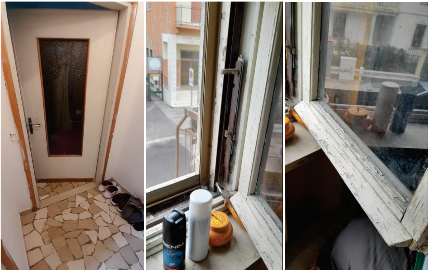
DETTAGLI DELLE FINITURE DI PORTE E FINESTRE
