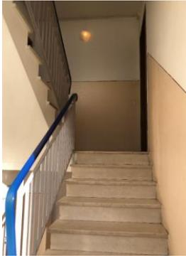
Le scale interne sono in marmo con parapetto in metallo. Il rivestimento interno delle pareti delle scale è in tintura plastica lavabile.
