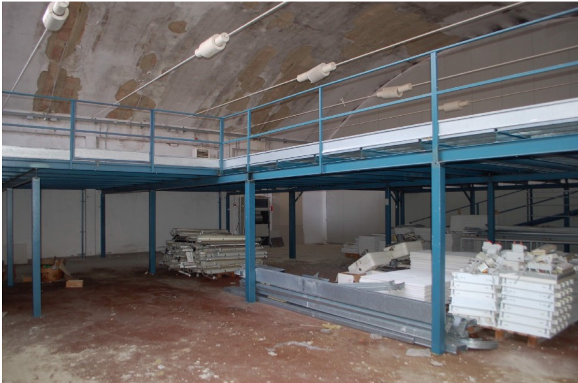
zona deposito con soppalco metallico
