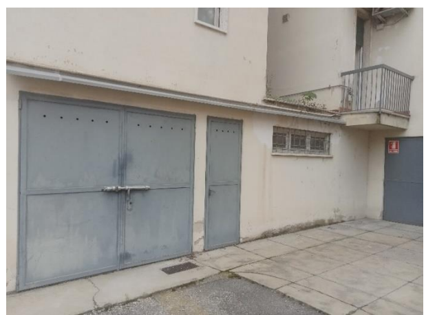
vista esterna LOTTO 1 e LOTTO 9
