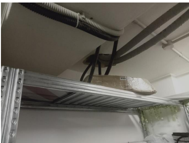
collegamento tubature LOTTO 1 / LOTTO 2
