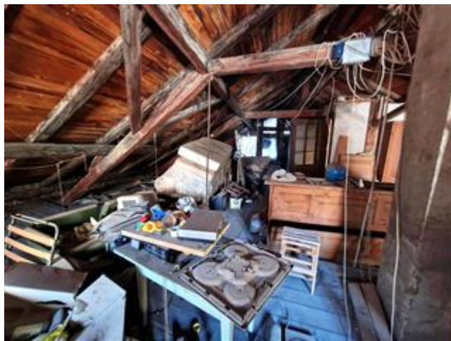
Soffitta a P4
