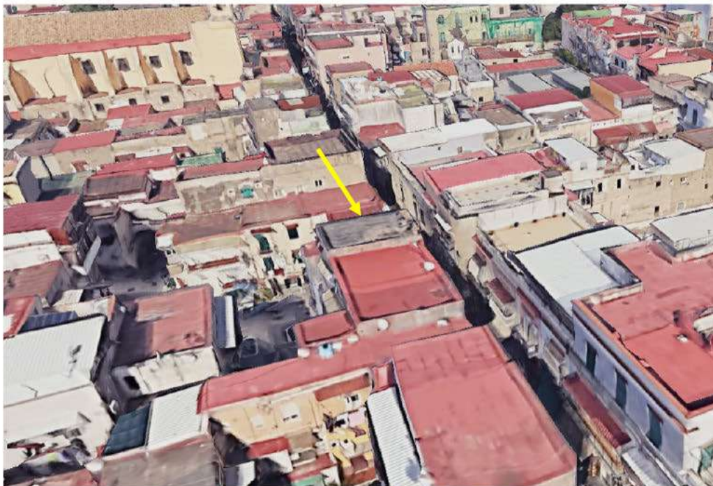
Fotografia 3 – Inquadramento territoriale lato Nord.
