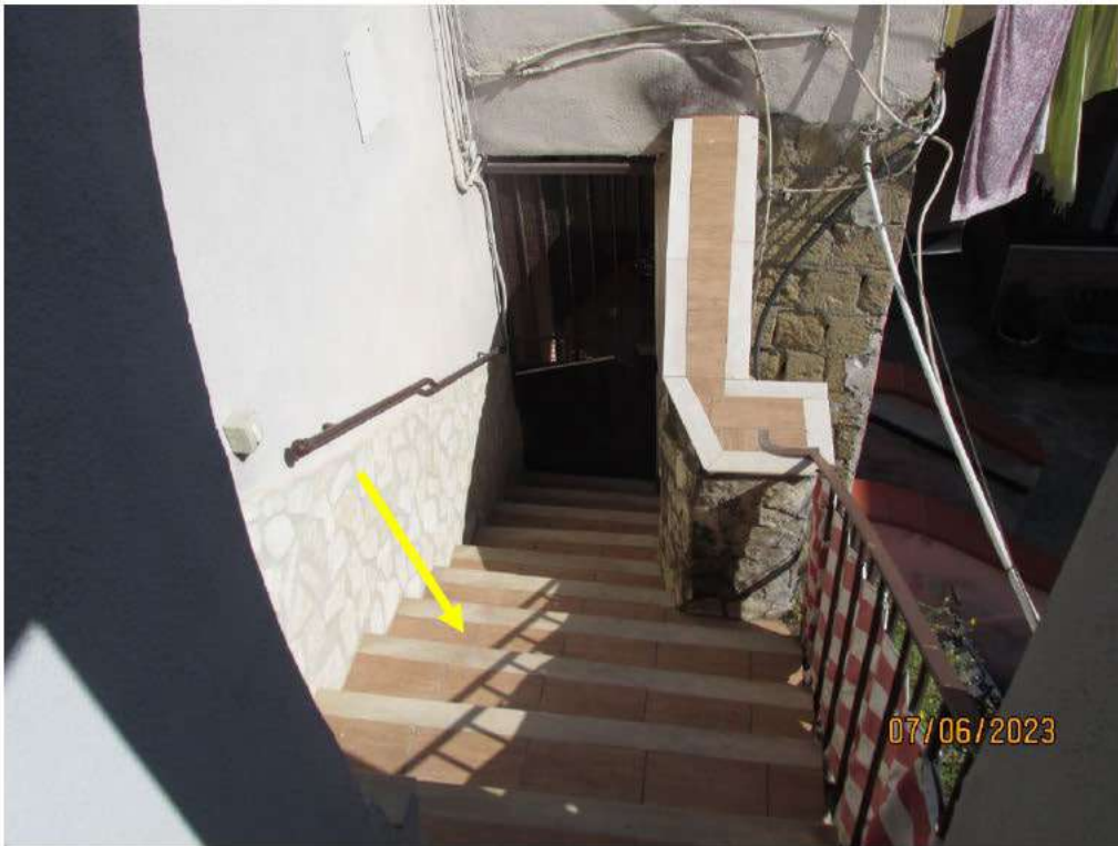
Fotografia 13 – I rampanti di scala, presentano le pedate in parte rivestite con piastrelle in ceramica smaltata in discreto stato di manutenzione.
