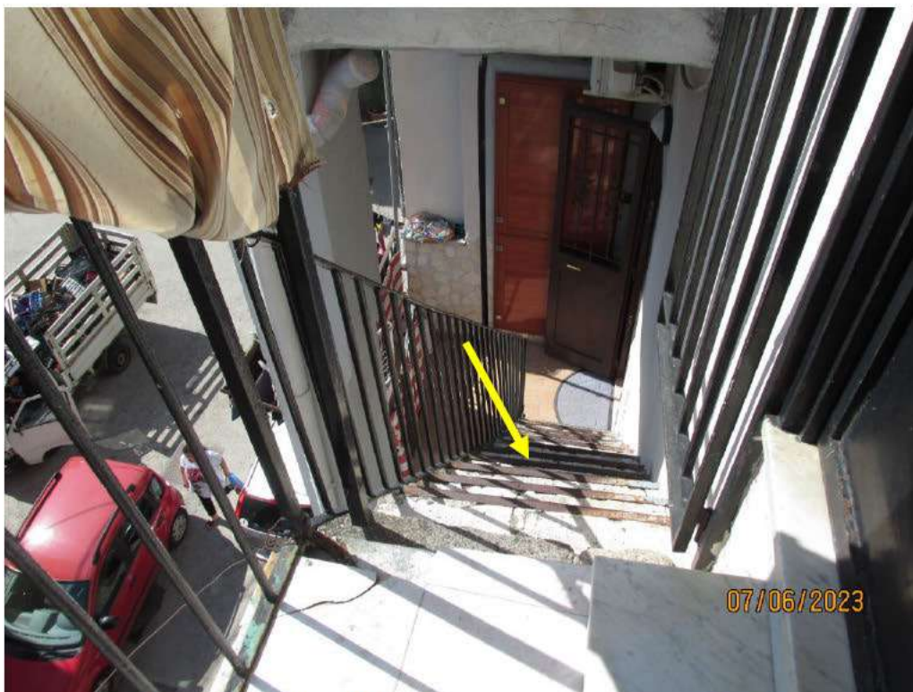
Fotografia 15 –alcuni gradini della scala si presentano in parte privi di rivestimento, costituiti dal solo battuto di cemento.
