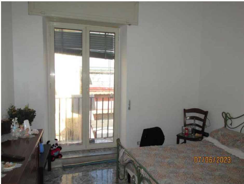
Fotografia 28 – Vano 1: L’ambiente è dotato di porta-balcone munito di infisso in alluminio e vetro camera protetto all’esterno da una persiana in pvc, con accesso sul balconcino esposto su Corso Sirena.
