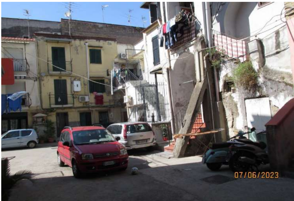
Fotografia 11 – All'interno dell'area cortilizia del fabbricato e sulla medesima area di sedime, insistono diversi edifici aventi propria autonomia funzionale con accessi a mezzo rampe di scala indipendenti. . La corte comune è utilizzata anche per la sosta di auto dai vari abitanti delle diverse unità immobiliari presenti nel casamento.
