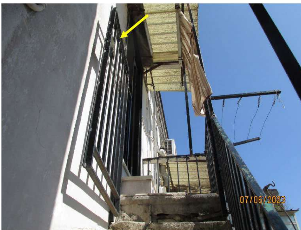
Fotografia 16 – La scala, si regge su una maglia di archi contrapposti, dove i pianerottoli di arrivo rappresentano la parte terminale del solaio di calpestio dei vari piani, essa termina al secondo piano per servire il solo appartamento pignorato, dove risulta installato un cancelletto in ferro di protezione.
