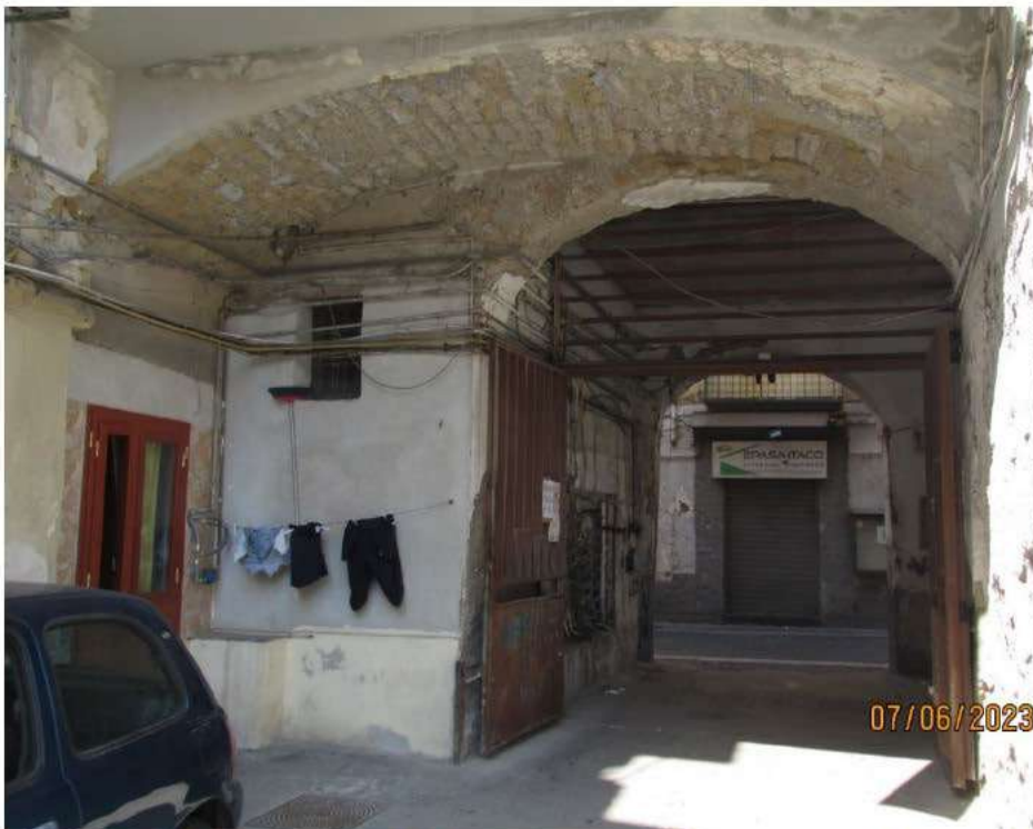
Fotografia 10 La copertura dell'androne carrabile è costituita dal solaio facente funzione di soffitto al piano terra e di solaio di calpestio del primo piano del Fabbricato; la pavimentazione è costituita per tutta la superficie da asfalto bituminoso, le pareti sono rivestite da intonaci ordinari in pessimo stato di manutenzione.
