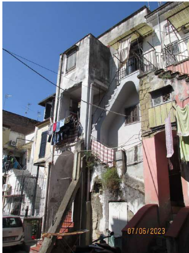
Fotografia 8 – Altra vista del fabbricato dal cortile interno.
