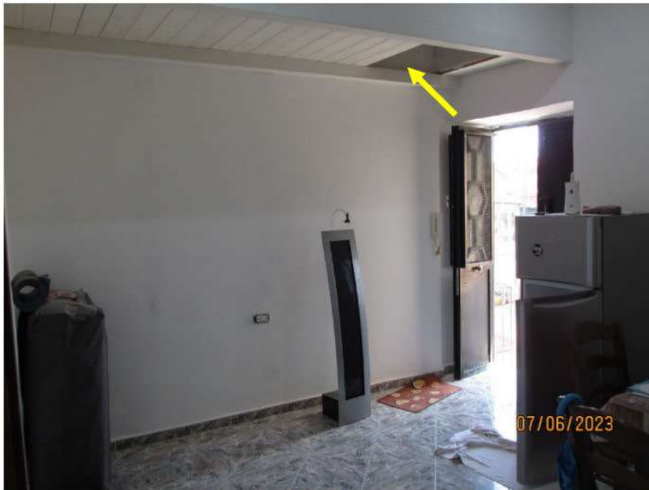
Fotografia 21 – Soggiorno/Cucina: L'ambiente è dotato di un ripostiglio a soffitto, costituito da due travi in legno su cui sono appoggiate doghe sempre in legno.
