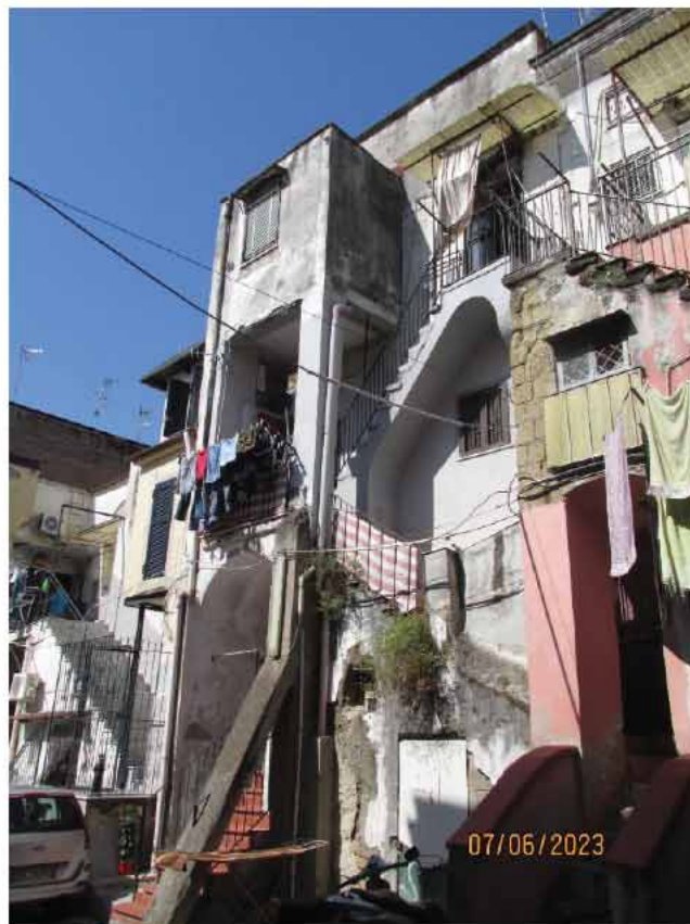
Fotografia 8 – Altra vista del fabbricato dal cortile interno.
