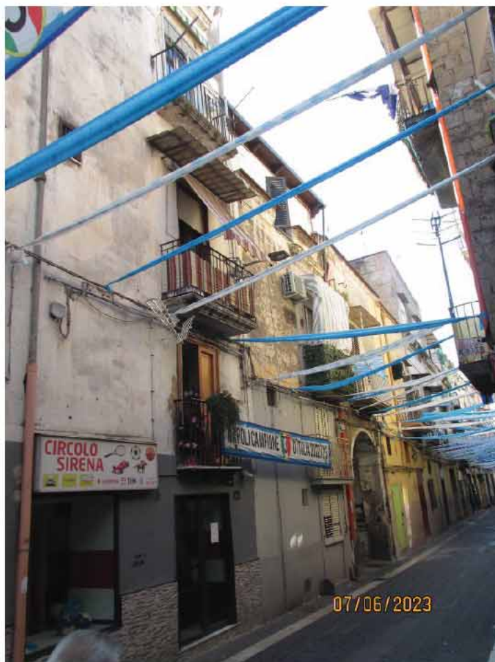
Fotografia 6 – Vista fabbricato da Corso Sirena.
