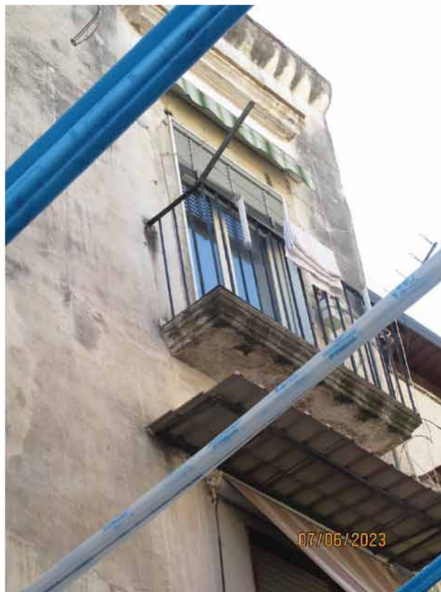
Fotografia 31 – Balcone: Il balcone è esposto lungo il versante nord con affaccio diretto su Corso Sirena. La struttura è a sbalzo sulla facciata principale del fabbricato, ed è protetto lungo l’aggetto da una ringhiera in ferro.
