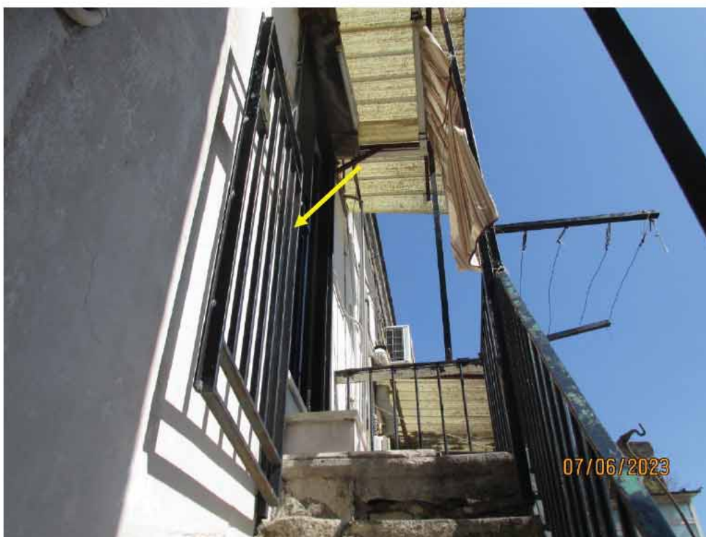
Fotografia 16 - La scala, si regge su una maglia di archi contrapposti, dove i pianerottoli di arrivo rappresentano la parte terminale del solaio di calpestio dei vari piani, essa termina al secondo piano per servire il solo appartamento pignorato, dove risulta installato un cancelletto in ferro di protezione.
