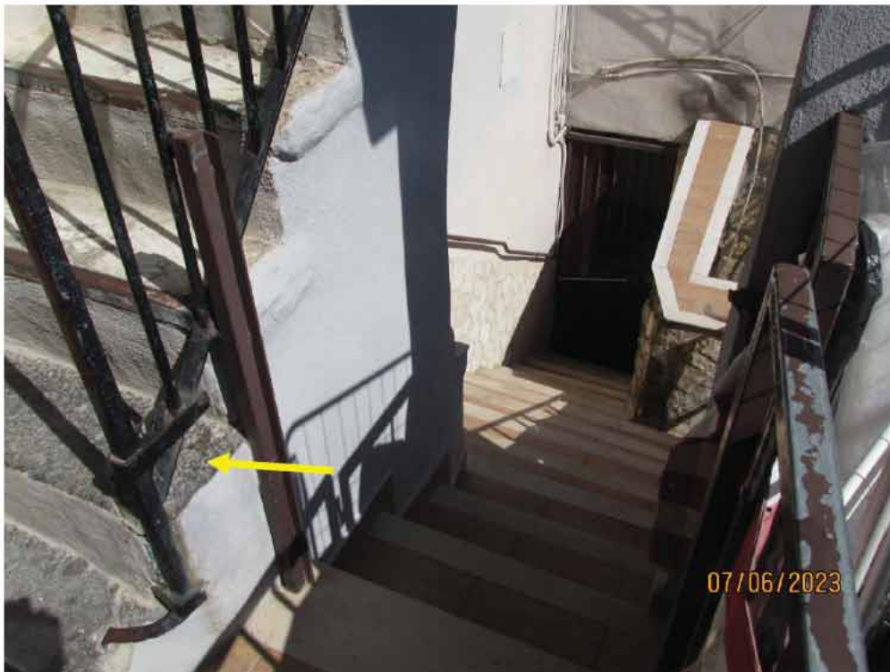
Fotografia 14 – gradini rivestiti con lastre in pietra di piperno di vecchia fattura.
