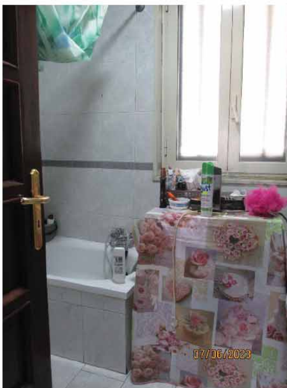
Fotografia 24 – Bagno: le pareti sono interamente rivestite con piastrelle in ceramica smaltata; il soffitto risulta rivestito con intonaci ordinari a finitura liscia tinteggiato con pittura a tempera.
