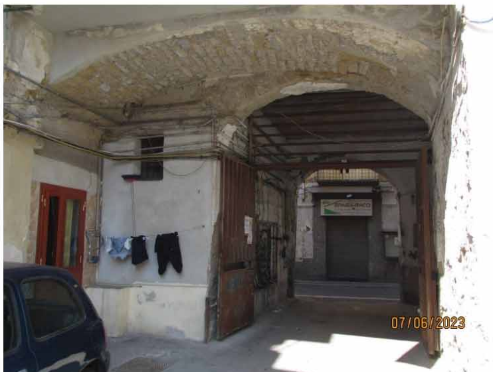
Fotografia 10 – La copertura dell'androne carrabile è costituita dal solaio facente funzione di soffitto al piano terra e di solaio di calpestio del primo piano del Fabbricato; la pavimentazione è costituita per tutta la superficie da asfalto bituminoso, le pareti sono rivestite da intonaci ordinari in pessimo stato di manutenzione.
