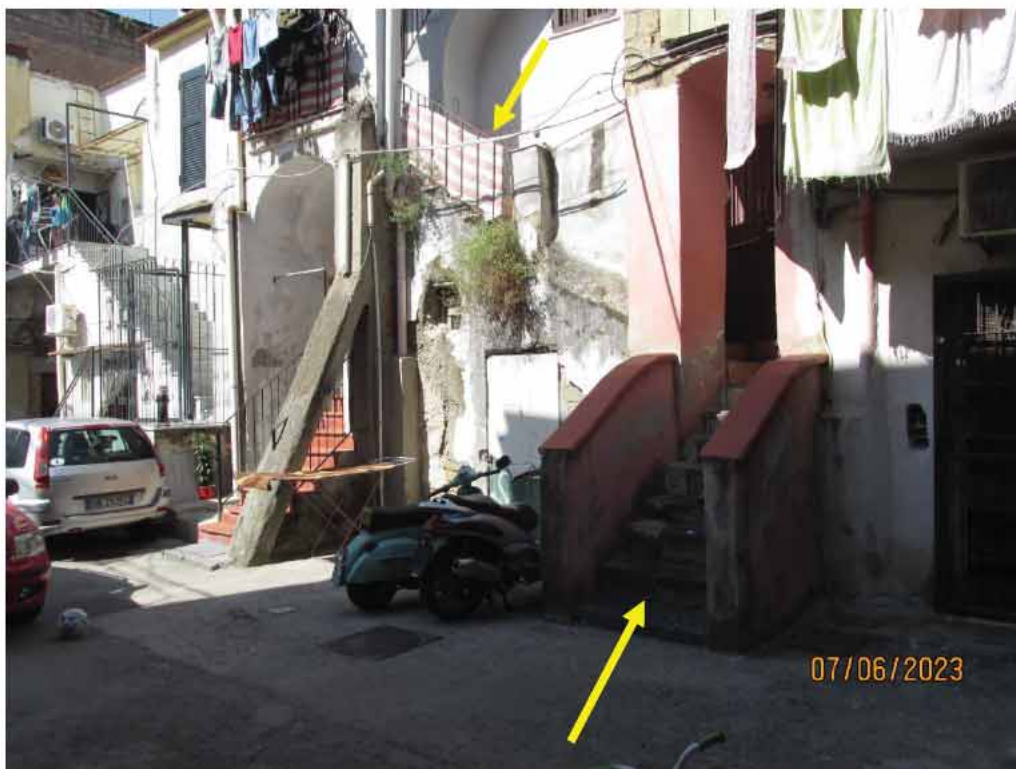
Fotografia 12 – La scala che conduce all’appartamento pignorato è la terza a sinistra per chi entra nella corte comune attraverso l’androne d’accesso. Risulta costituita in muratura portante addossata alla parete perimetrale, è all’aperto ed è dotata di ringhiera in ferro di protezione verso l’esterno. La scala conduce anche ad altri appartamenti posti al piano primo della palazzina.
