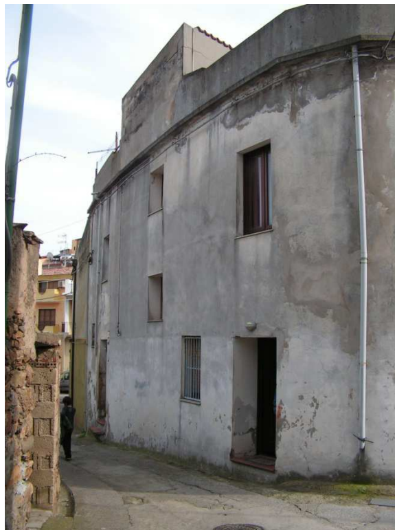
Foto 2 - Facciata edificio – Ingresso dal civico n°6
