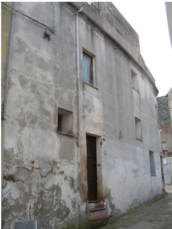
Foto 1 - Facciata edificio – Ingresso dal civico n°4
