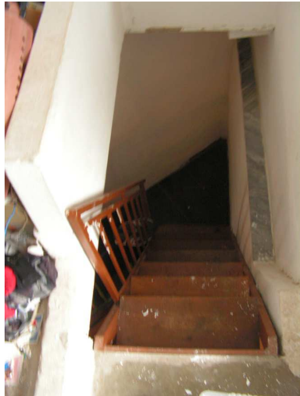
Foto 21 – Ultima rampa della scala – P.2
