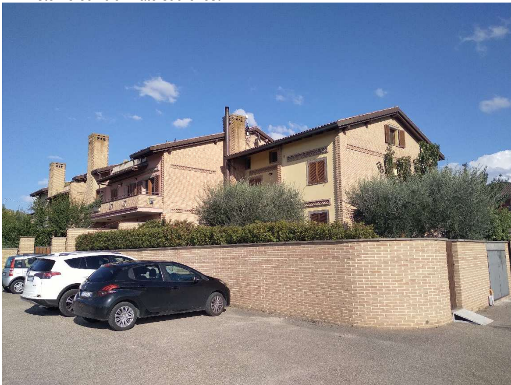
Esterno edificio – lato sud-ovest
