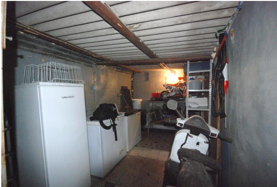
FOTO 17 – Interno del magazzino sito nella corte comune
