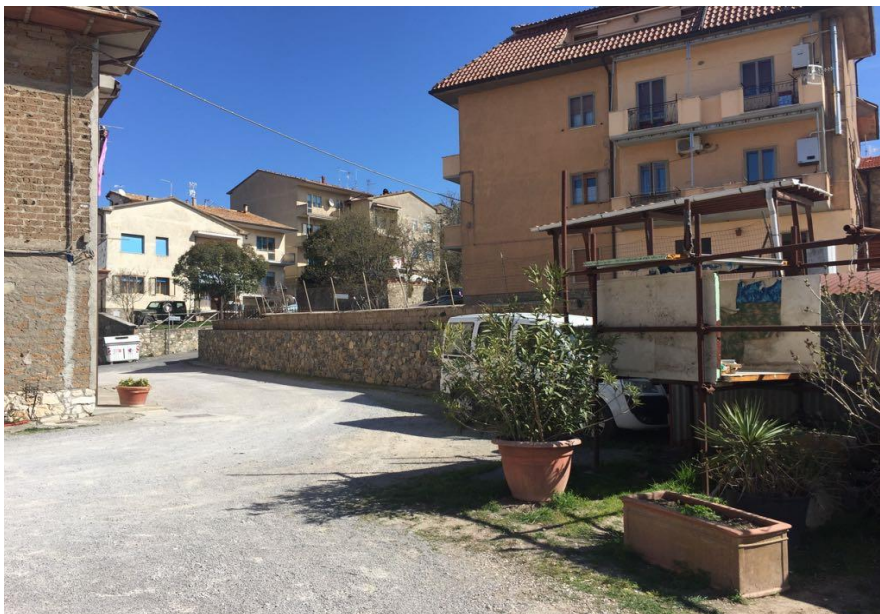
FOTO 18 – Muro di confine al quale era addossata la tettoia demolita
