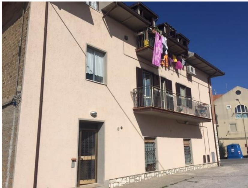
FOTO 1 – Ingresso dalla corte comune sul lato Est del fabbricato
