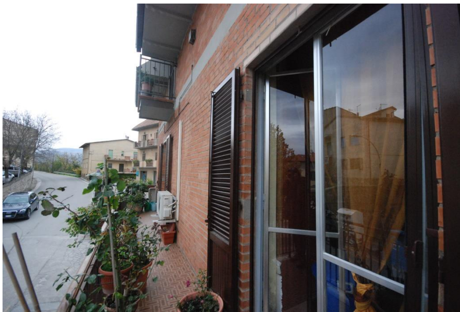
FOTO 14 – Terrazza su lato Nord del fabbricato
