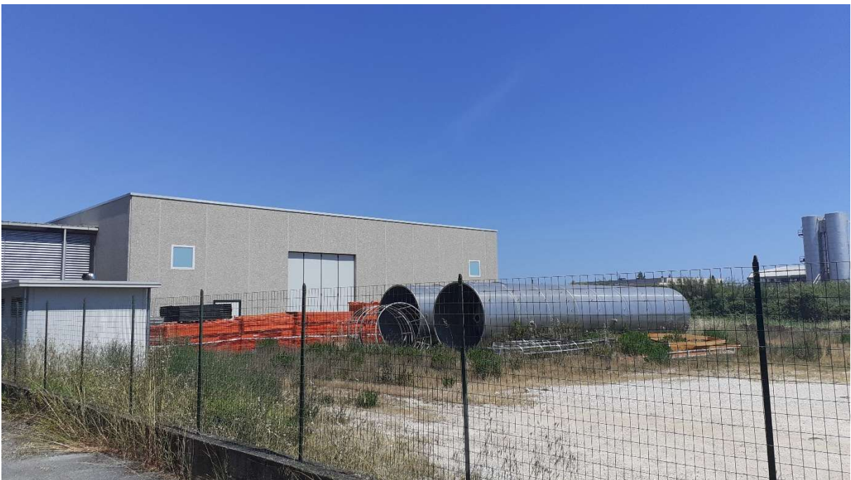
Foto n.2- Vista lato sud
