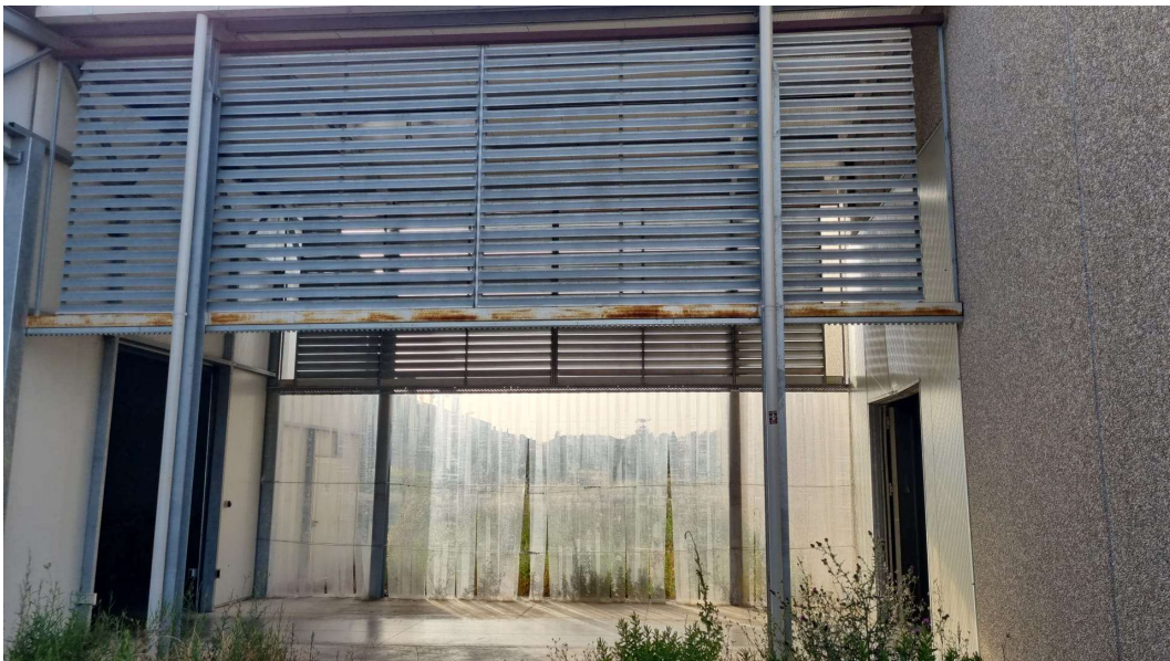
Foto n.14- Collegamento con l'altro capannone
