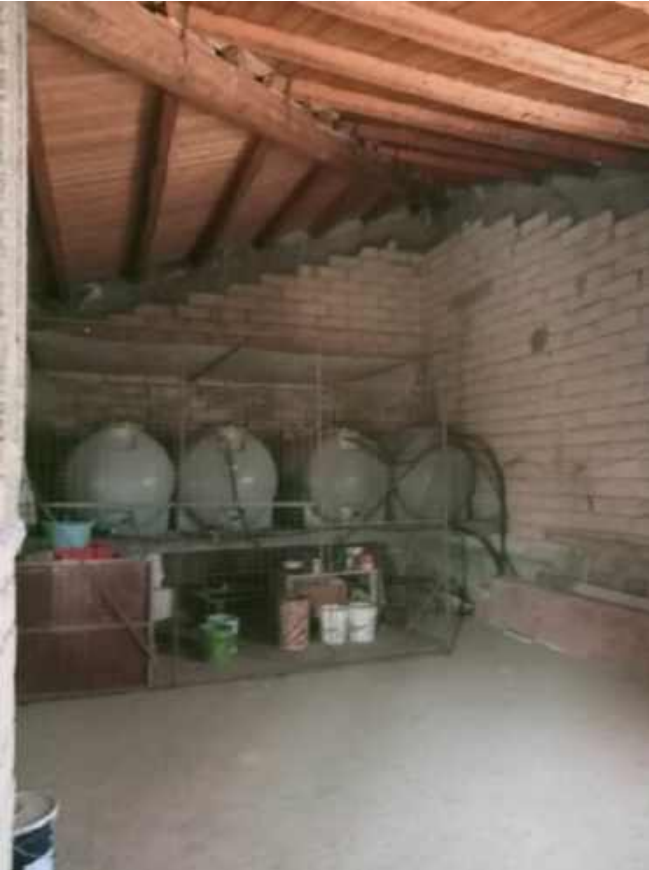
Foto 3 – deposito sottotetto piano 3
