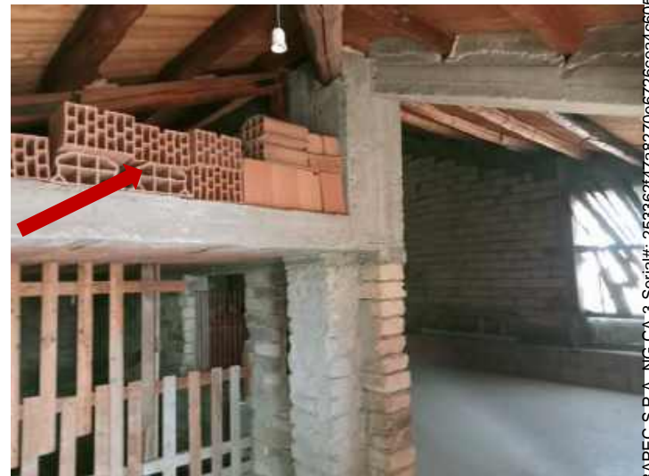
Foto 6 – deposito sottotetto piano 4
