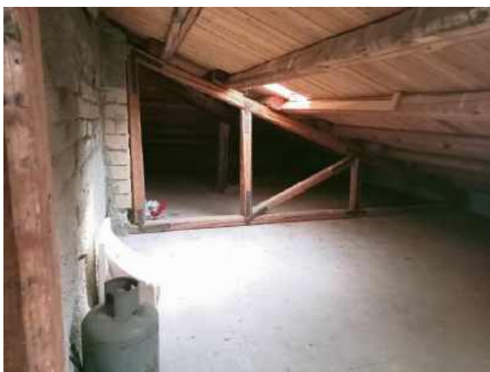
Foto 1 – deposito sottotetto piano 3
