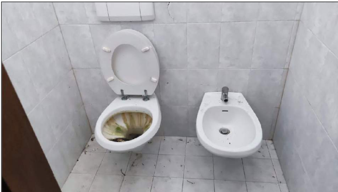
Vista Interna - Servizio Igienico n°2
