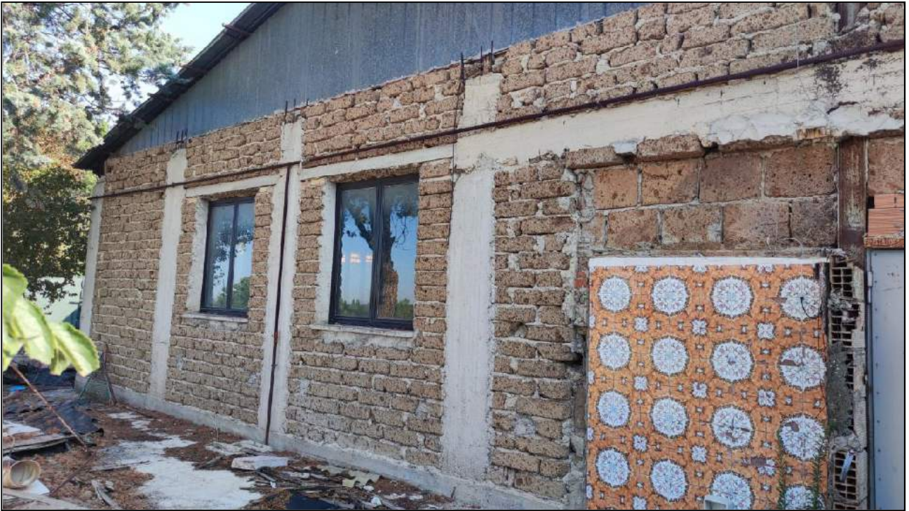
Vista Prospetto Sud-Ovest
