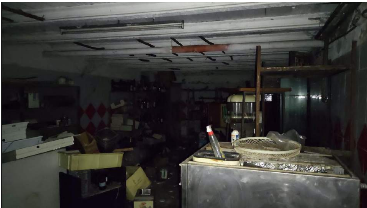
Vista Interna - Magazzino Piano Interrato
