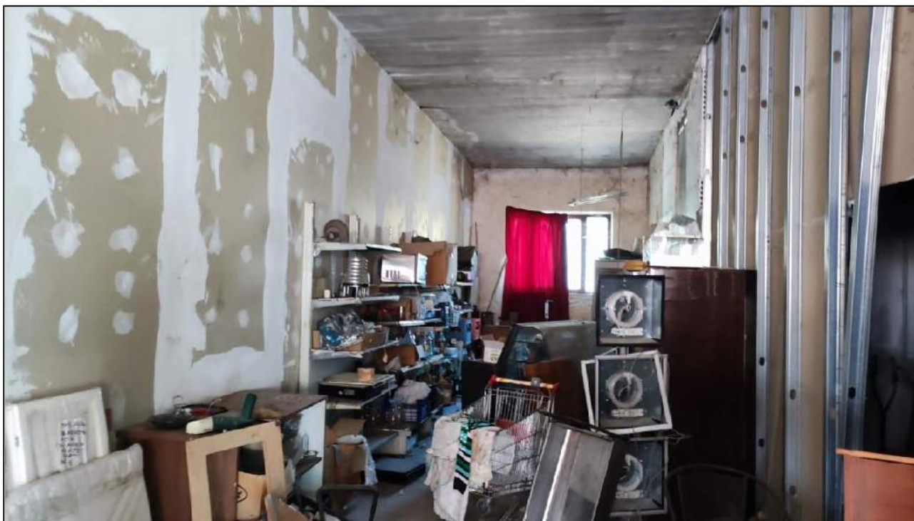
Vista Interna - Dispensa e Locali accessori ristorante
