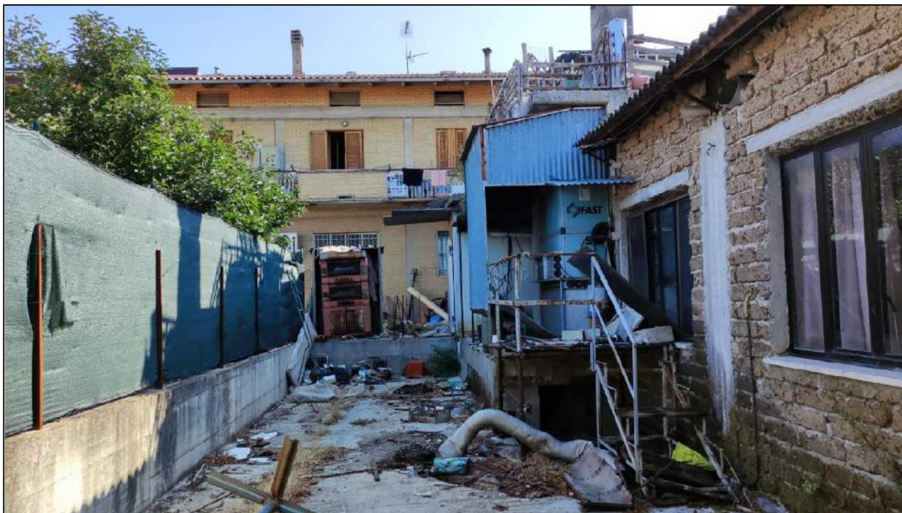
Vista Prospetto Nord-Ovest
