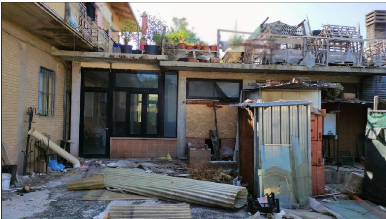
Vista Prospetto Nord-Ovest
