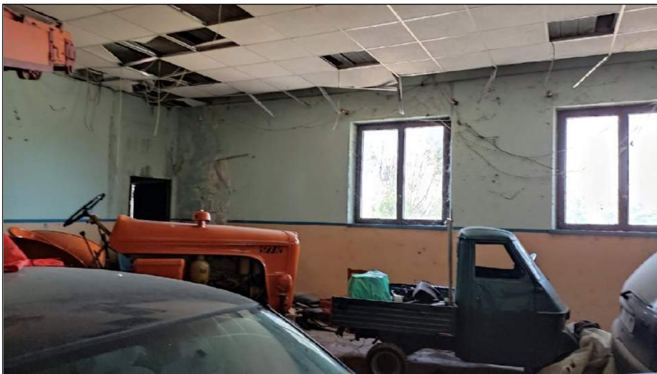
Vista Interna - Dispensa e Locali accessori ristorante
