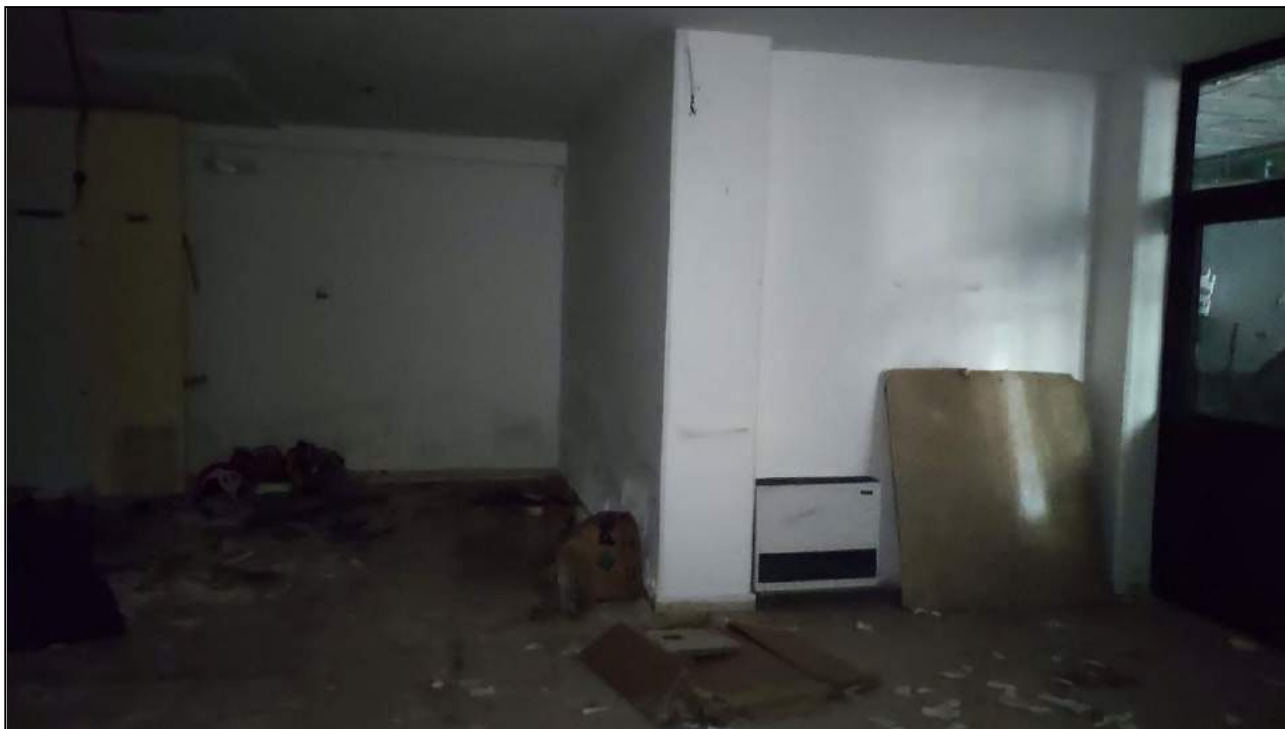
Vista Interna - Locali di Sgombero Piano Interrato
