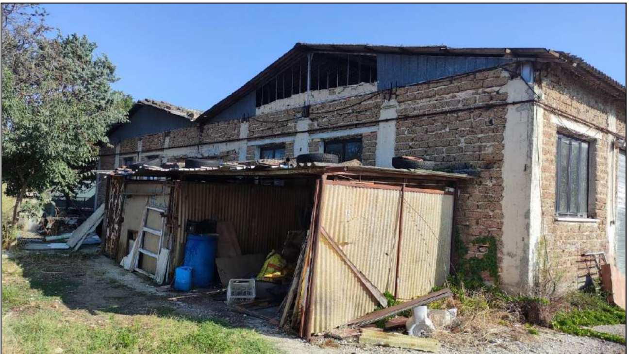
Vista Prospetto Sud-Ovest
