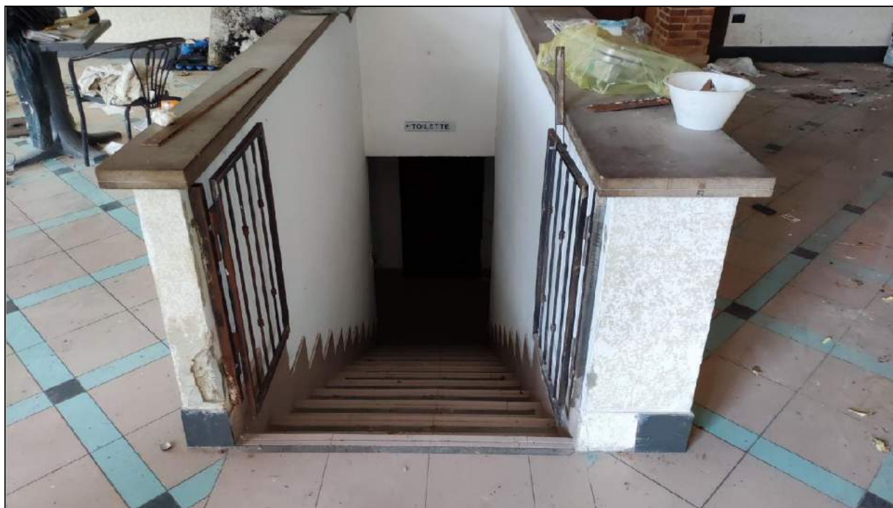
Vista Interna - Scala interna accesso Piano Interrato
