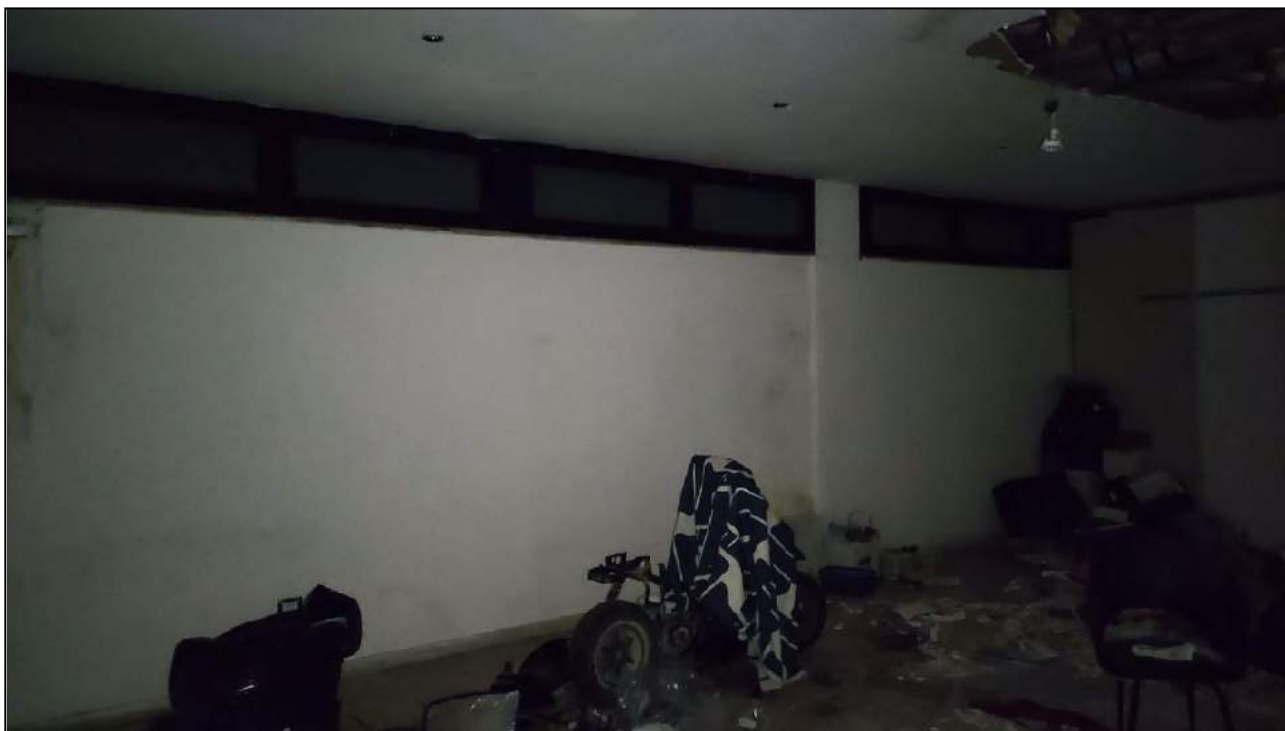
Vista Interna - Locali di Sgombero Piano Interrato
