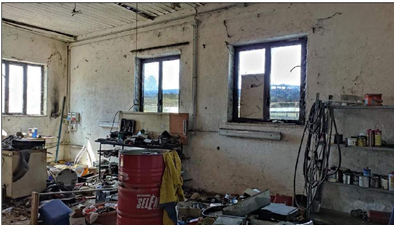
Vista Interna - Dispensa e Locali accessori ristorante
