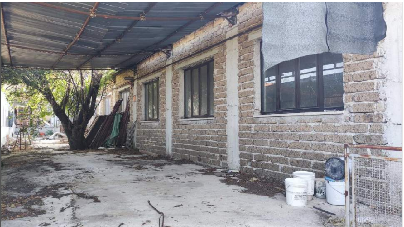
Vista Prospetto Nord-Ovest
