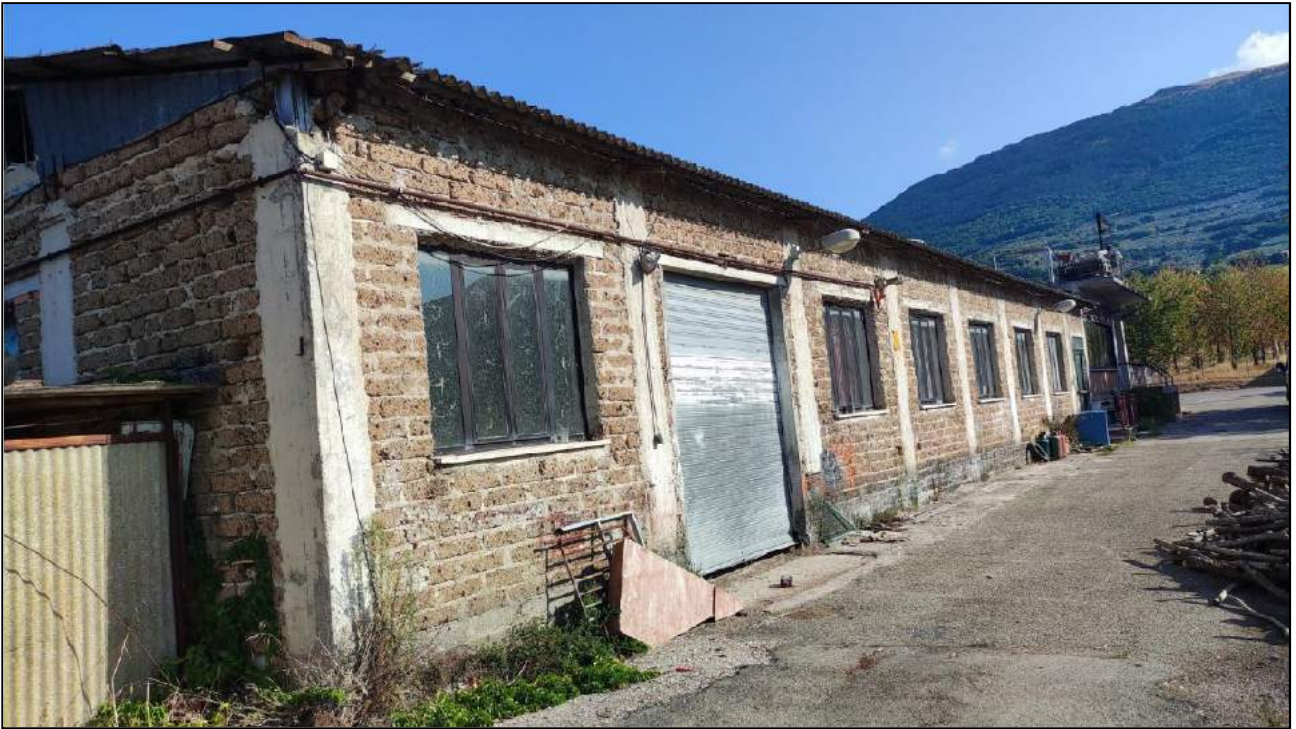
Vista Prospetto Sud-Est
