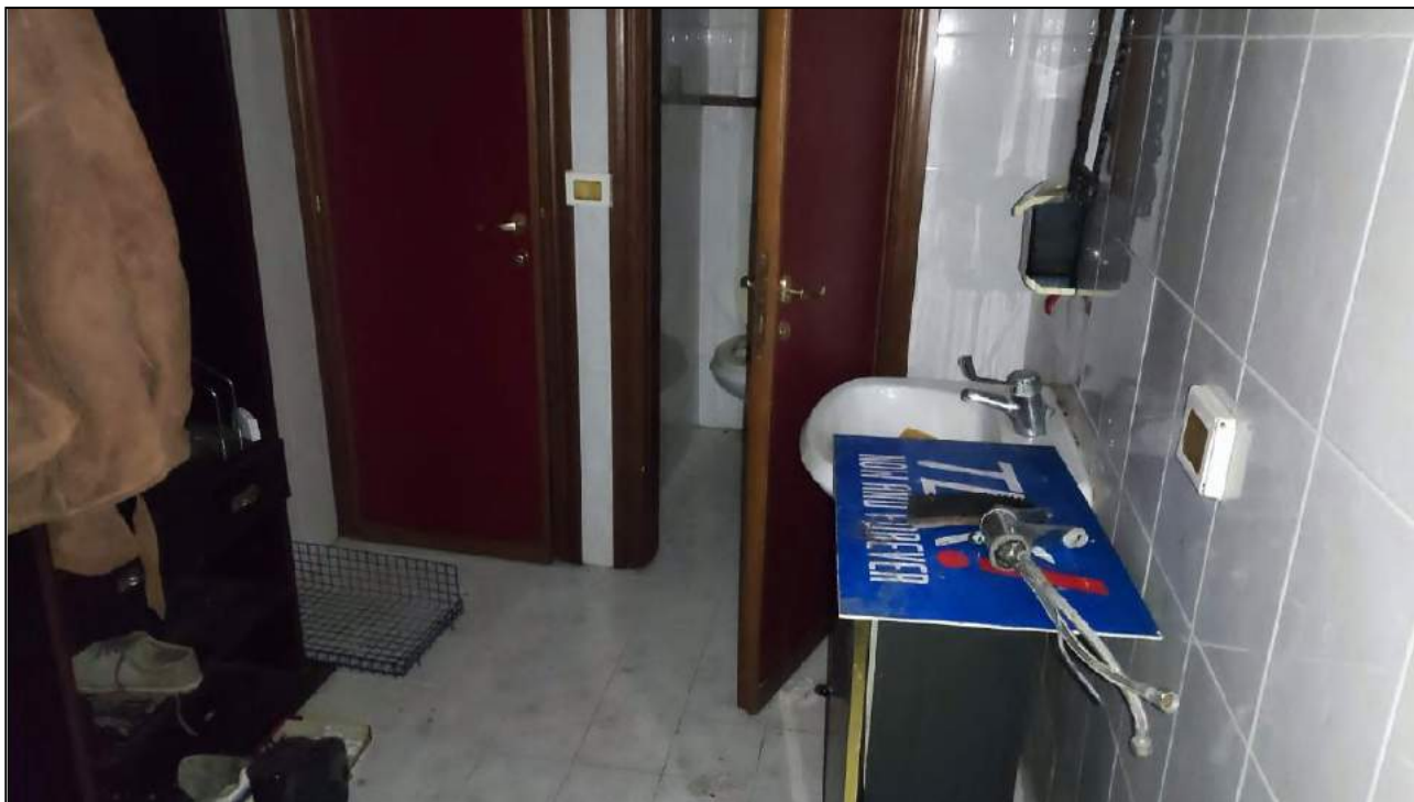
Vista Interna - Servizio Igienico n°4
