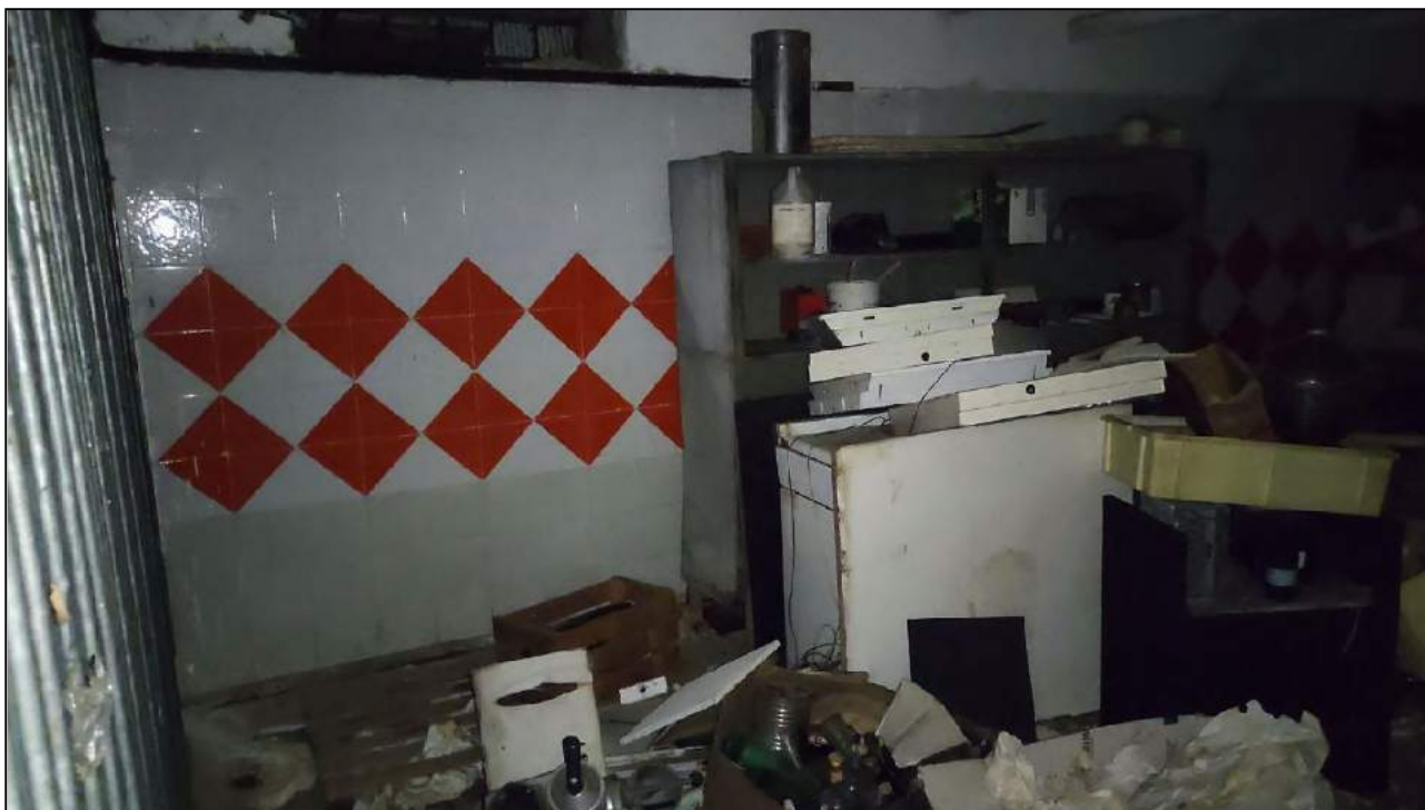
Vista Interna - Magazzino Piano Interrato
