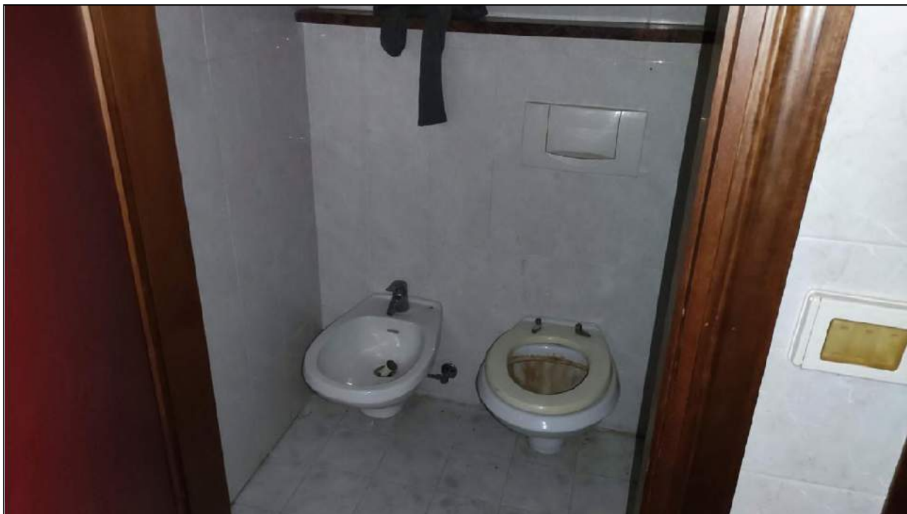
Vista Interna - Servizio Igienico n°3
