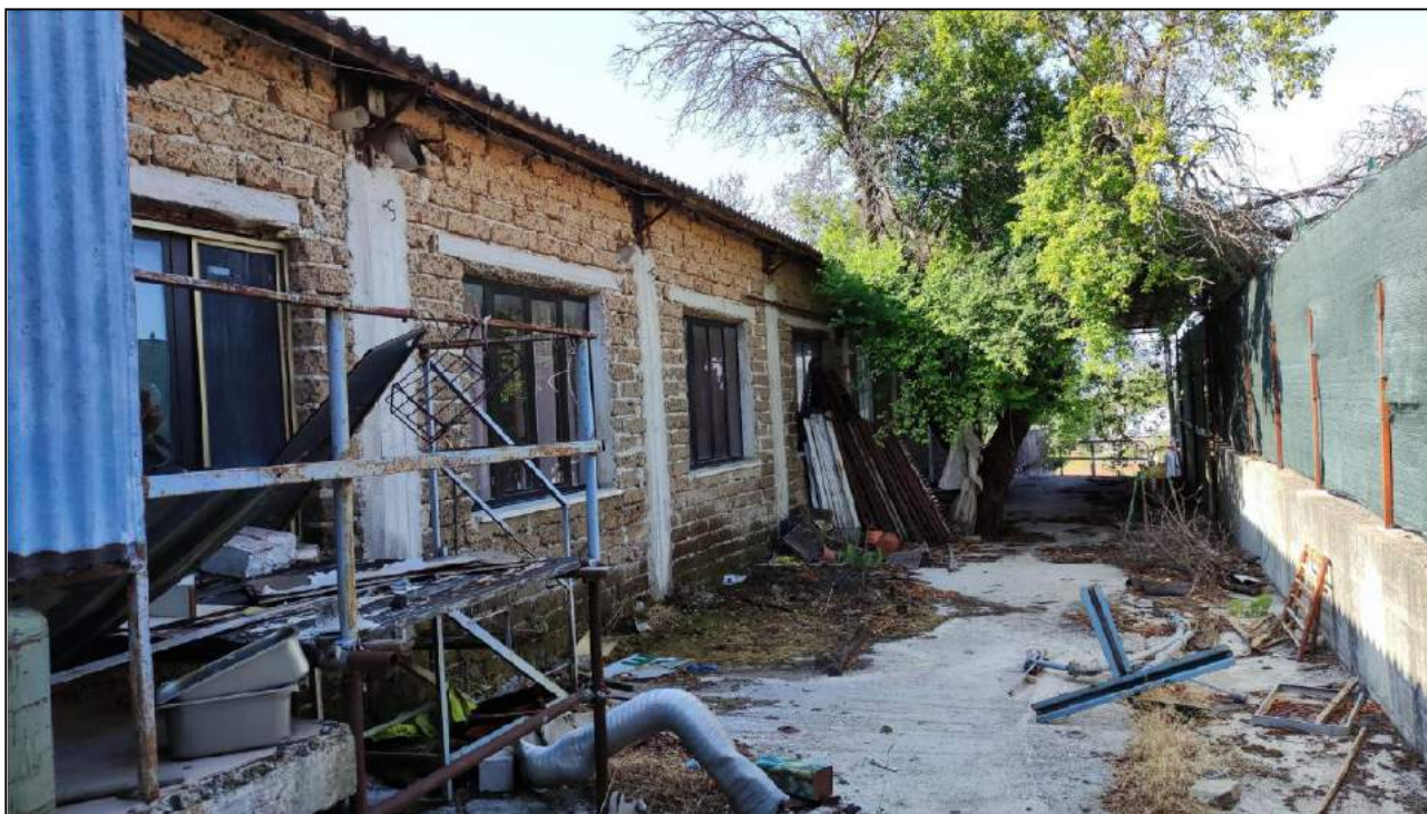
Vista Prospetto Nord-Ovest
