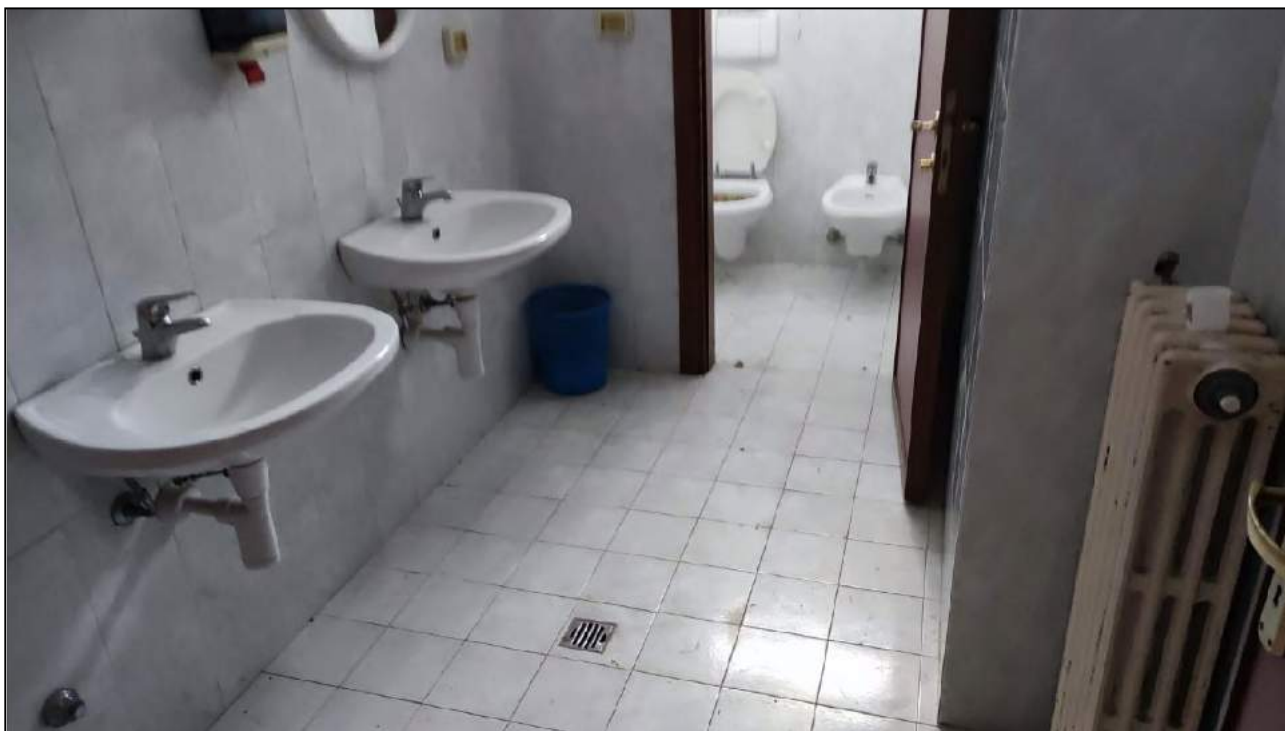
Vista Interna - Servizio Igienico n°2
