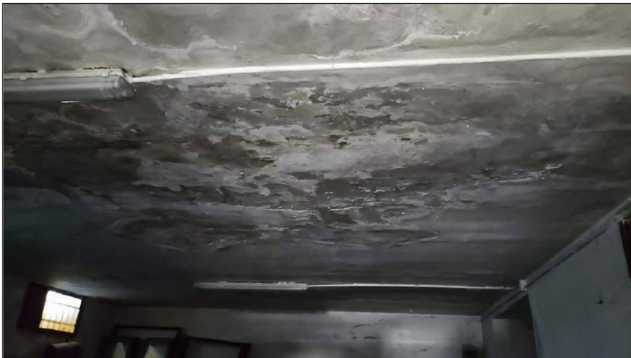
Vista Interna - Locali di Sgombero Piano Interrato
