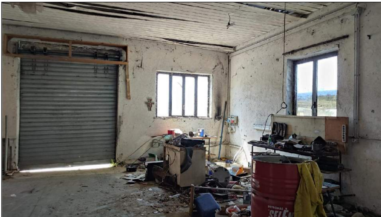
Vista Interna - Dispensa e Locali accessori ristorante
