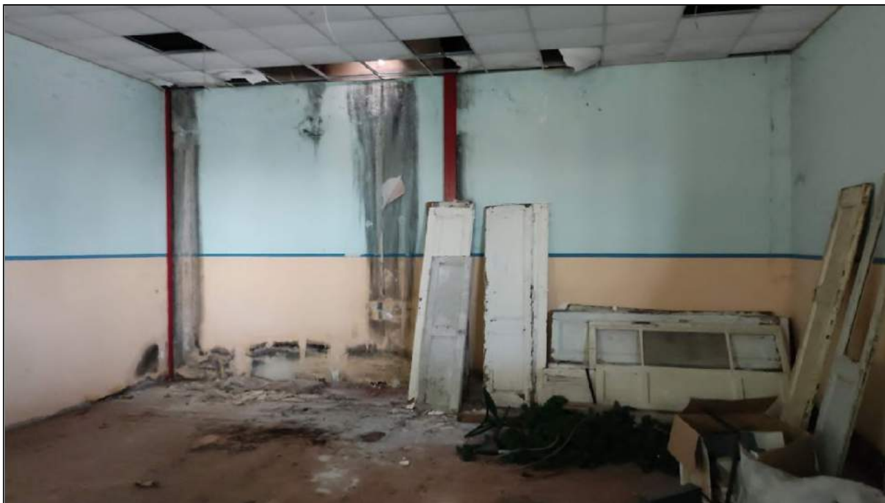
Vista Interna - Dispensa e Locali accessori ristorante
