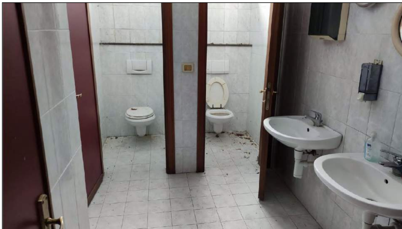
Vista Interna - Servizio Igienico n°1
