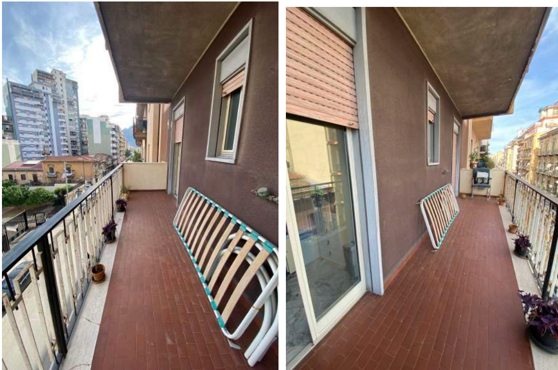
Foto n. 15, 16, 17 e 18: balconi su atrio interno e su via Oreto
