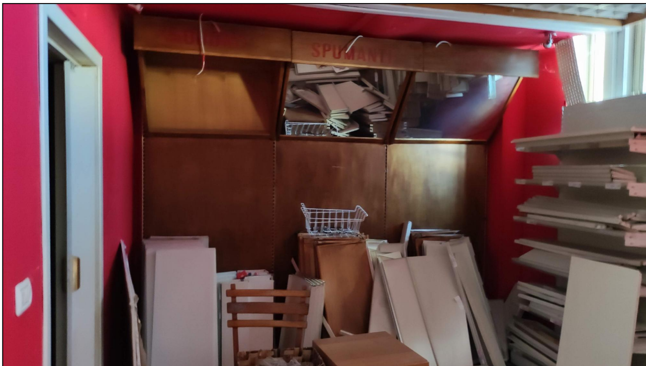
Vista Interna - Negozio
