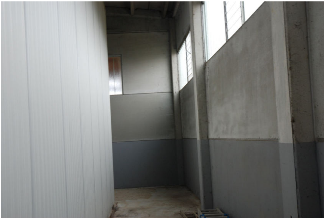
Fot. 10 - Vista del corridoio interno che conduce alla parte posteriore. A sinistra la cella frigorifera.
