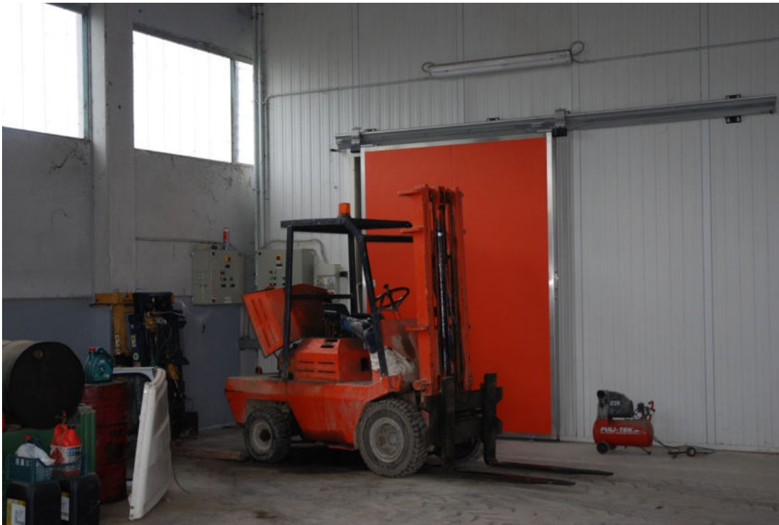
Fot. 9 - Vista dell'interno del capannone agricolo. Si denota con la porta rossa l'ingresso alla cella frigorifera.
