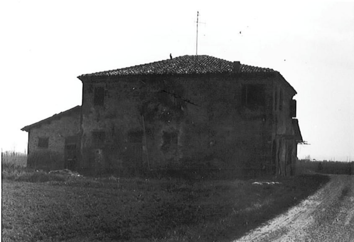
Fot. 12 - Foto del fabbricato colonico del 1980. Vista tergale.
