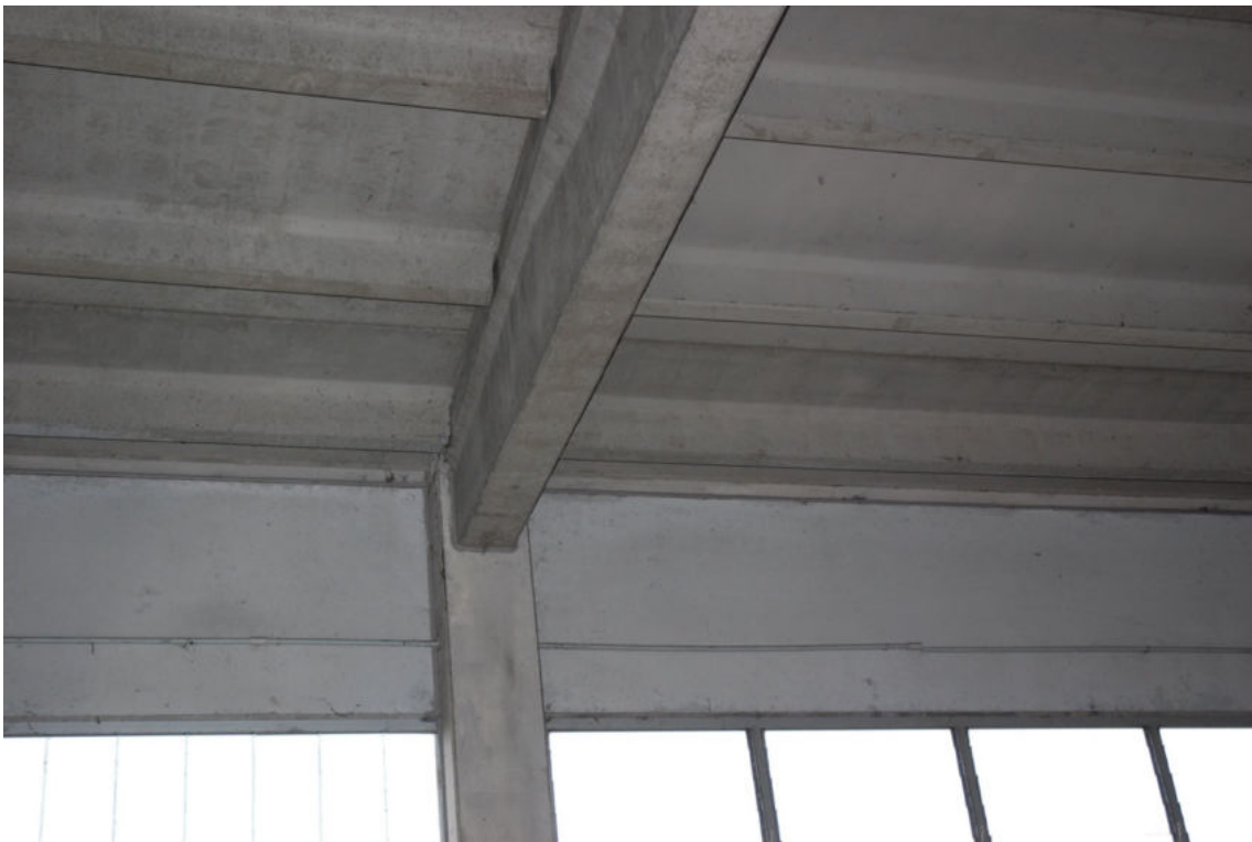
Fot.8 - Dettagli costruttivi del capannone.
