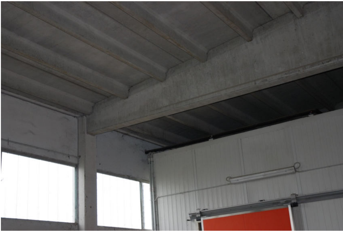
Fot. 7 - Dettagli costruttivi del capannone.
