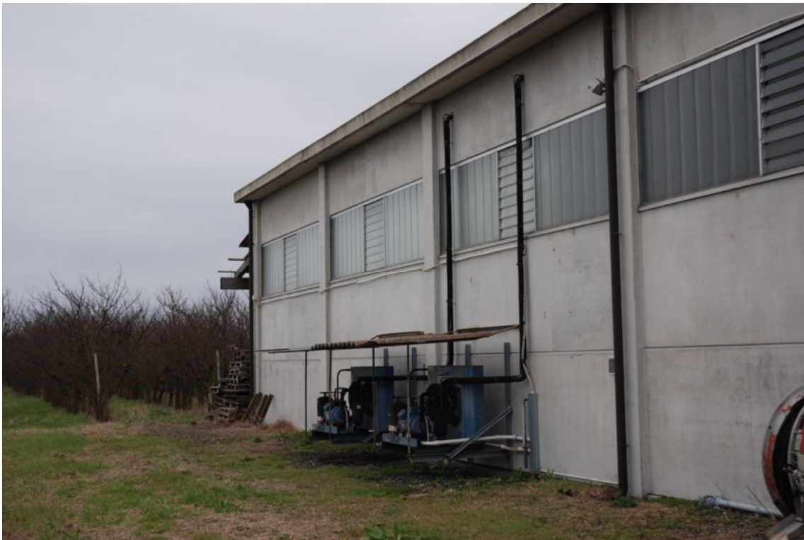
Fot. 5 - Dettaglio della facciata.
