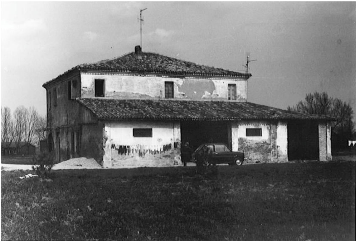
Fot. 11 - Foto del fabbricato colonico del 1980. Vista frontale.
