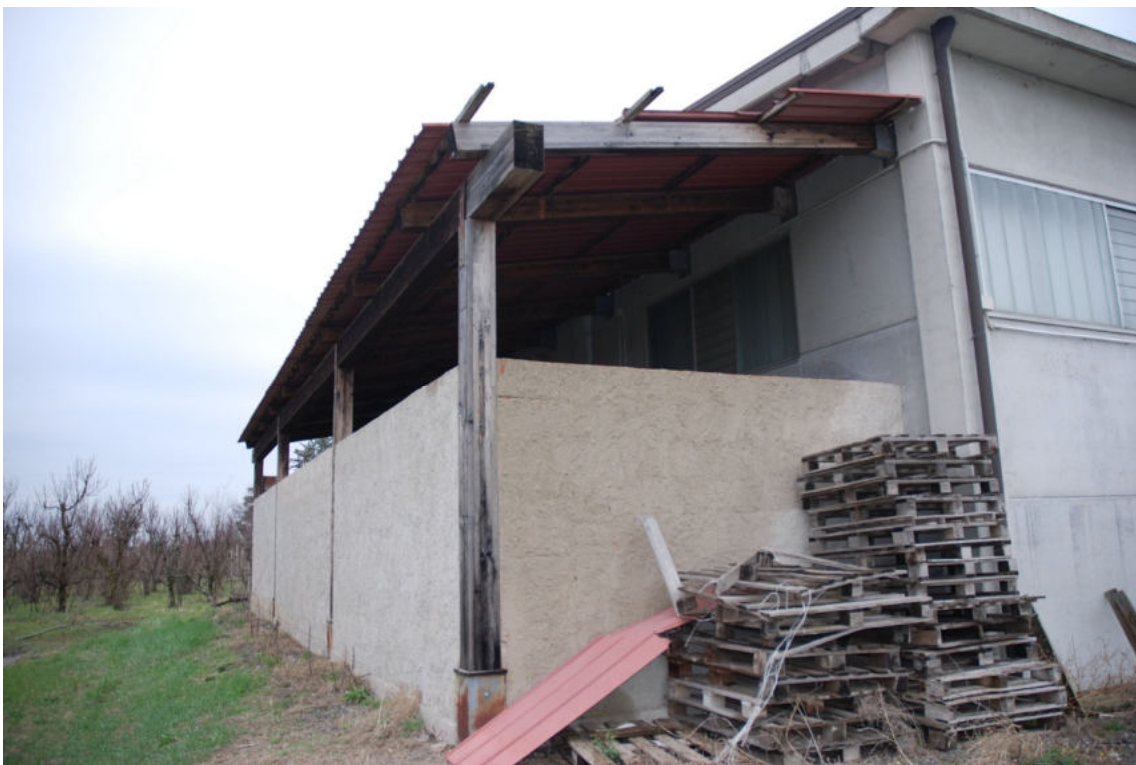
Fot. 6 - Vista posteriore del capannone agricolo.
