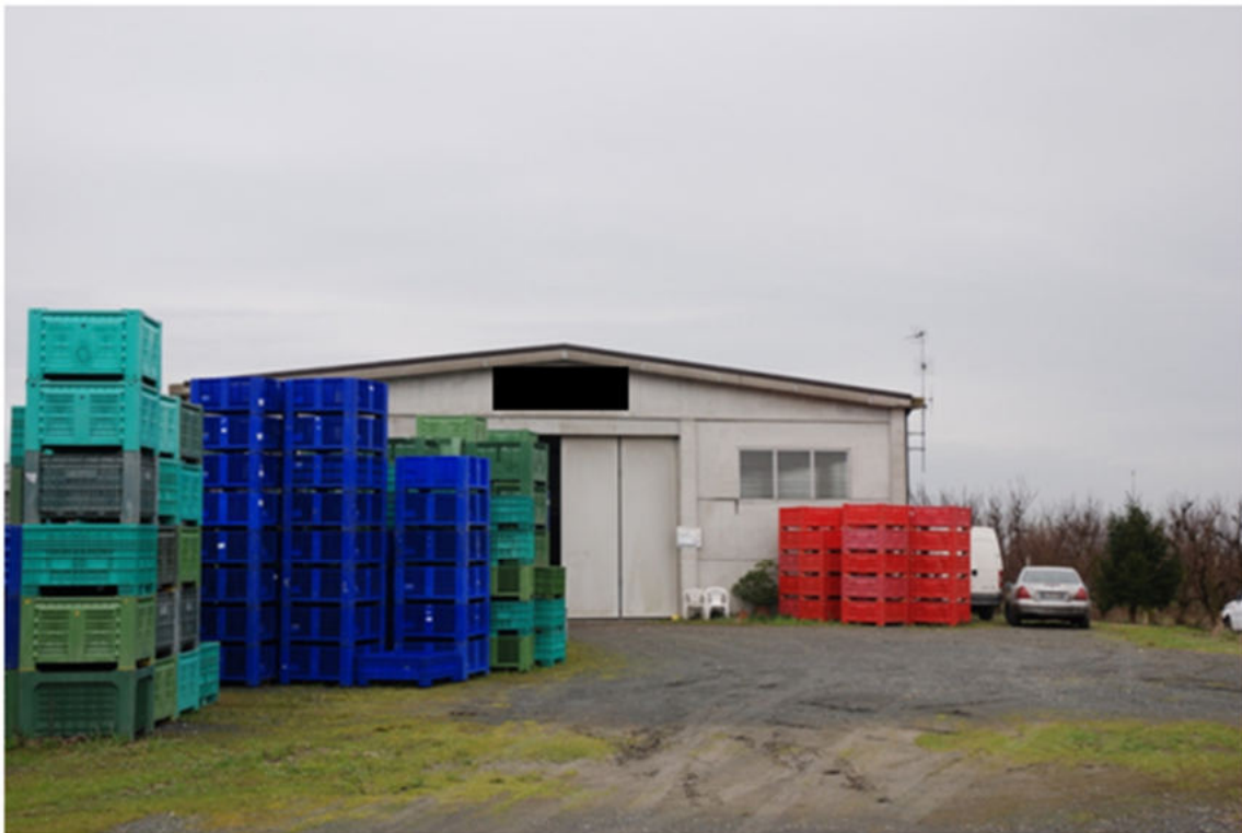
Fot. 3 - Vista dal piazzale di ingresso del capannone agricolo.
