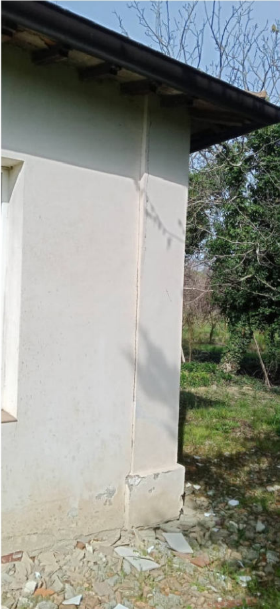
Presenza di lesioni diffuse negli elementi del portico
