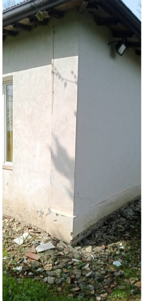
Presenza di lesioni diffuse negli elementi del portico
