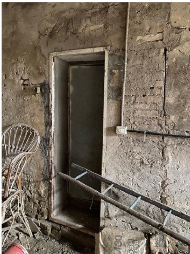
Fabbricato colonico - Evidenti le lesioni e le spinte fuori dal piano resistente
