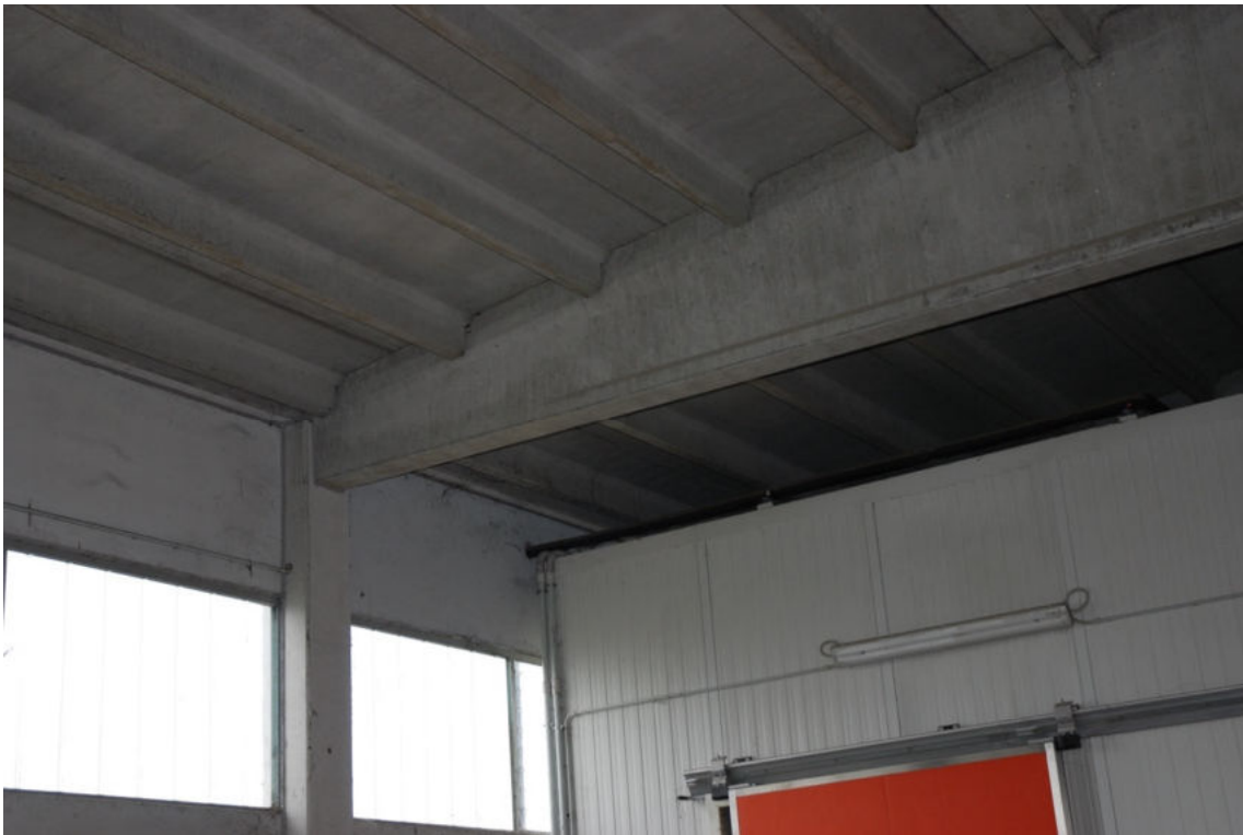
Fot. 7 - Dettagli costruttivi del capannone.
