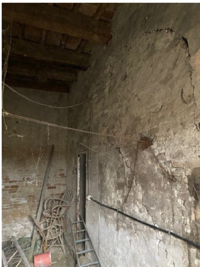
Fabbricato colonico - Evidenti le lesioni e le spinte fuori dal piano resistente
