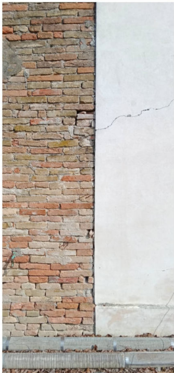
Assenza di giunto edificio - portico / Lesioni e cedimenti nel corpo del portico perimetrale alla casa colonica
