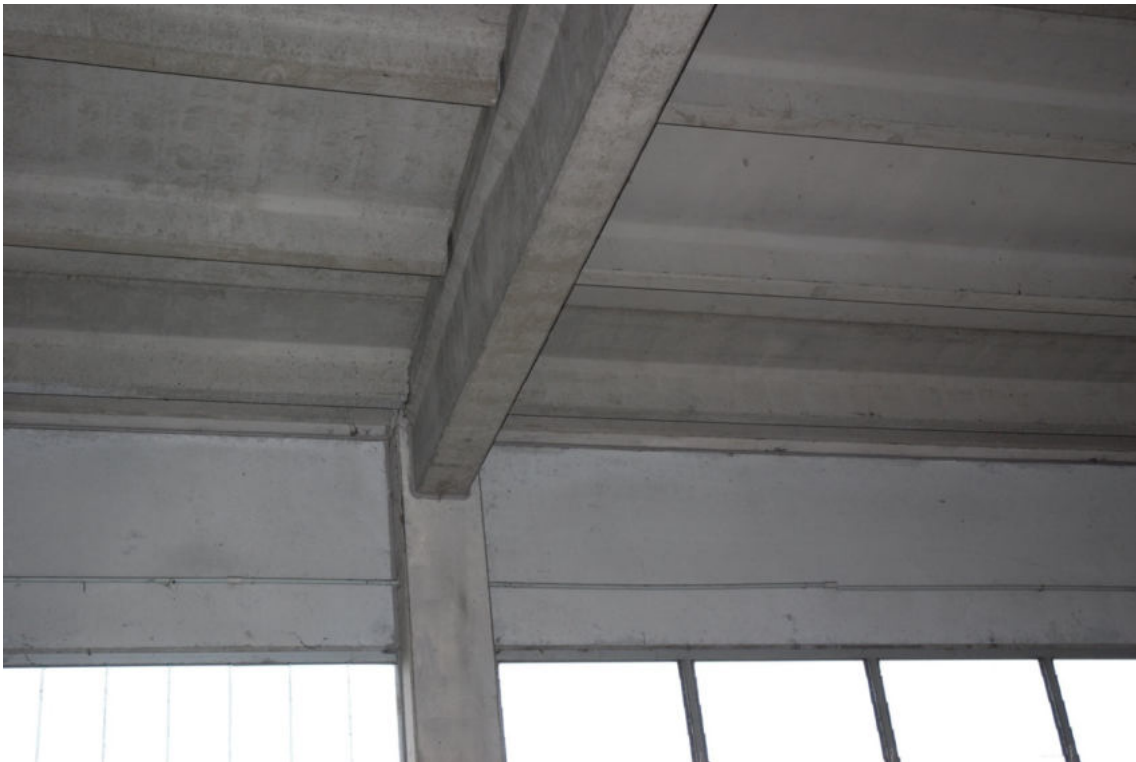
Fot.8 - Dettagli costruttivi del capannone.
