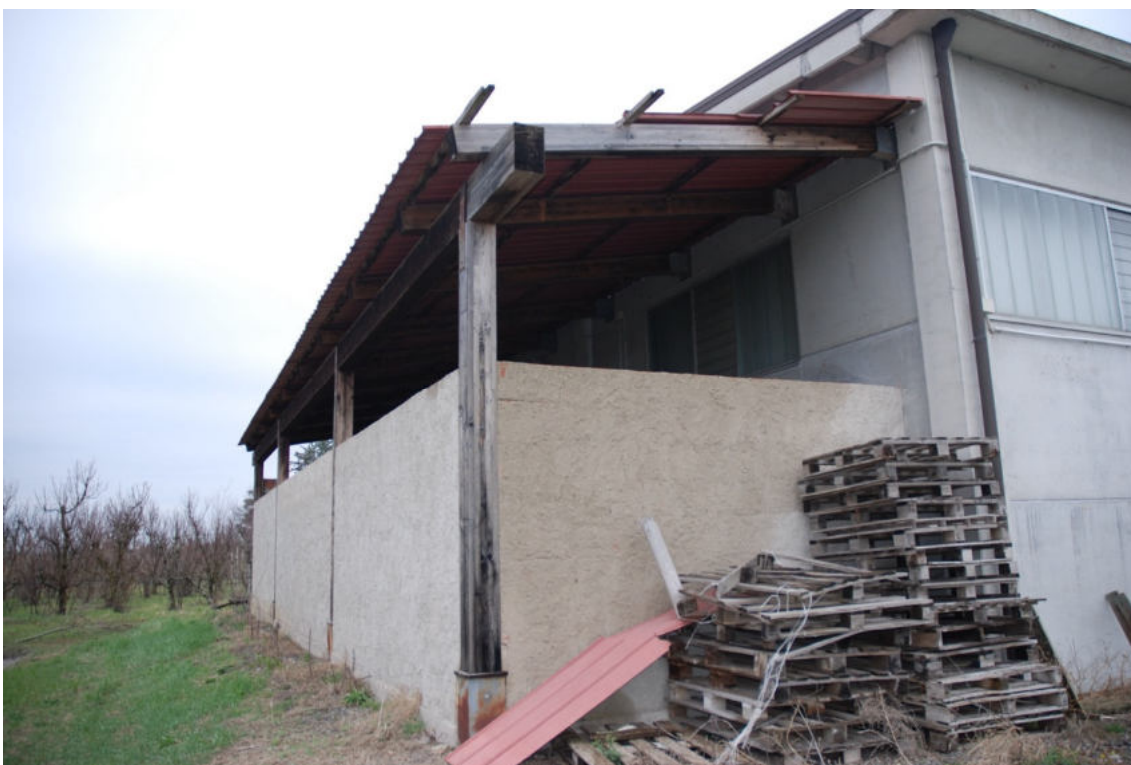
Fot. 6 - Vista posteriore del capannone agricolo.
