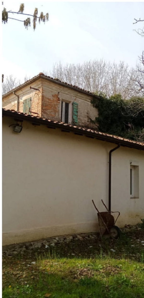
Assenza di giunto edificio - portico / Lesioni e cedimenti nel corpo del portico perimetrale alla casa colonica
