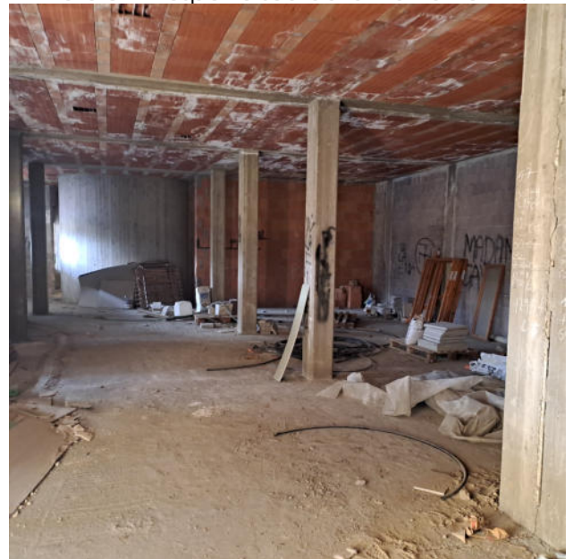
Foto 10 - Locale al piano terreno
