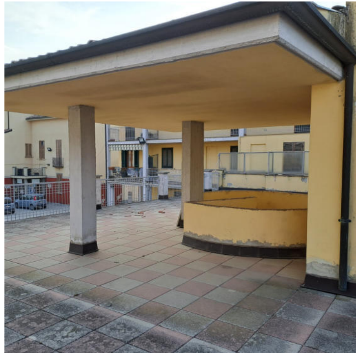
Foto 20 – Pensilina di copertura del vano scala
