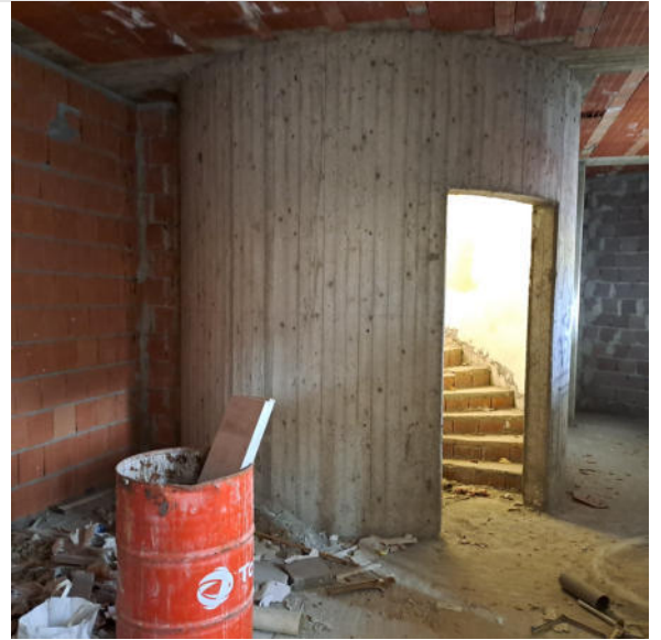
Foto 14 – Scala di collegamento al piano cantina a primo piano
