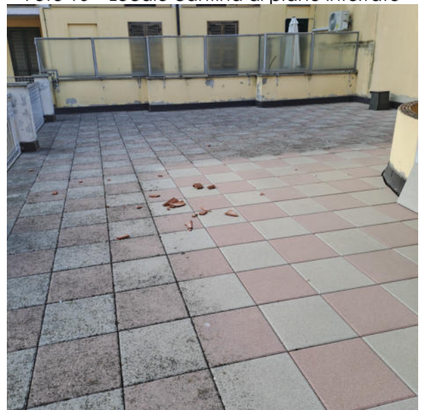
Foto 18 – Terrazzo al piano primo – Lato ovest
