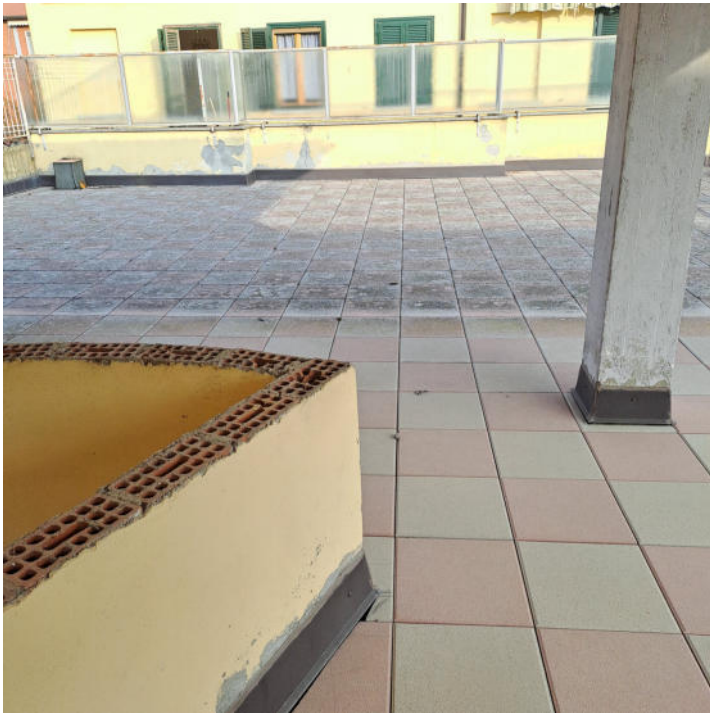
Foto 19 – Terrazzo al piano primo – Lato est
