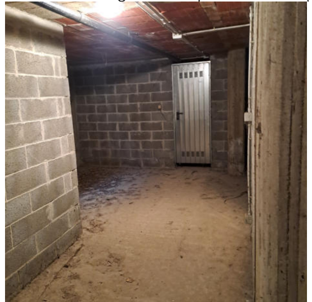
Foto 16 – Locale cantina al piano interrato
