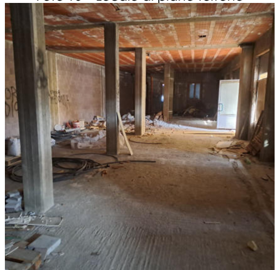
Foto 12 - Locale al piano terreno
