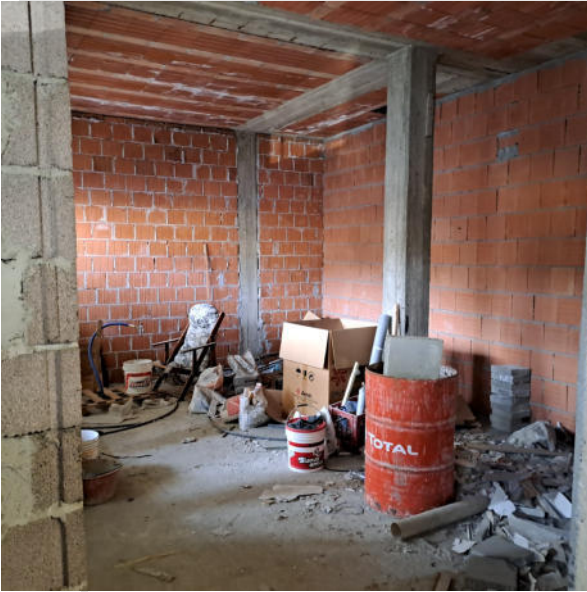
Foto 13 – Locale al piano terreno
