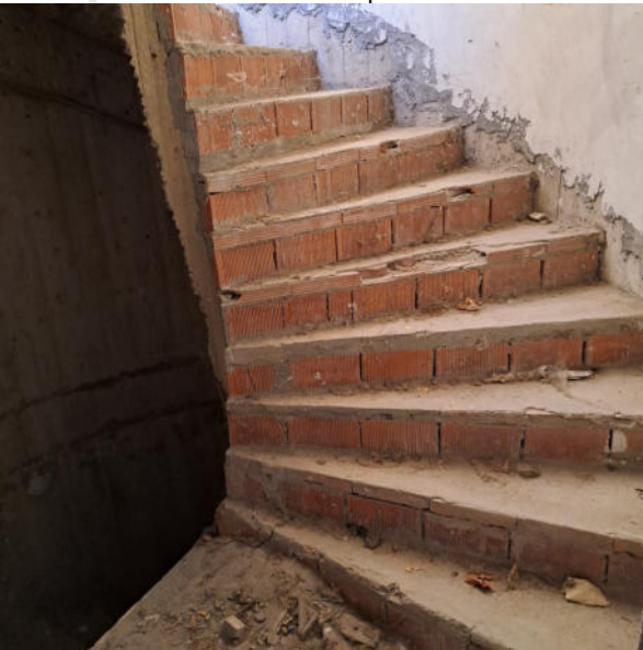
Foto 15 – Scala in c.a. al piano terra
