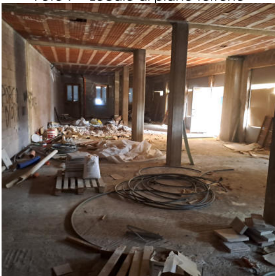
Foto 11 - Locale al piano terreno
