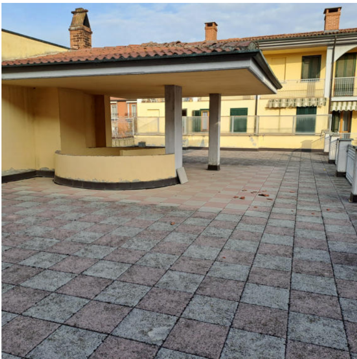
Foto 21 – Pensilina di copertura del vano scala
