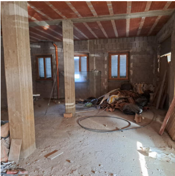
Foto 9 - Locale al piano terreno
