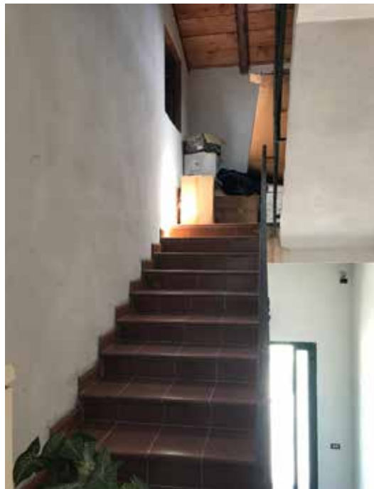
Foto 29. Corpo scala che consente l'accesso al sottotetto.
