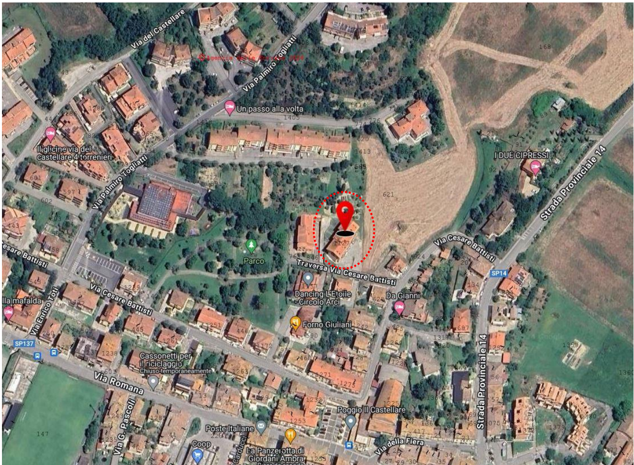
1. vista inquadramento aereo del complesso pignorato
