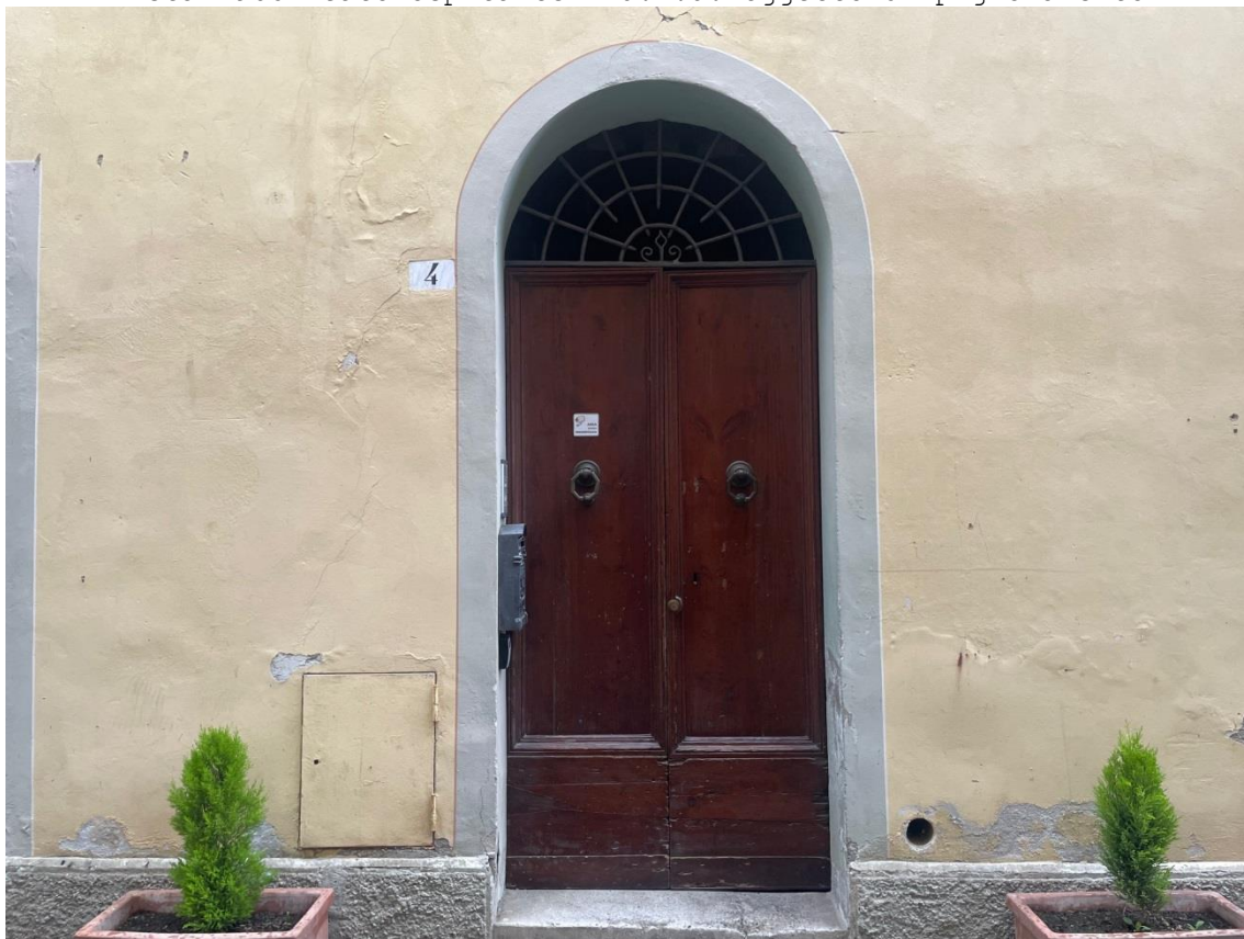
Vista accesso portone a comune civico n.4
