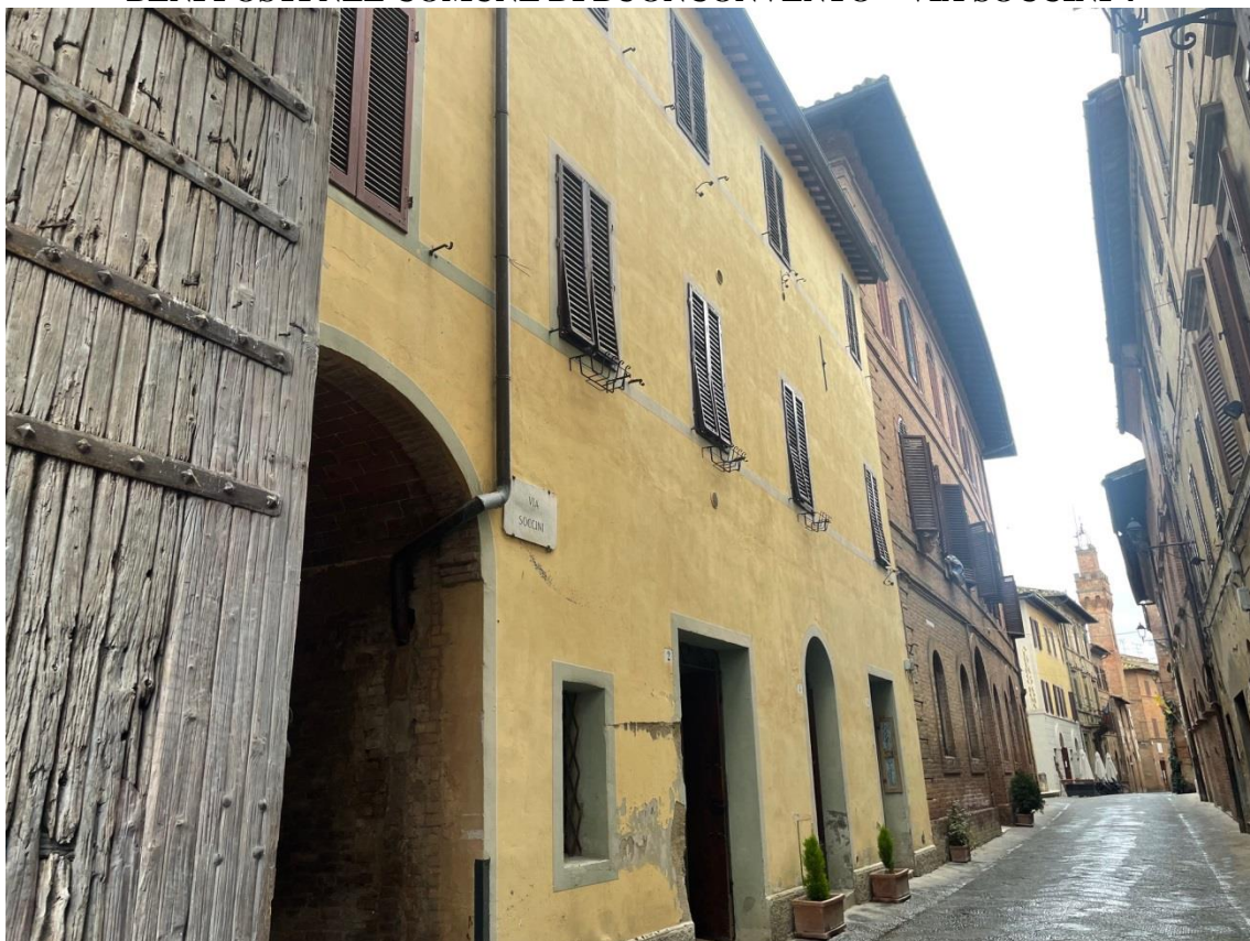
Vista fabbricato ospitante l'u.i.u. oggetto di pignoramento
