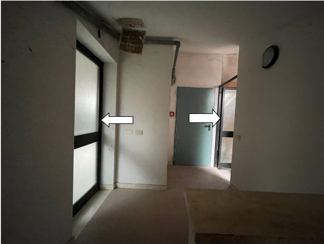
Vista dei due accessi al locale magazzino
