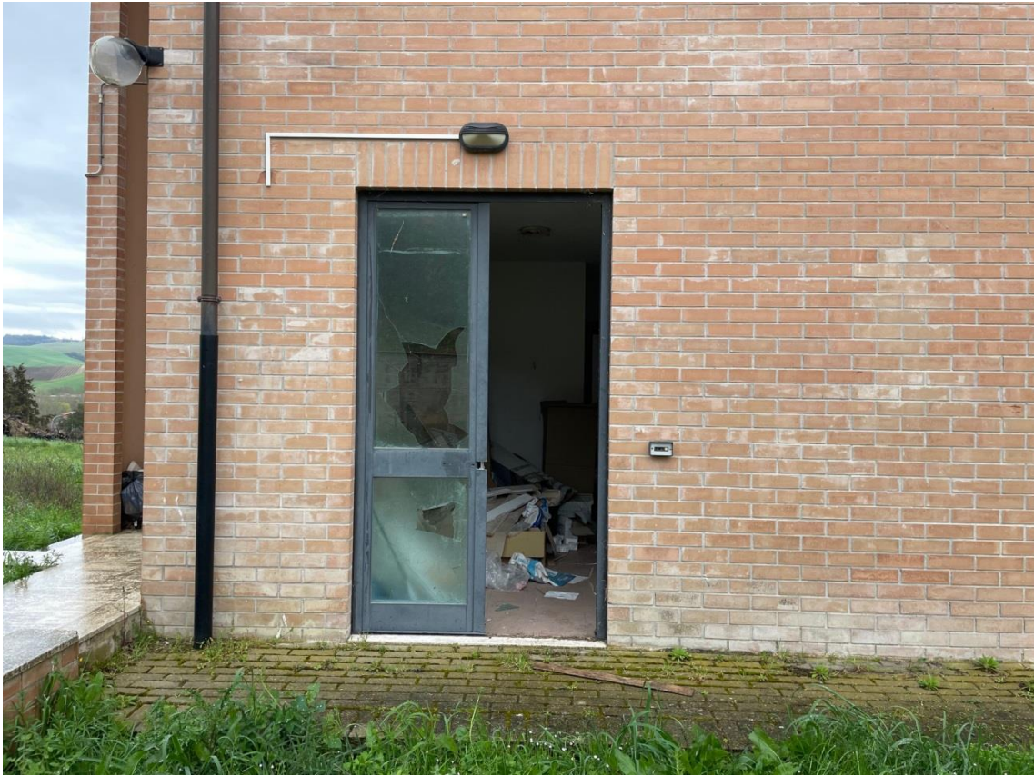
Vista ingresso u.i.u. sub 13 -appartamento
