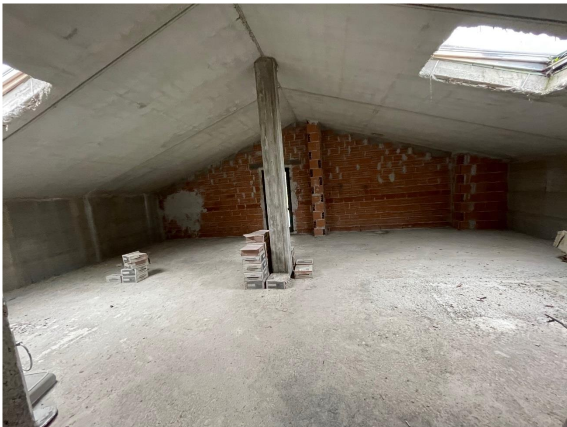
Vista locale sottotetto
