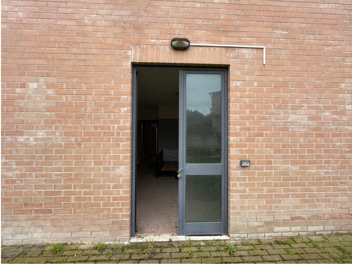
Vista accesso principale u.i.u. sub 12- p.t.
