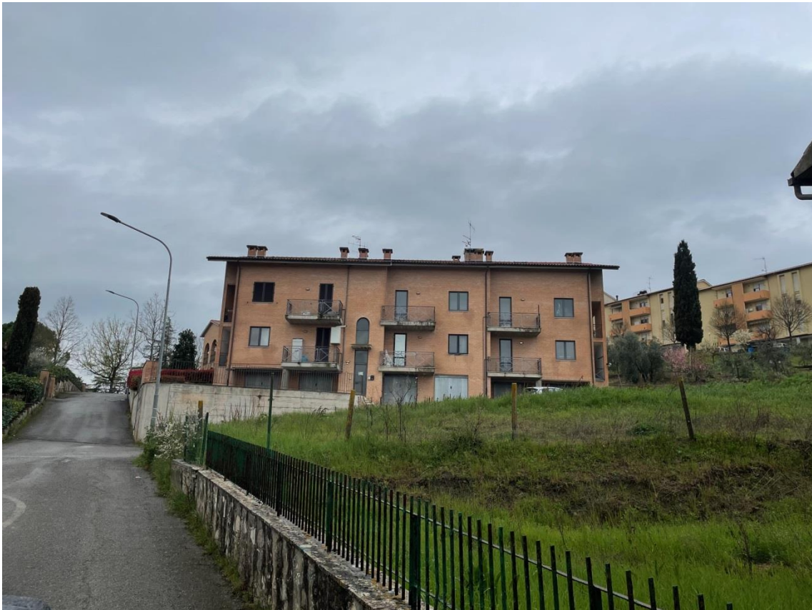
Vista frontale complesso immobiliare ospitante le u.i.u. oggetto di pignoramento
