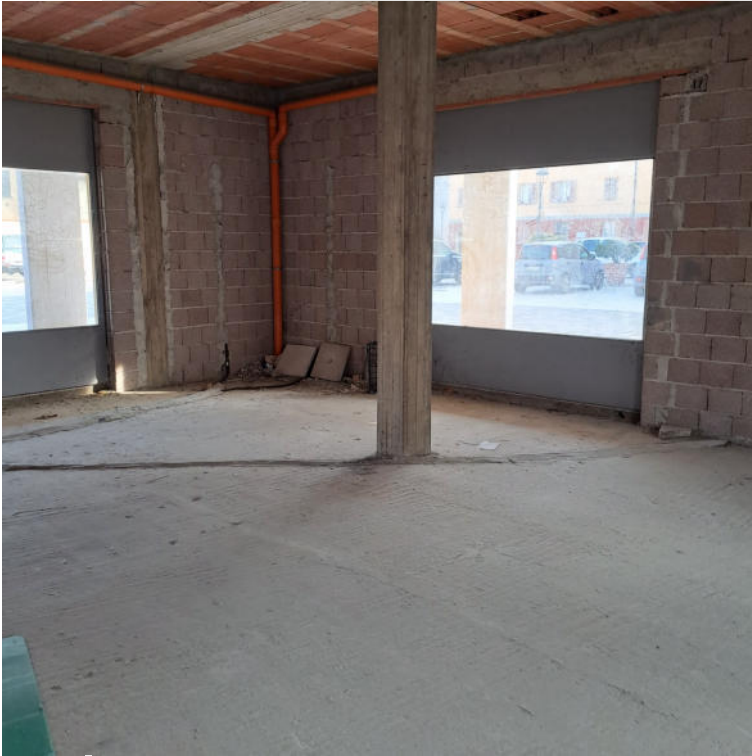
Foto 7 – Locale interno al sub 44 – Piano terra
