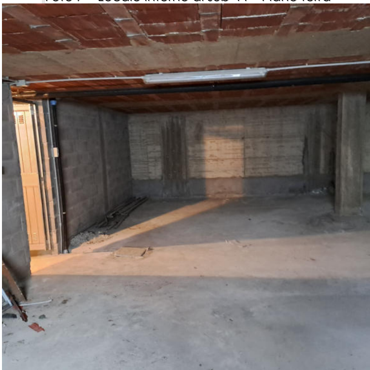
Foto 9 – Locale al sub 44 al piano interrato
