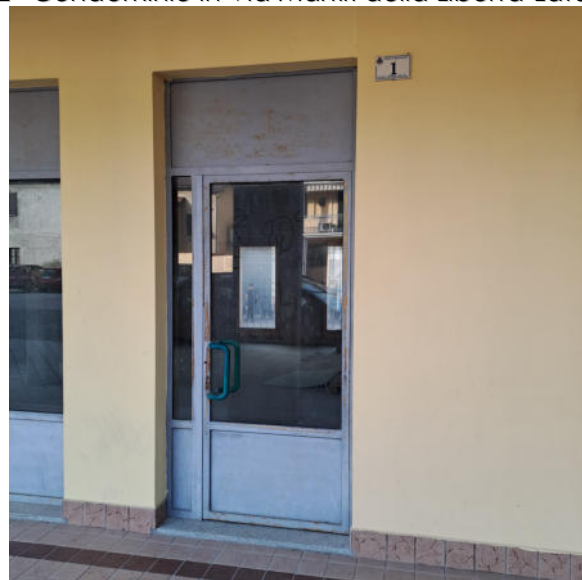
Foto 4 – Porta d'ingresso al sub 44 –Lato est
