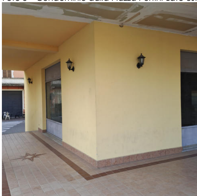
Foto 5 – Vetrina del locale al sub 44 –Lato sud
