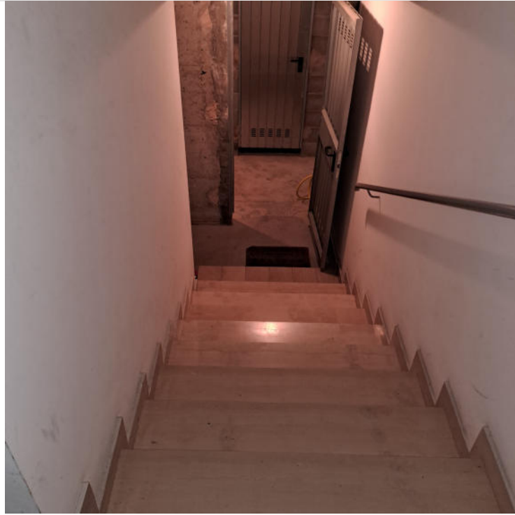
Foto 8 – Scala di accesso al locale interrato del sub 44
