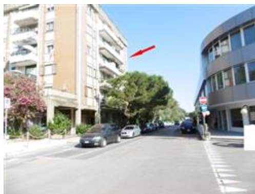
Zona di inserimento edificio condominiale
