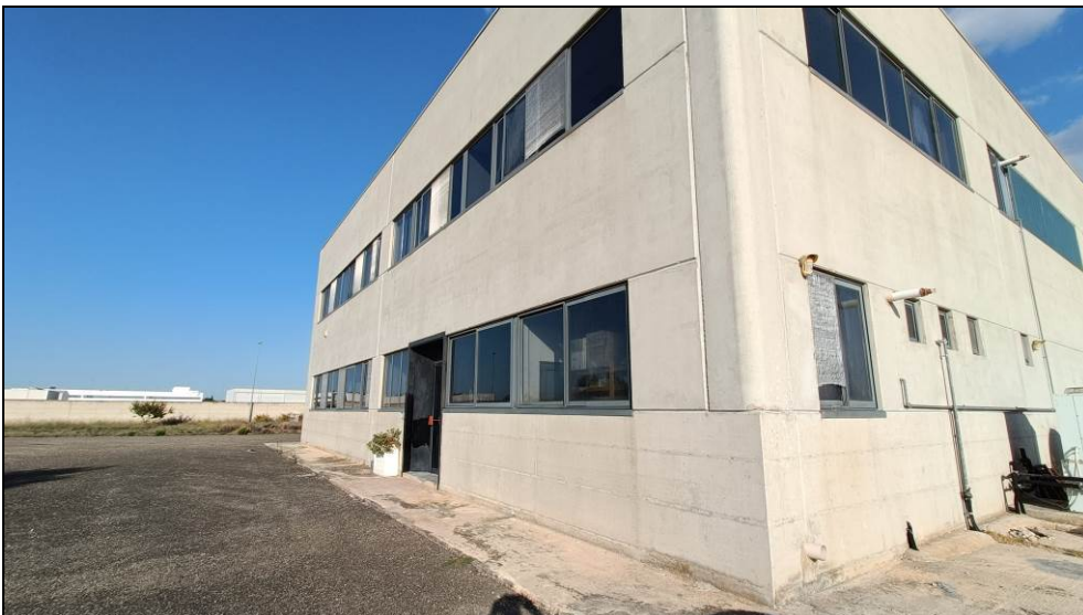
Foto 8 – Prospetto Principale Accesso Uffici/Esposizione
