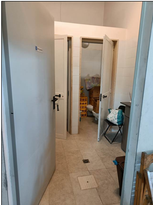
Foto 12 – Locali di servizio Piano Terra
