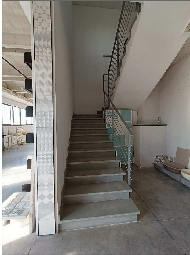
Foto 17 – Vano scala Piano Terra
