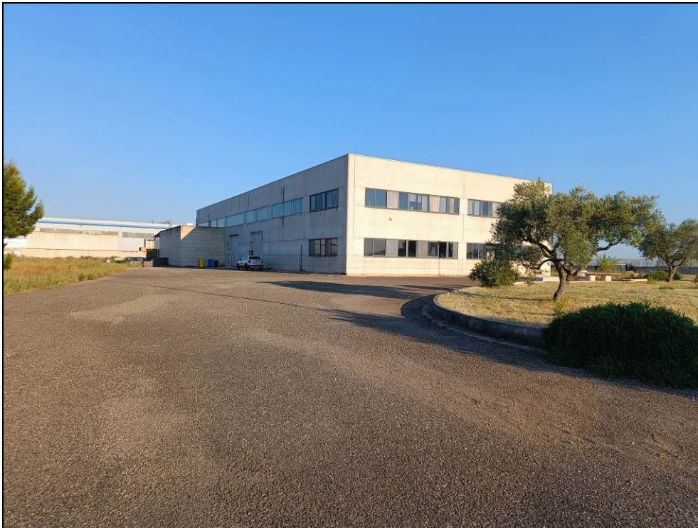
Foto 2 – Viabilità interna di Accesso
