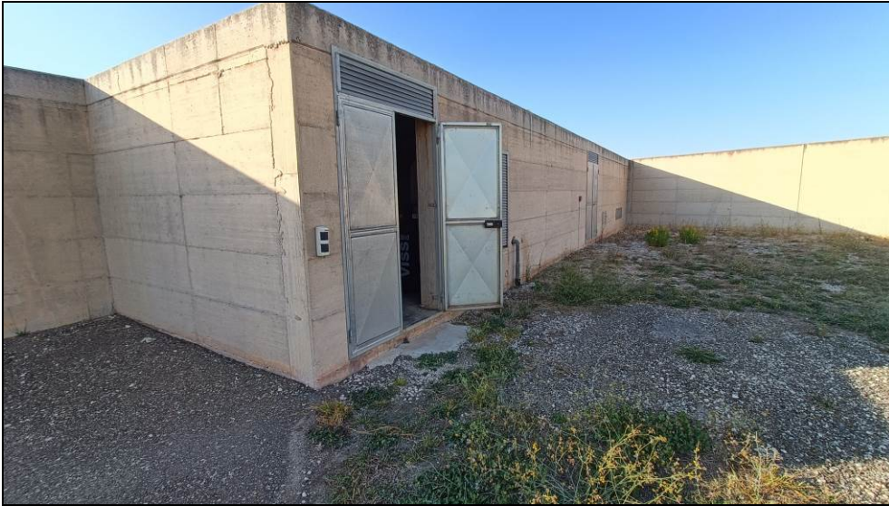
Foto 7 – Locali Servizi Impianti
