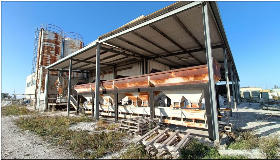
Foto 5 – Tettoia esterna in metallo
