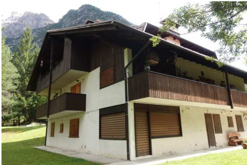
Vista fabbricato da sud-ovest
