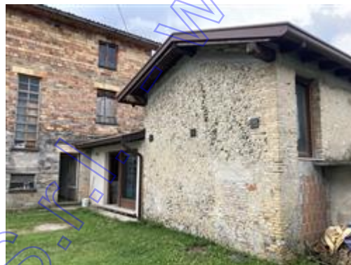
vista esterna corpo accessorio
