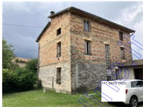
vista esterna dalla corte interna
