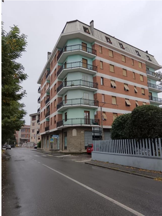
VISTA DA LUNGO FIUME LATO NORD OVEST
