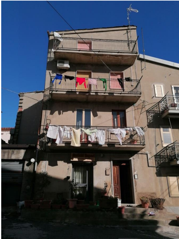
Esterno Prospetto Sud-ovest
