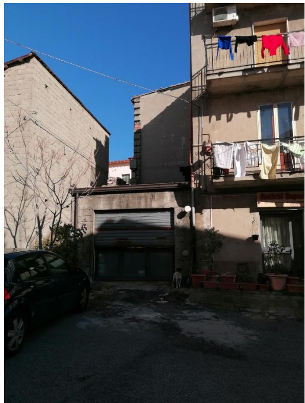
Esterno Prospetto Sud-ovest
