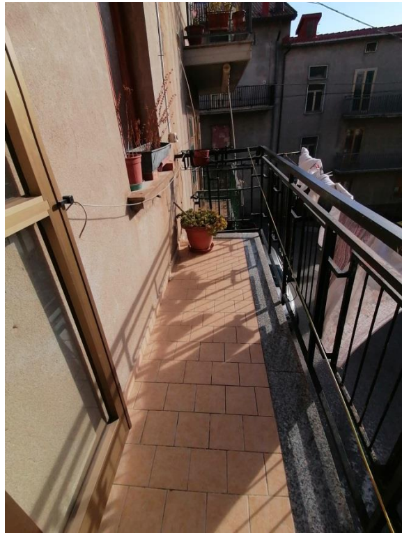
Balcone (piano primo)
