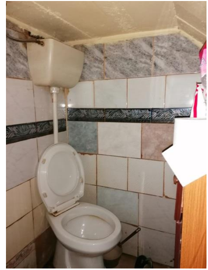
Bagno (piano terra)
