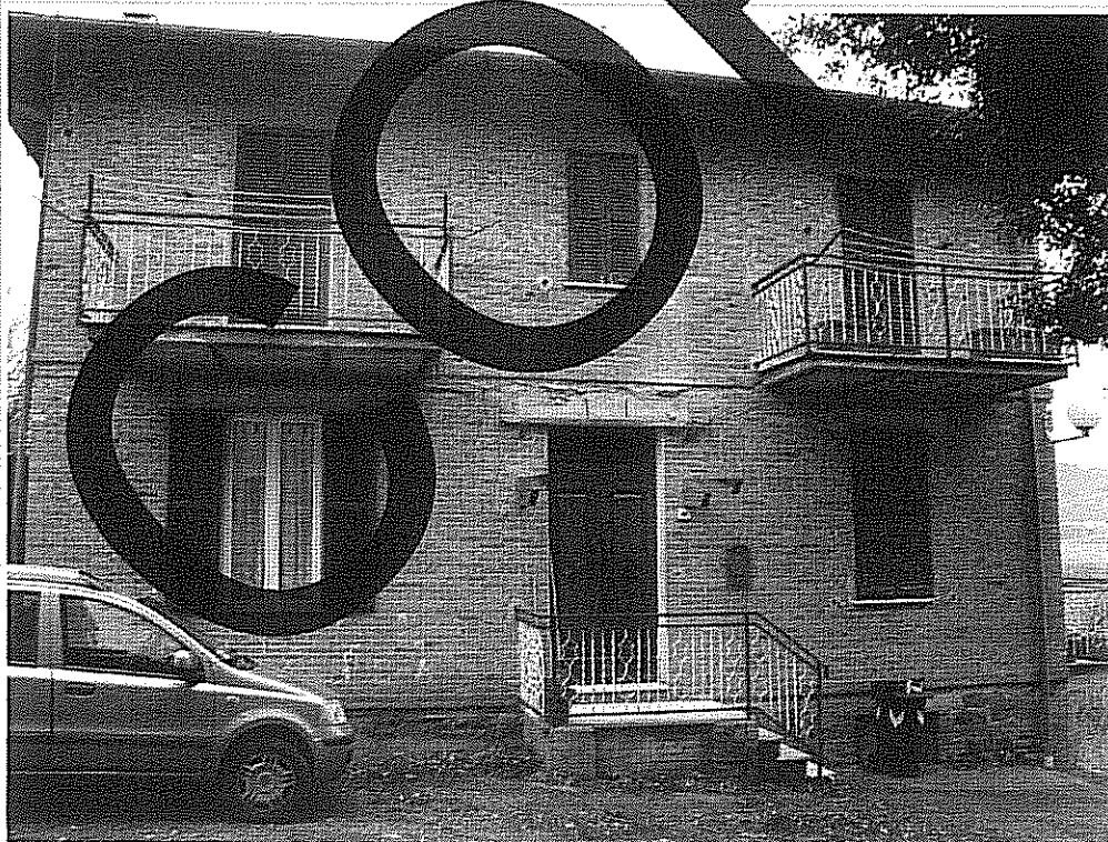
Foto 2. Esterno lato ovest (scala d'accesso e portone in legno).
