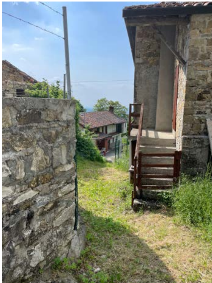
FOTO 2 – Accesso pedonale ai Beni 1 e 2
