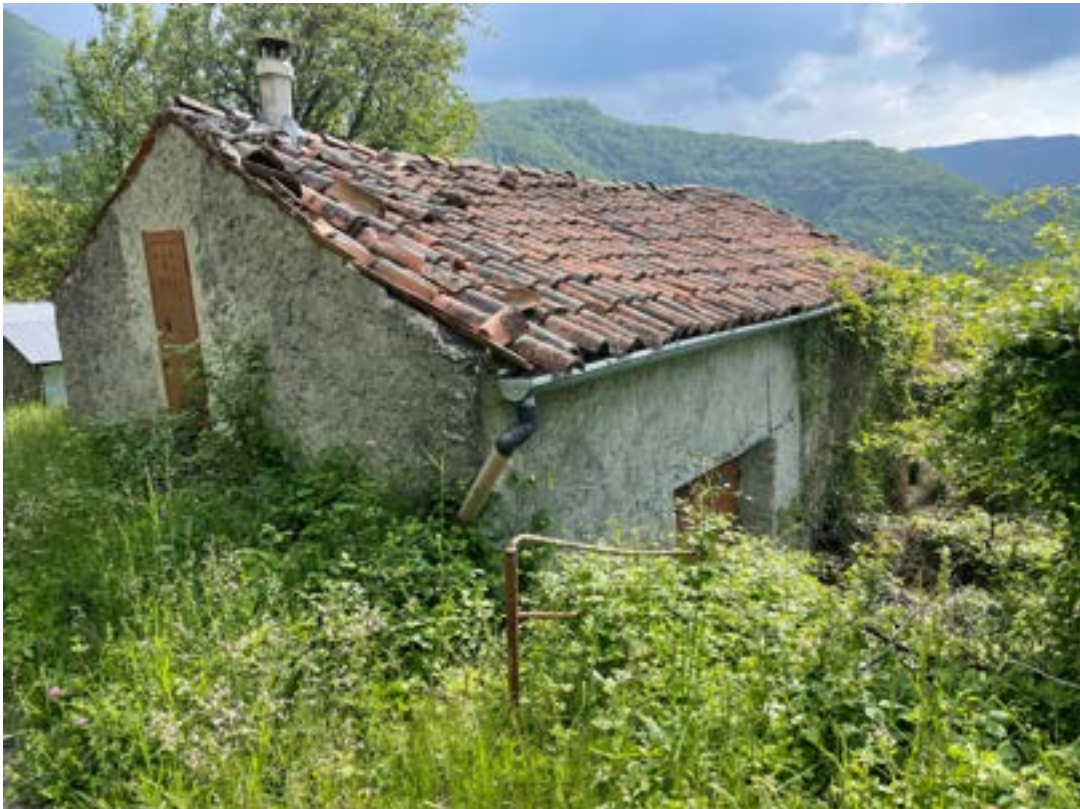
FOTO 25 – Bene 3: scala di accesso
