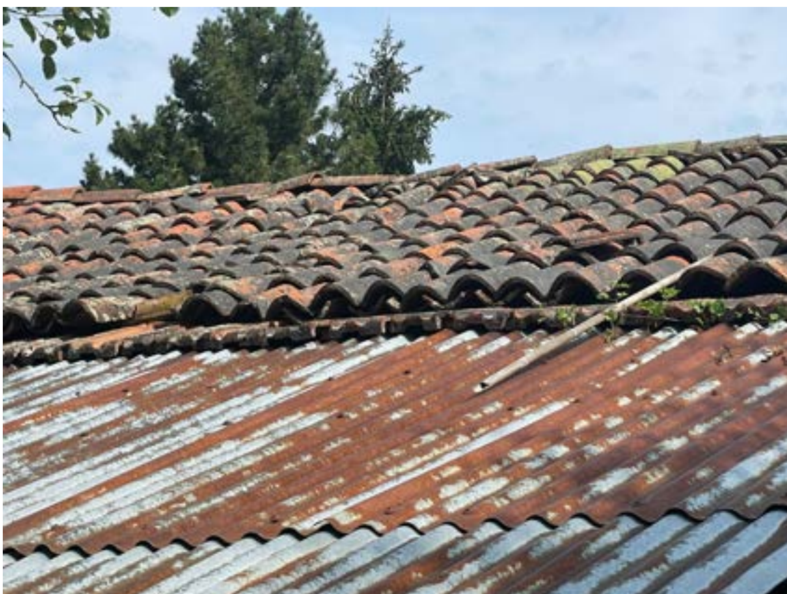
FOTO 29 – Bene 3: dettaglio copertura – avvallamenti e rotture
