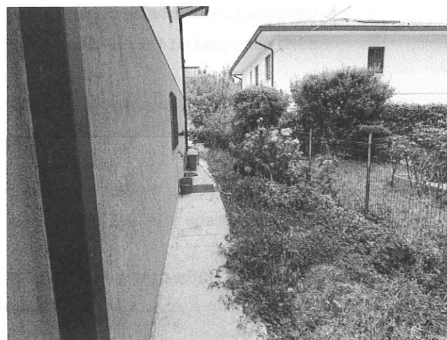
Vista retro edificio – lato nord
