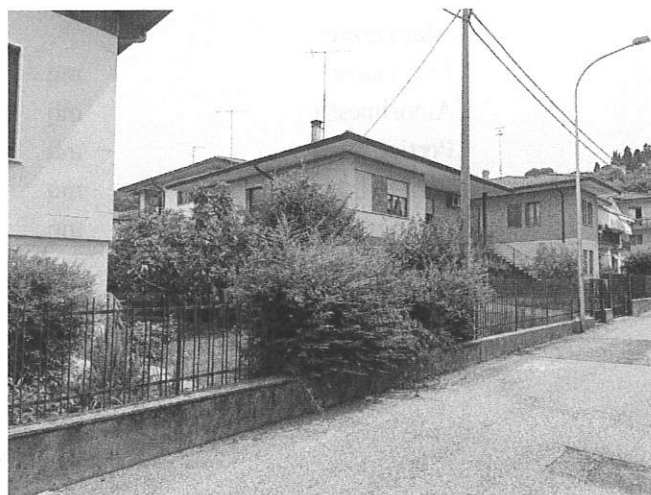
Vista da via A.Fogazzaro – lato sud ovest
