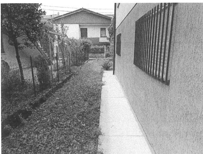
Vista fianco edificio – lato est
