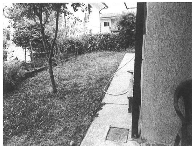
Vista fianco edificio – lato ovest
