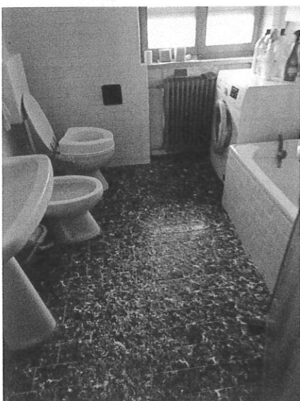
Vista interna bagno piano primo
