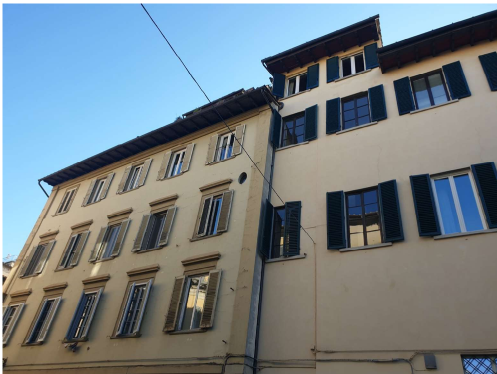
Foto nr. 1 – Facciata principale da Via San Gallo
