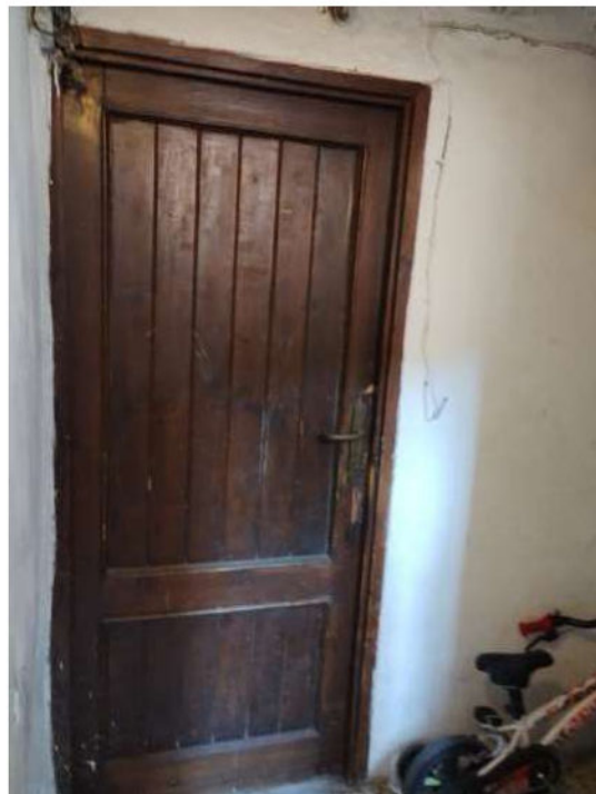
Foto 5 - Ingresso al piano 2°.
