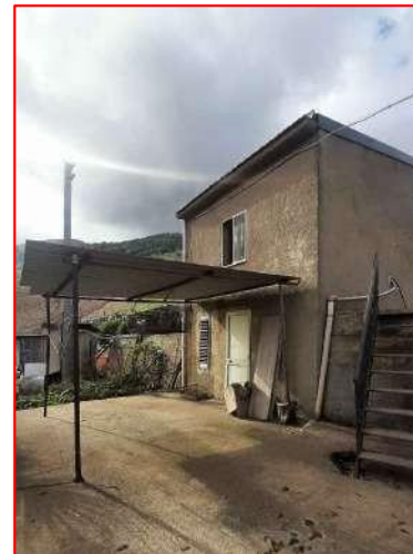
Esterno ingresso dal piano S1
