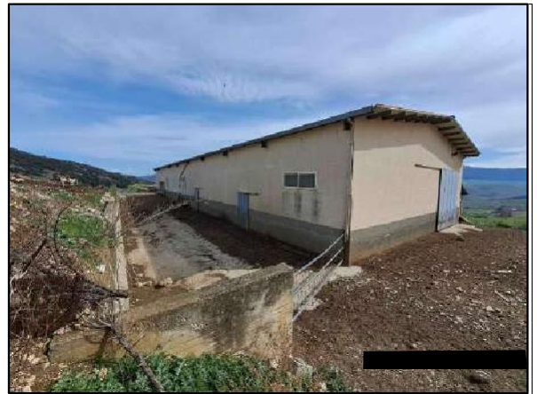
Esterno, vista laterale stalla - 12
