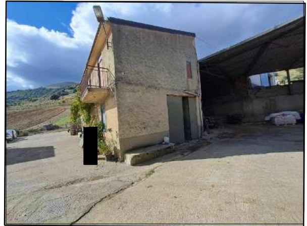
Magazzino 6 ,con soprastante abitazione
