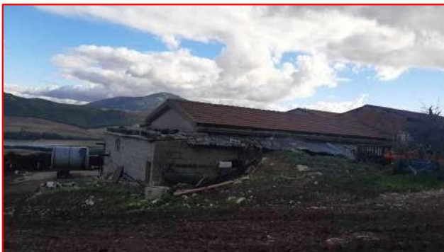
Esterno retrostante magazzino - 3
