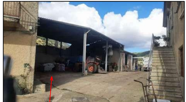
Esterno fienile ingresso principale
