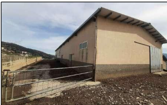
Esterno, vista laterale stalla - 12
