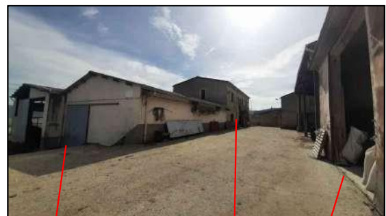
stalle - loc.dep.oggi abitazione - magazzino
